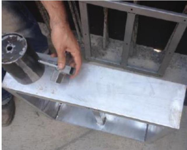
Somente o contra gabarito é fixado nos painéis de forma de paredes. A fixação ocorre com parafusos. A locação dos gabaritos é realizada somente na primeira montagem da forma, pois nas demais somente ocorre o acoplamento na montagem.
