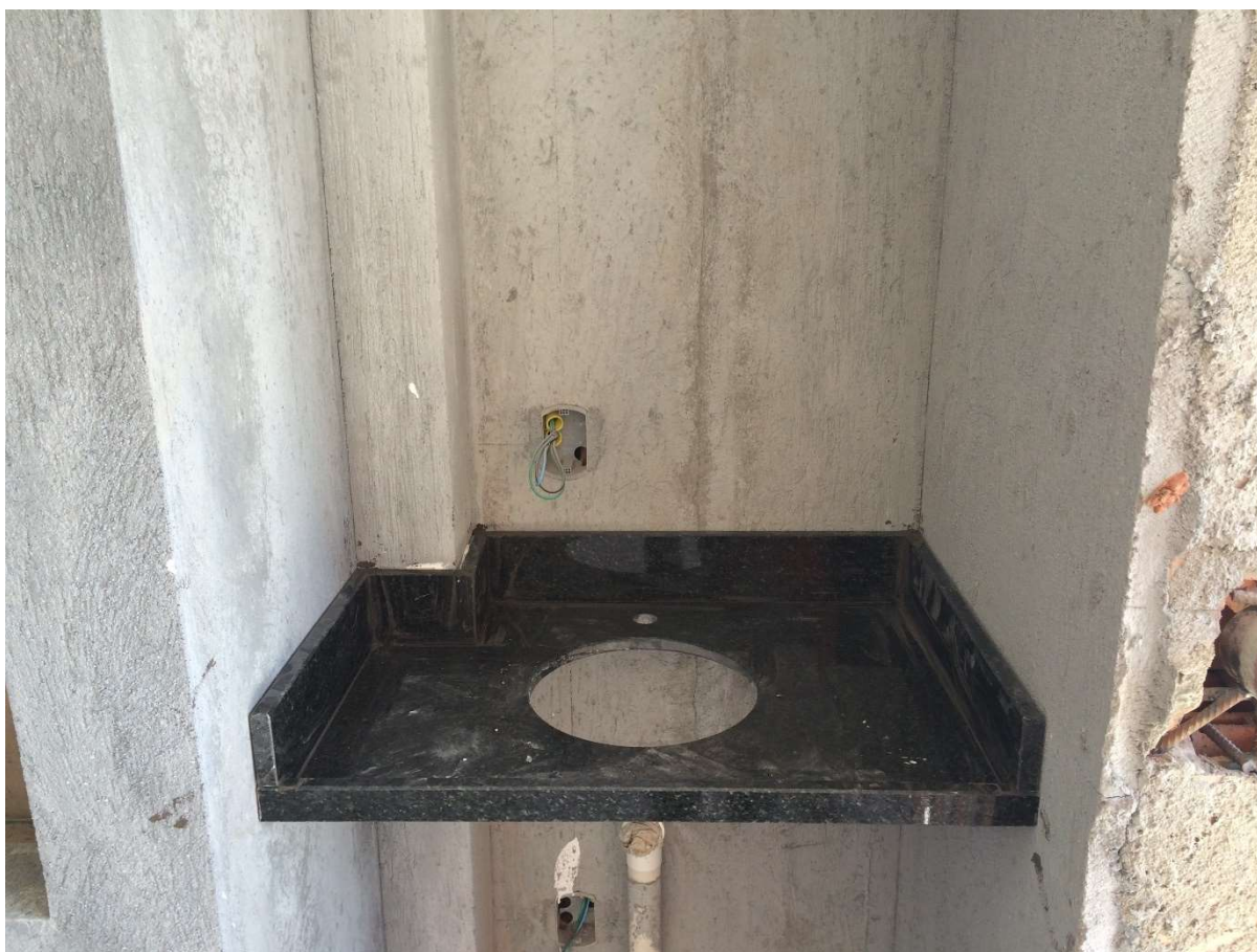
Figura 30 – Foto: Enchimento executado atrás da bancada da churrasqueira
