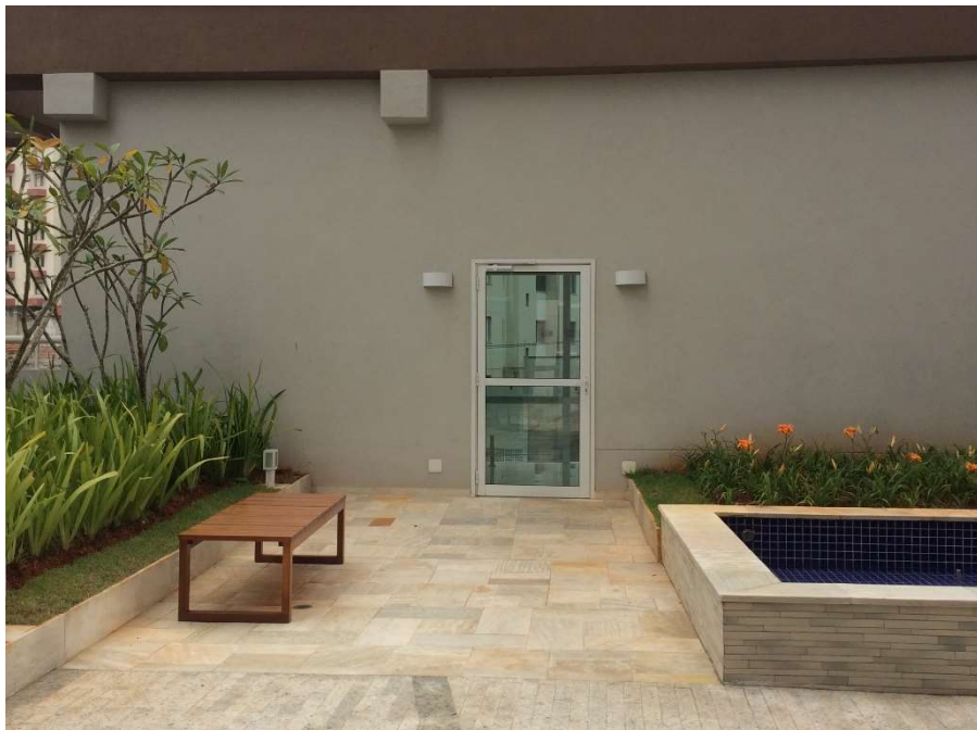
Figura 20 – Foto do acesso ao transfer com a porta de alumínio e vidro executada
