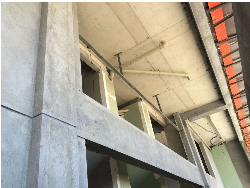
Figura 40 – Fotos: tubo de esgoto área externa e interna fitness
