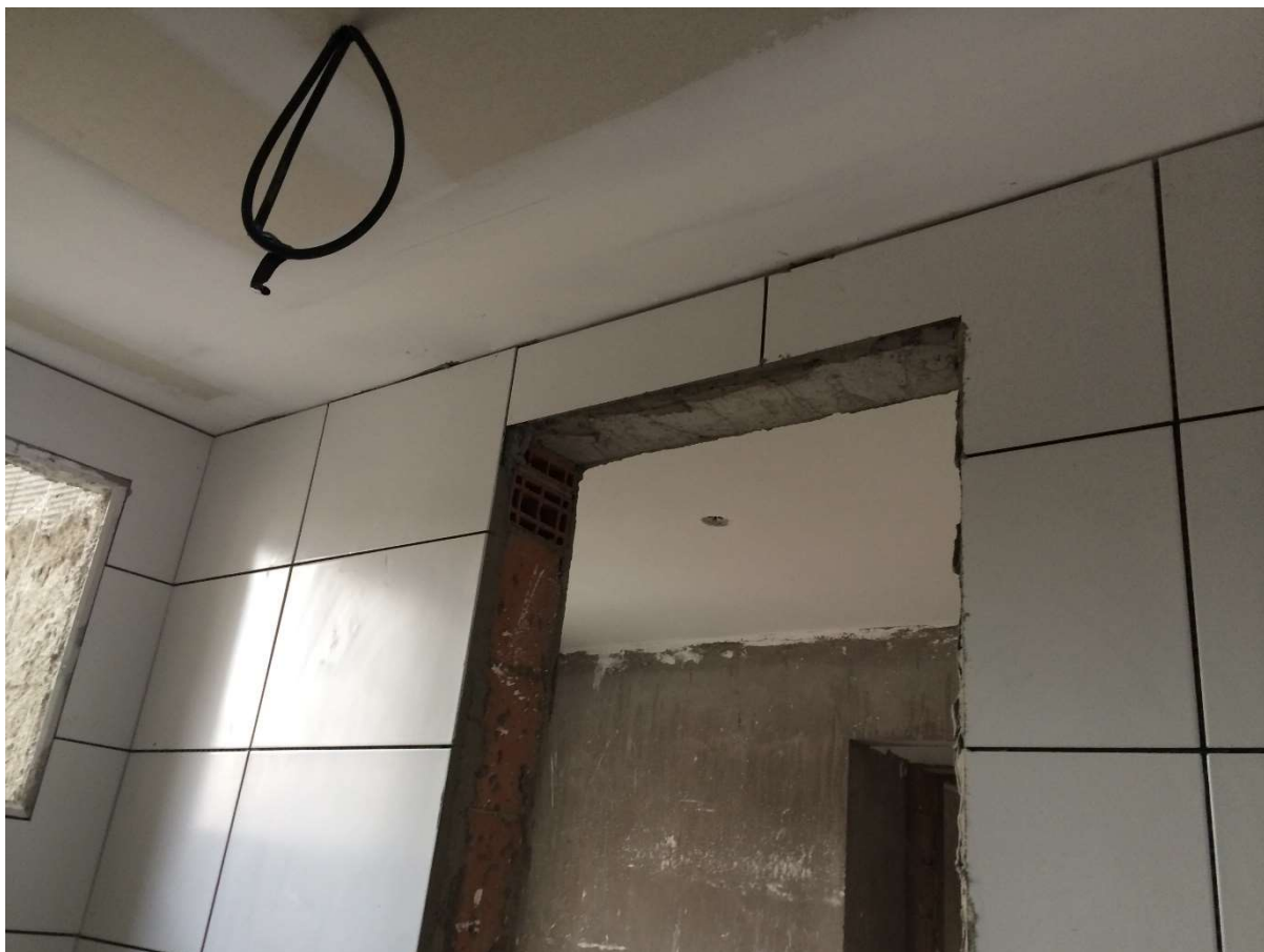
Figura 31 – Foto com revestimento assentado levando em consideração novas premissas de paginação e vão de porta
