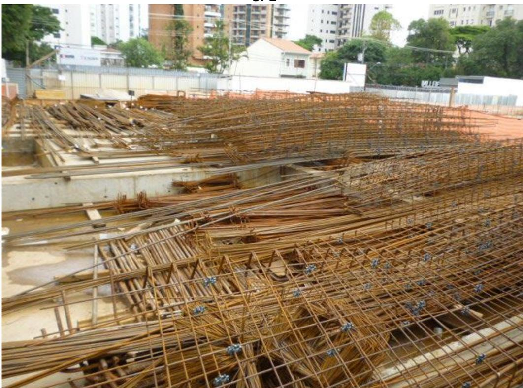
**Figura 55 - Pré-montagem das armaduras - Obra SP2**
