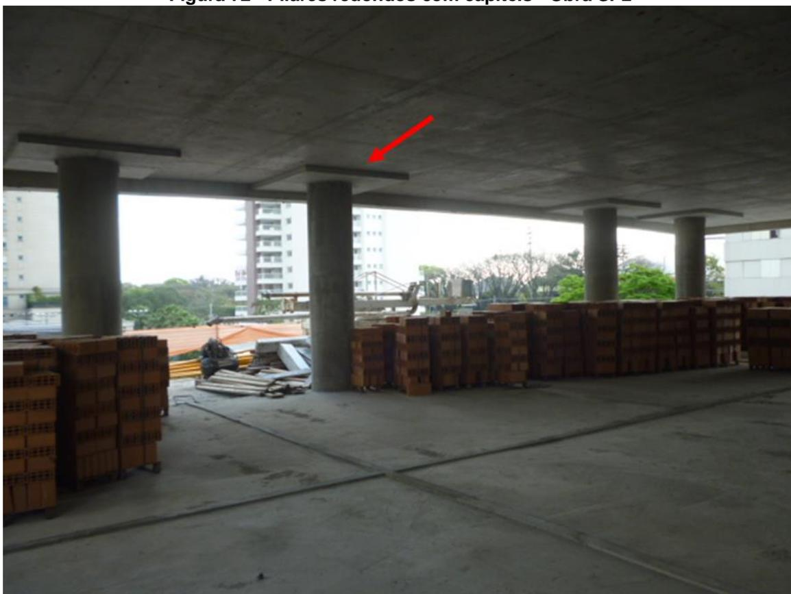
**Figura 73 - Viga curva - Obra SP2**
