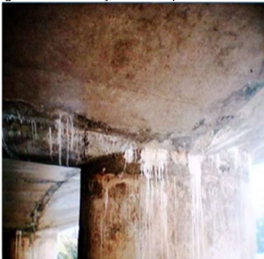
Figura 4.4 - Lixiviação de compostos hidratados
