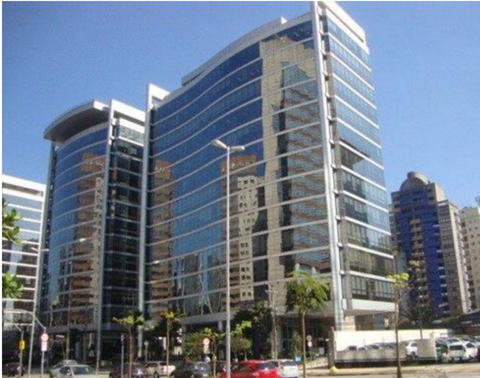
Figura 6 – Fachada do edifício Capital Center
