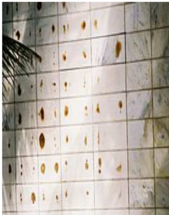
Figura 16. Manchas de Oxidação na posição das grapas. Fonte (Balbino, Mendes, Silva, , & Almeida, 2011).
