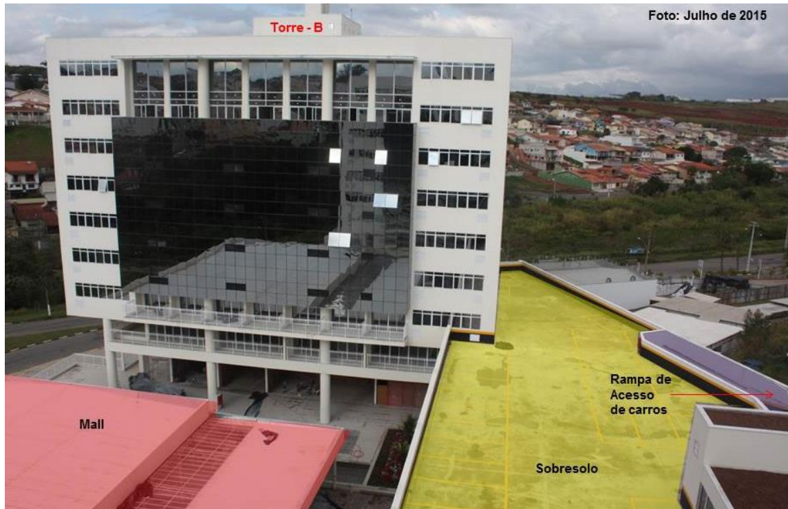
Figura 4.3.15 - A solução adotada pela equipe foi a construção de um sobressolo. Foto da obra já finalizada, em Julho de 2015, vista ao fundo a Torre B (Corporate)
