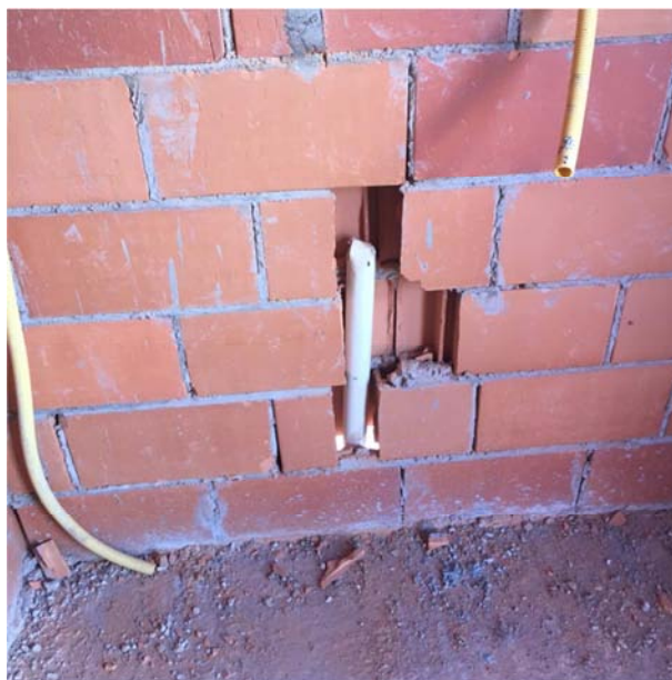
Figura 33: Rasgos para instalações
