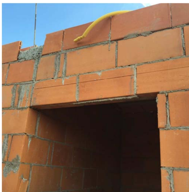
Figura 31: Execução de verga de porta em bloco canaleta e escoamento de graute FONTE: acervo pessoal
