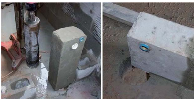
Figura 24: Pré-moldado para instalação hidráulica
