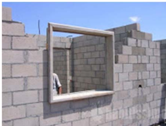
Figura 19: Vergas e contravergas executadas em pré-moldados
