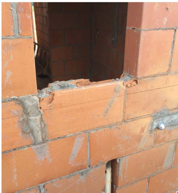
Figura 29: Execução de contraverga em bloco canaleta, com irregularidades FONTE: acervo pessoal
