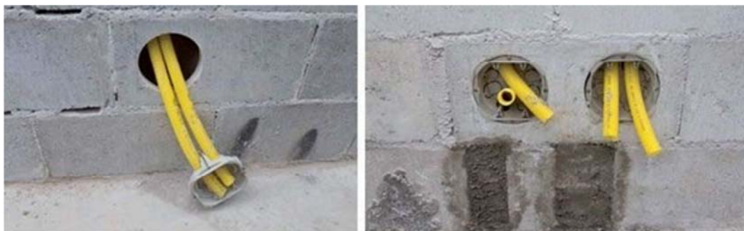
Figura 22: Caixa de encaixe para instalação em furo feito por serra copo
