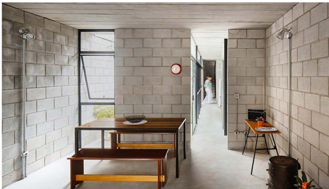
Figura 23: Residência em alvenaria estrutural aparente com aplicação de sistema de instalações elétricas também aparentes (Vila Matilde – São Paulo/ SP)
