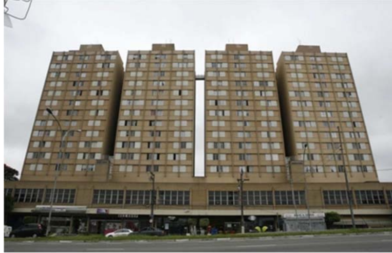
Figura 2: Conjunto Habitacional Central Parque da Lapa – blocos com 12 pavimentos
