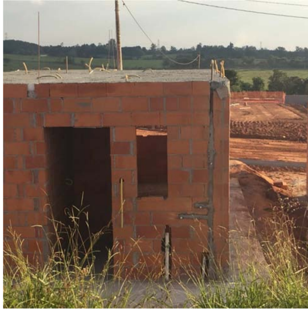
Figura 32: Rasgos para instalações
