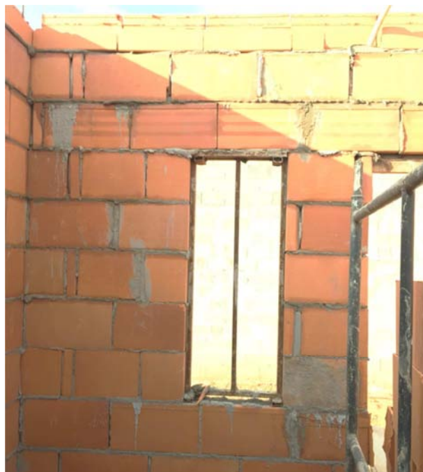
Figura 30: Execução de verga em bloco canaleta, com escoramento FONTE: acervo pessoal
