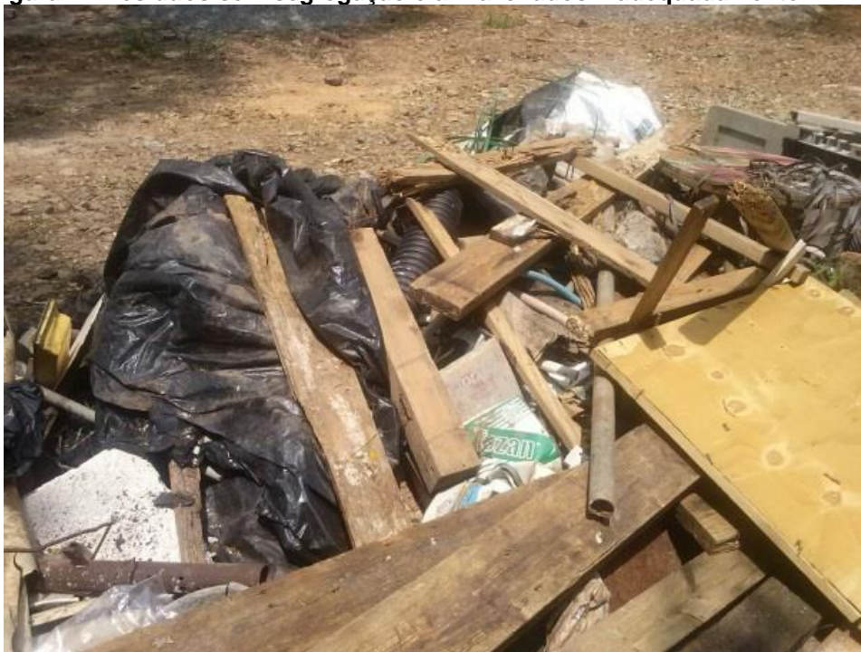
Figura 7 - Resíduos sem segregação e armazenados inadequadamente
