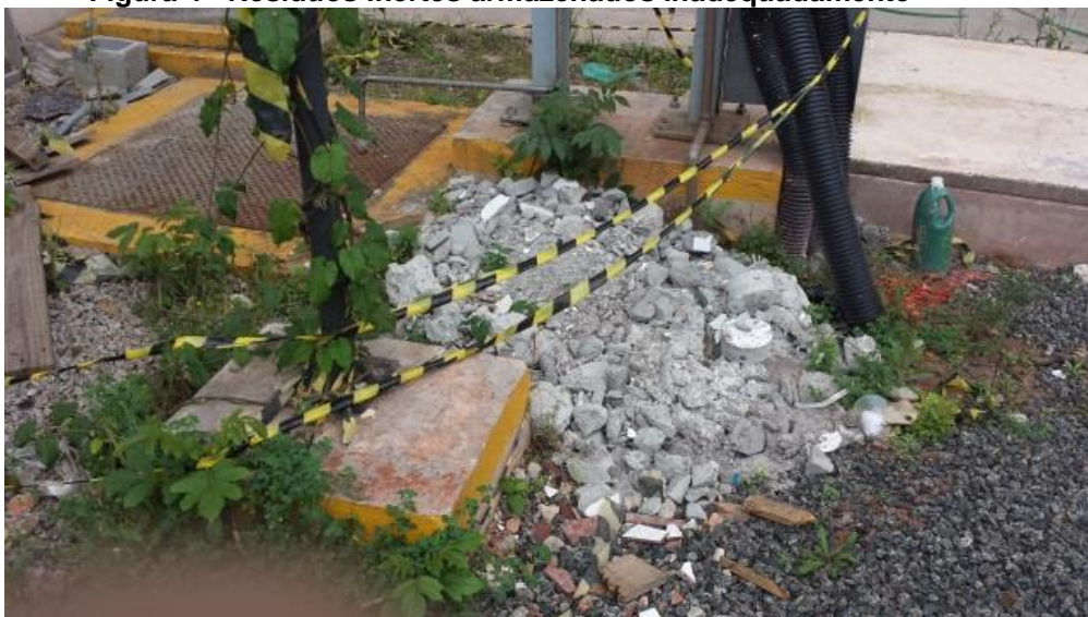
Figura 4 - Resíduos inertes armazenados inadequadamente
