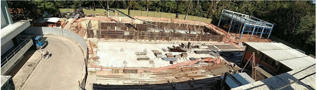
Figura 2 - Canteiro de Obras da futura fabrica de Vacina da Dengue
