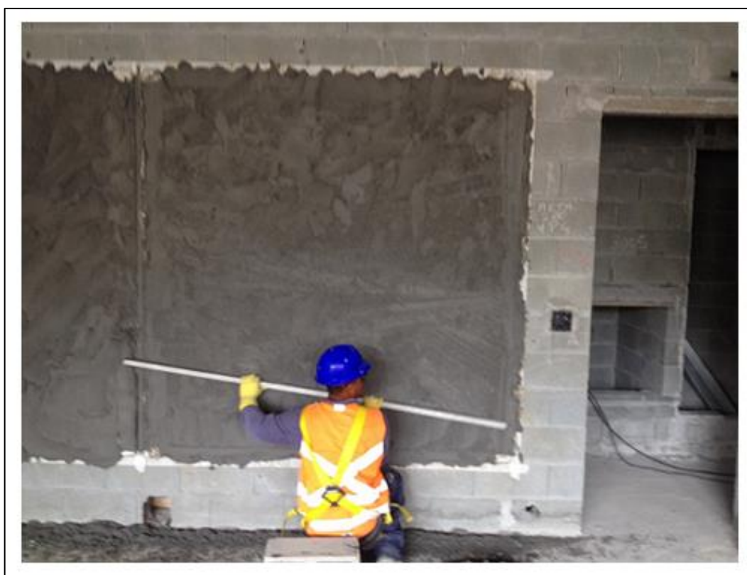
Figura 17 - Sarrafeamento dos painéis.
