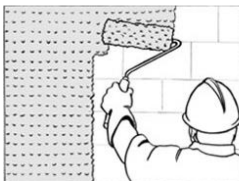
Figura 3 - Ilustração do chapisco rolado.
