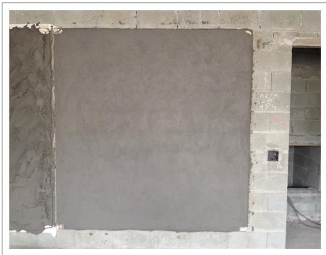
Figura 18 - Painel sarrafeado e desempenado pronto para receber o acabamento.
