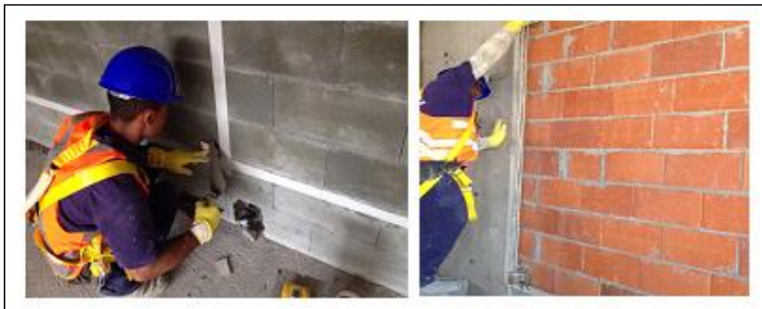
Figura 13 - Execução das taliscas.
