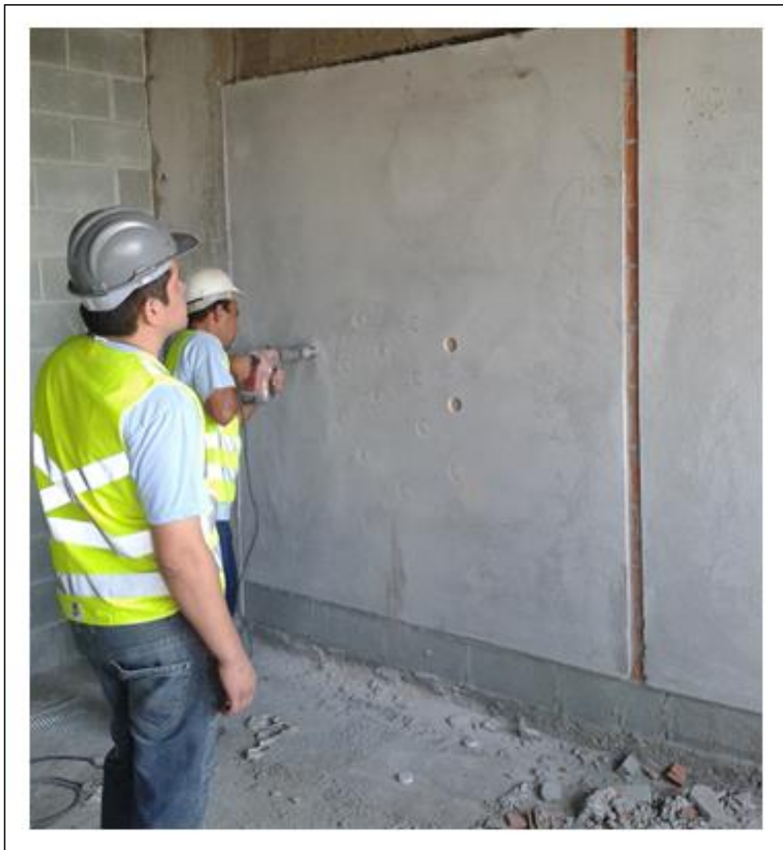
Figura 19 – Execução dos furos no painel.
