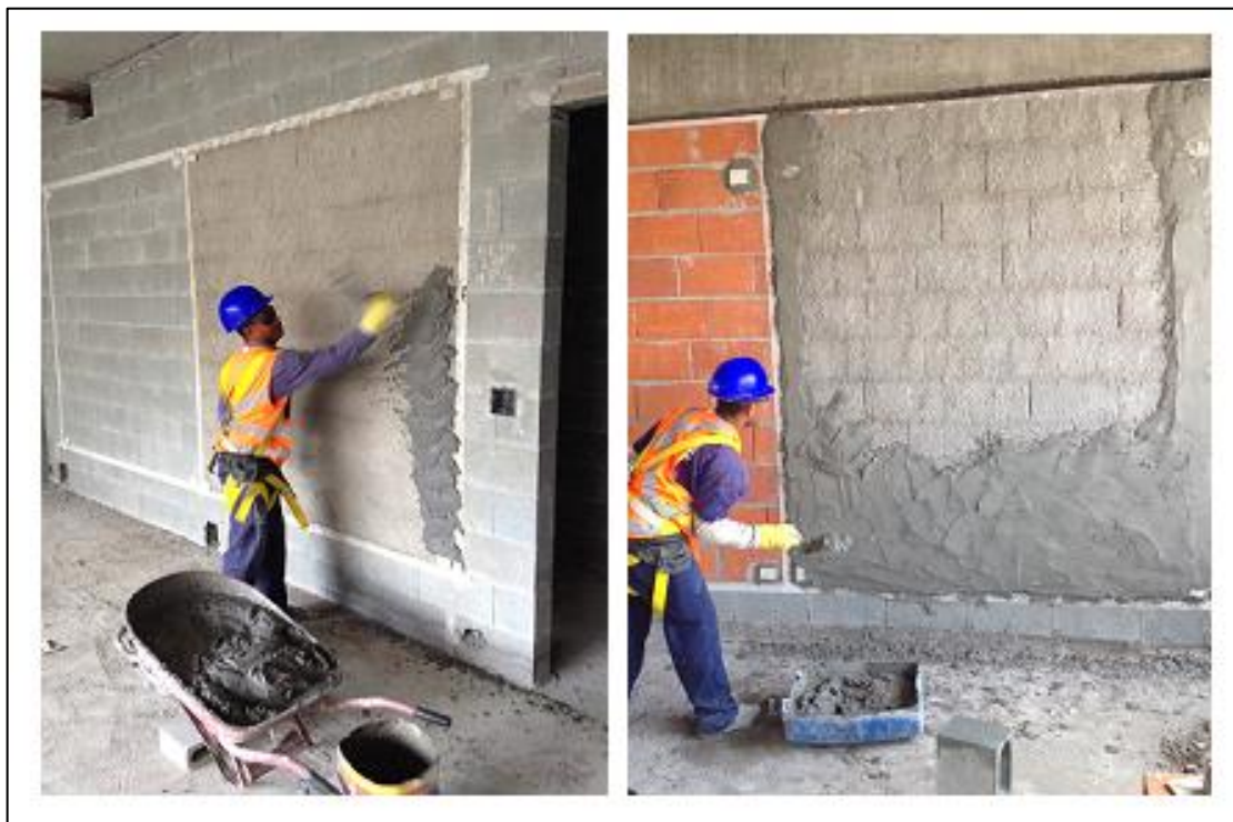
Figura 16 - Execução do revestimento em argamassa na base com e sem chapisco.
