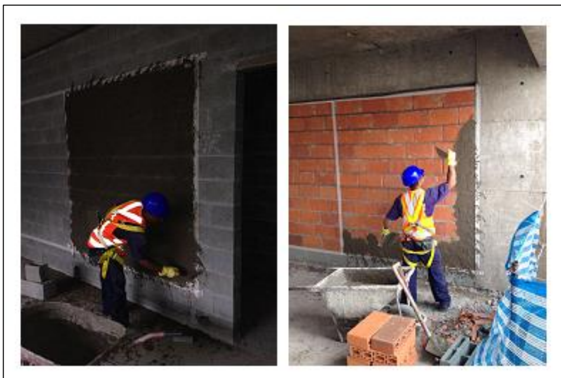
Figura 11 - Execução do chapisco manual (tradicional).
