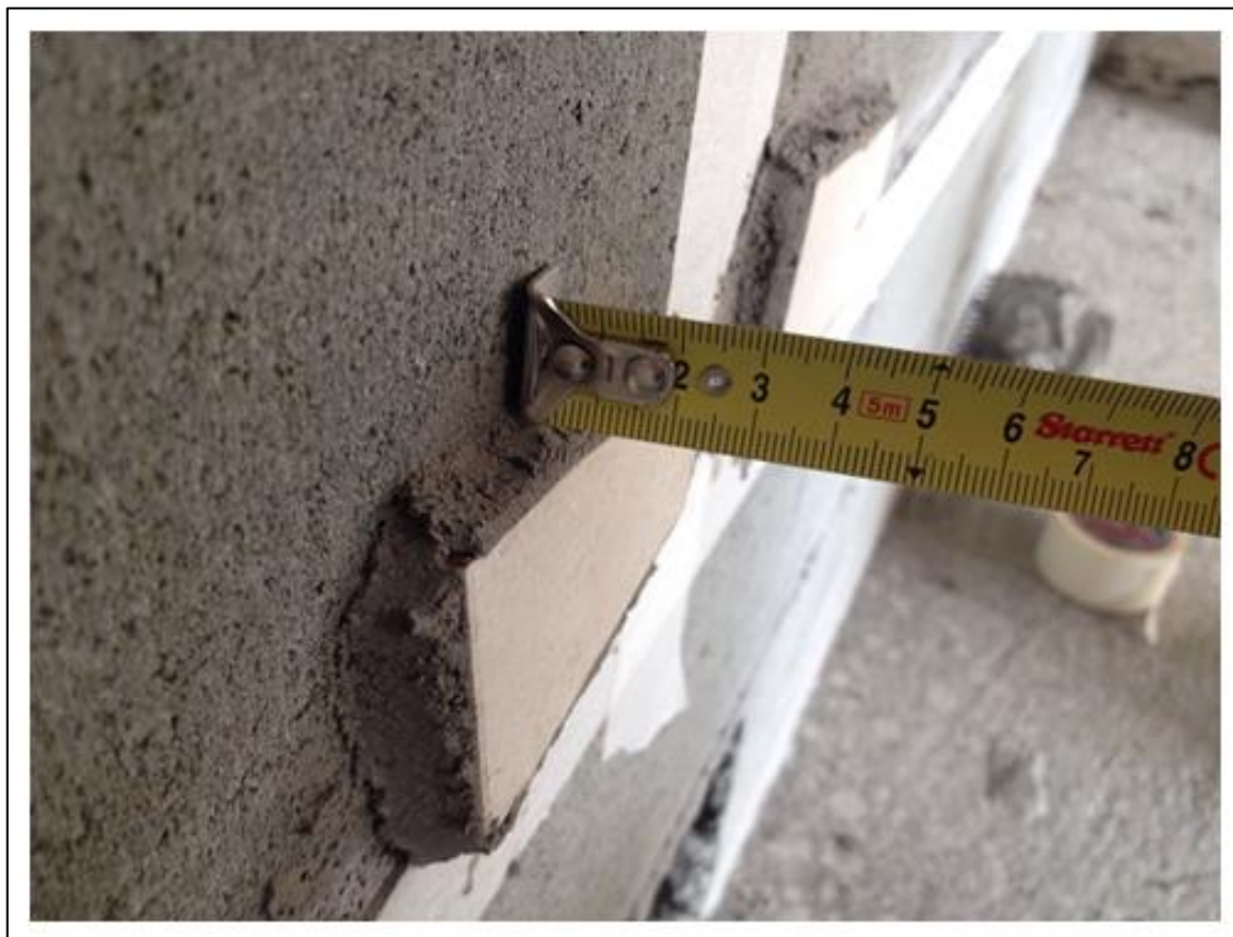
Figura 14 - Inspeção da espessura da argamassa no painel.
