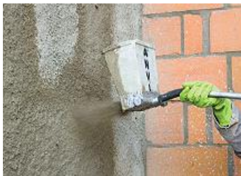
Figura 4 - Chapisco projetado através da canequinha.
