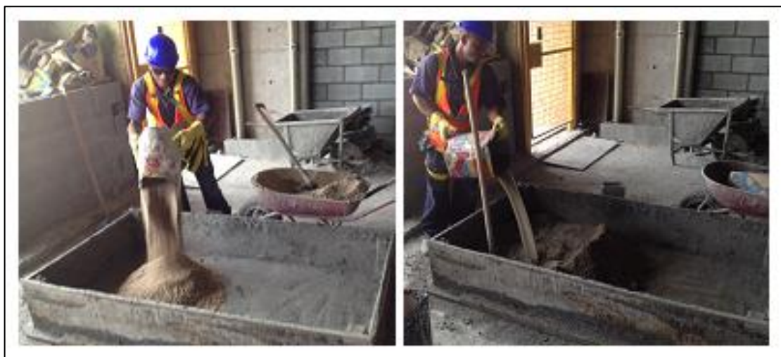
Figura 10 - Preparação do chapisco com traço 1:4.
