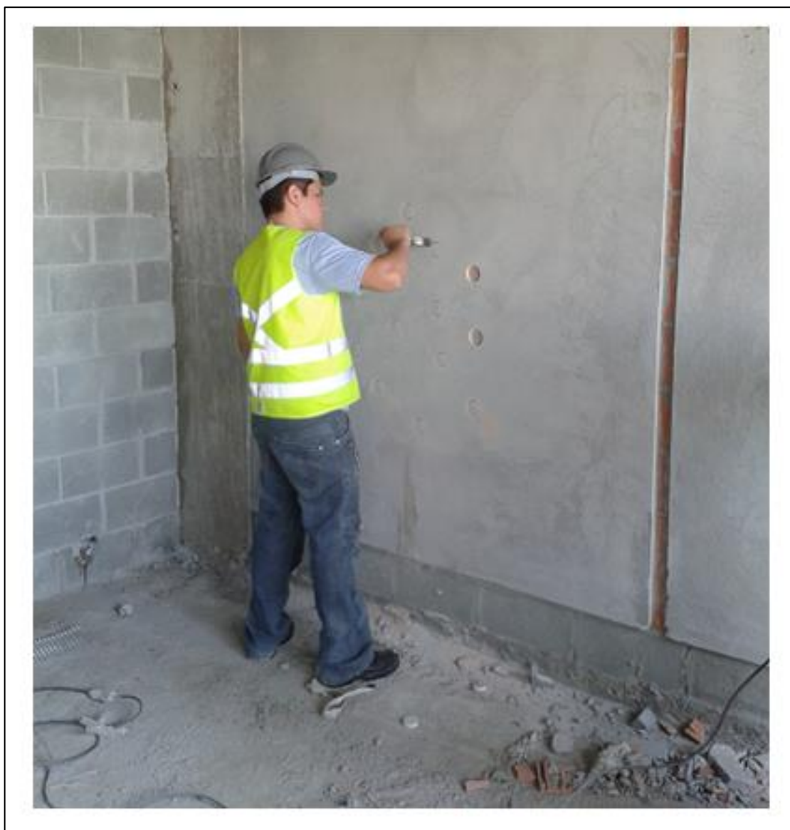
Figura 20 - Limpeza dos furos.
