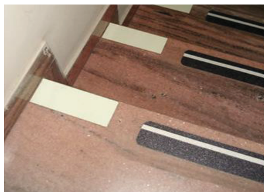
Foto 4 - Instalação de faixas demarcatórias nas escadas para delimitar as dimensões dos degraus e aplicação de fita "grão de arroz" para evitar queda de pessoas com mobilidade reduzida
