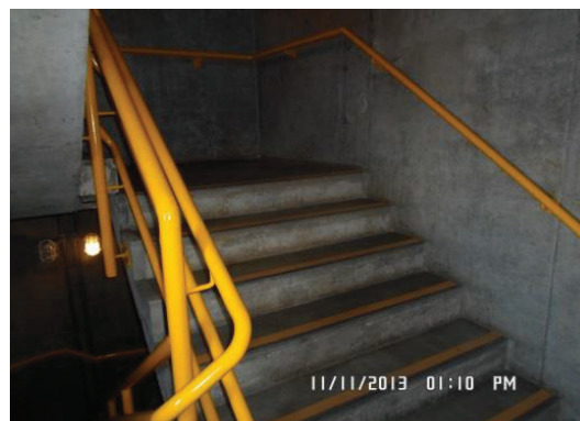
Foto 12 - Instalação de corrimãos em escadas, permitindo uma boa empunhadura.
