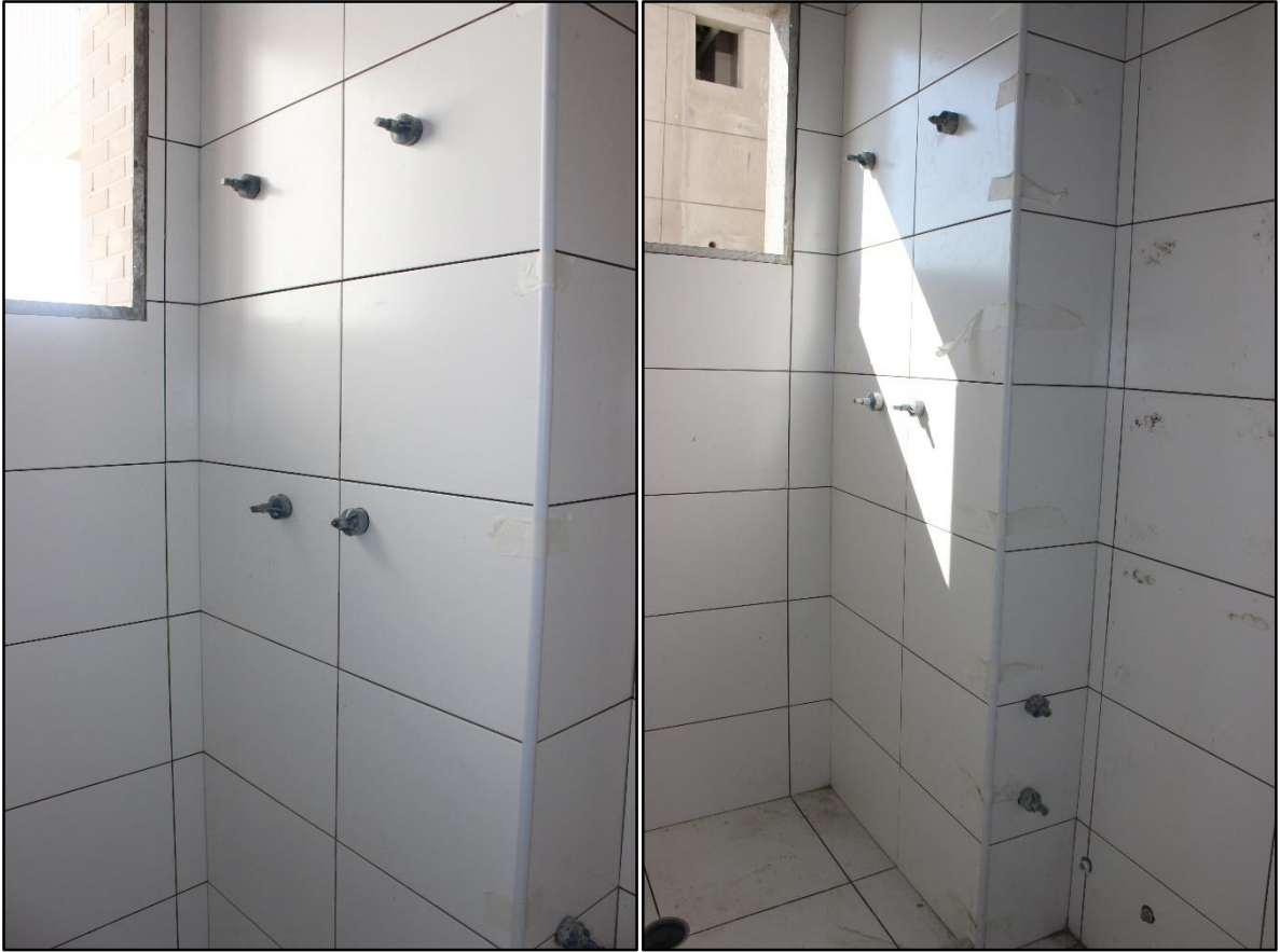
Figura 8: ilustração da tubulação instalada e parede revestida (fonte autor, 2015)
