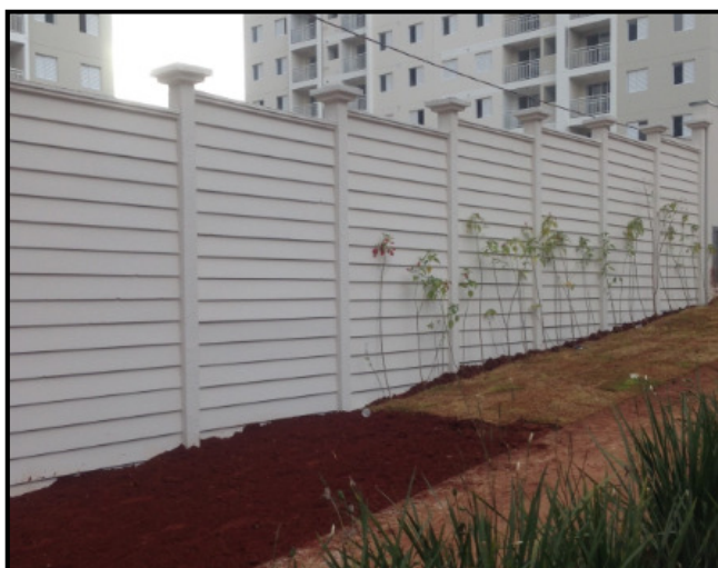
Figura 23 - Muro pré-fabricado em concreto pronto
