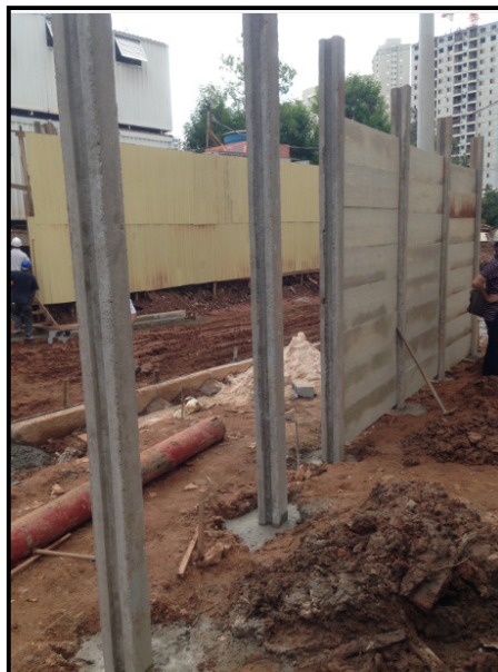
Figura 24 - Concretagem dos mourões de concreto no solo
