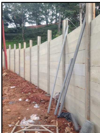
Figura 25 - Face interna do muro
