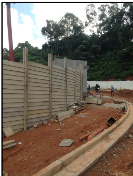
Figura 26 - Face externa do muro
