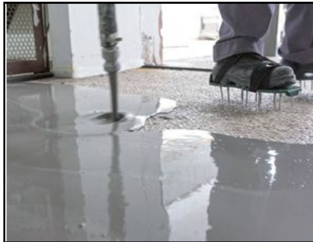
Figura 13 - Contrapiso autonivelante Fonte: Técnica, 2012
