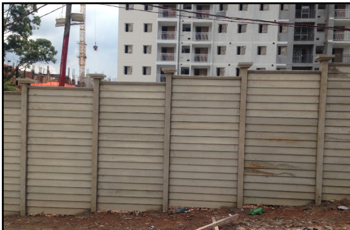
Figura 22 - Muro pré-fabricado em concreto semi-pronto
