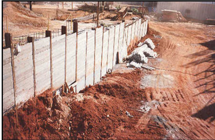
Figura 12 - Placas pré-fabricadas de concreto para cortina de contenção Fonte: M3SP
