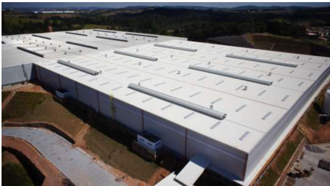
Figura 22: Galpão concluído (Foto: acervo pessoal - data: 02/02/2014)
