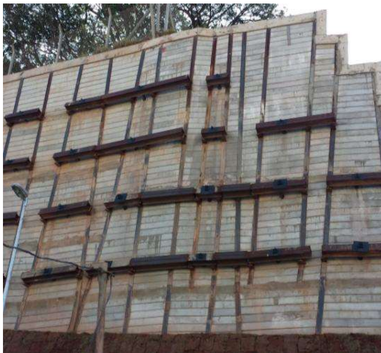
Figura 21: Muro de arrimo construído (Foto: Acervo pessoal - data: 02/02/2014)
