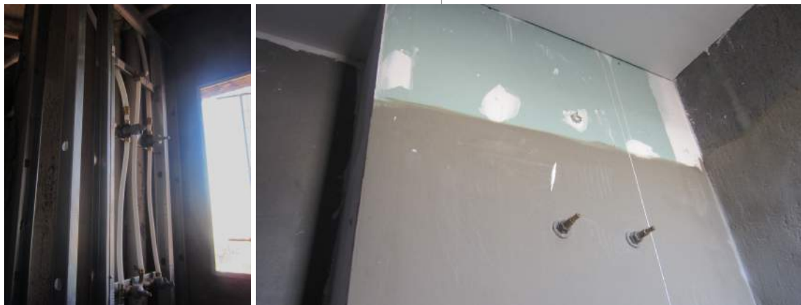
Figura 24 - Estudo de caso 1 - PEX - Kit instalado
