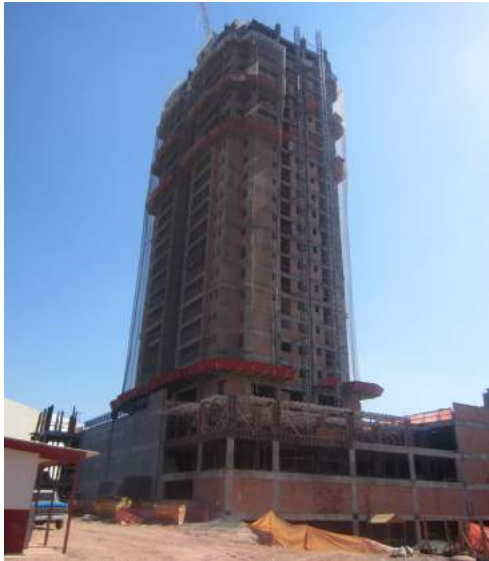
Figura 16 - Estudo de caso 1 - foto da obra
