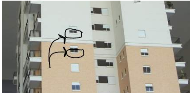
Figura 17 - Elemento de EPS na fachada - Maquete de vendas
