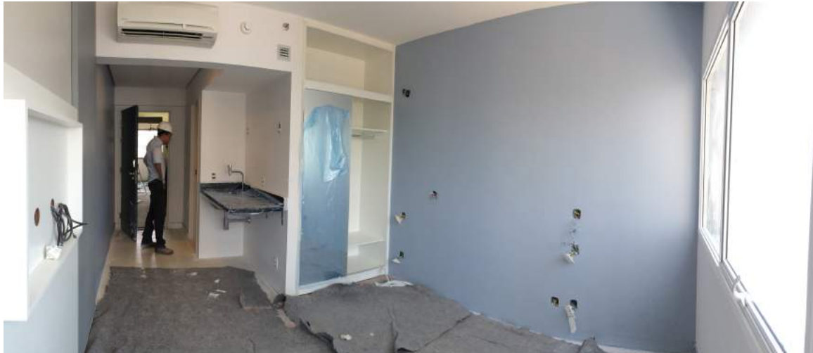
Figura 32 - Estudo de caso 2 – Protótipo – validação de instalações e acabamentos
