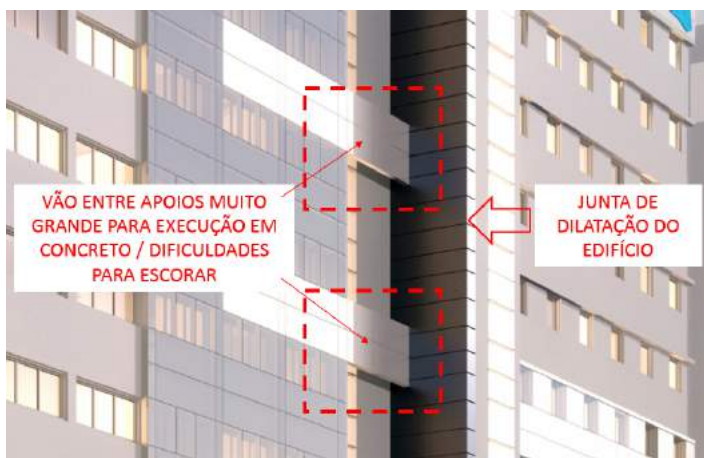
Figura 30 - Estudo de caso 2 - vigas descoladas da estrutura
