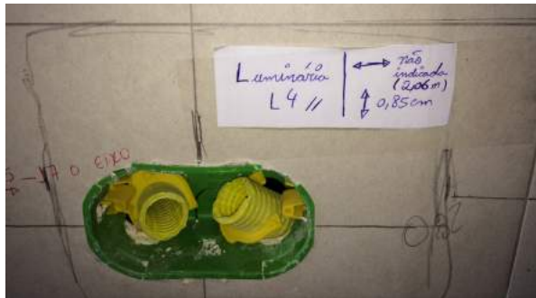
Figura 33 - Estudo de caso 2 – Protótipo – Verificação de locação horizontal das caixas elétricas
