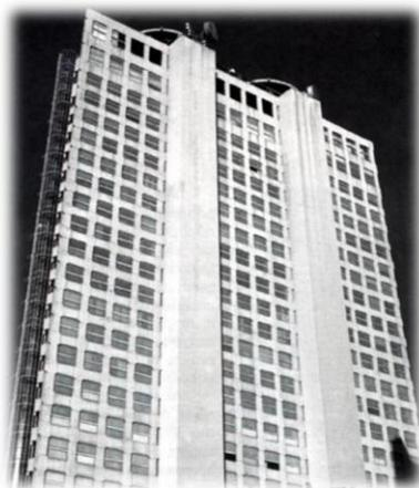
O prédio, em concreto protendido aparente, foi construído em 1975, utilizando técnicas artesanais para a execução das formas, o que resultou em imperfeições, problemas de alinhamento, distorções e desníveis.
