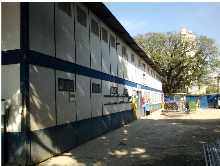
Figura 9 – Estrutura para Refeitório, Vestiários, Sanitários e área de vivência.
