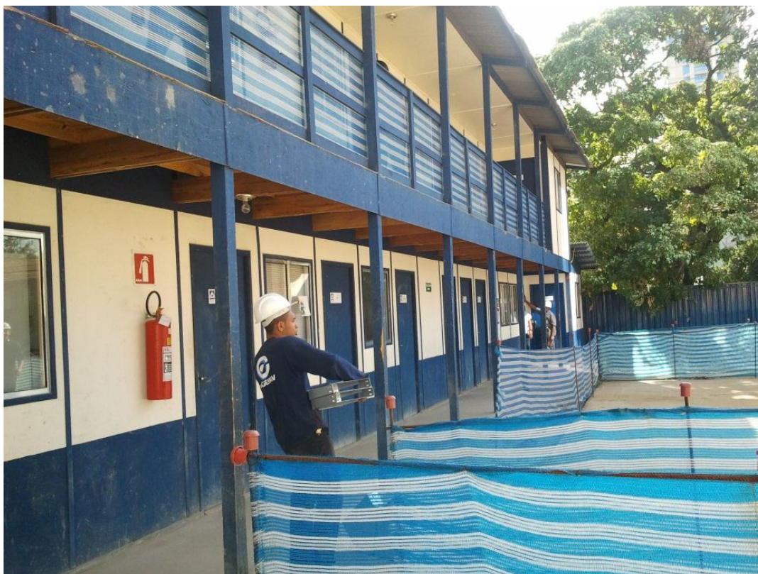
Figura 1 - Canteiro de obra
