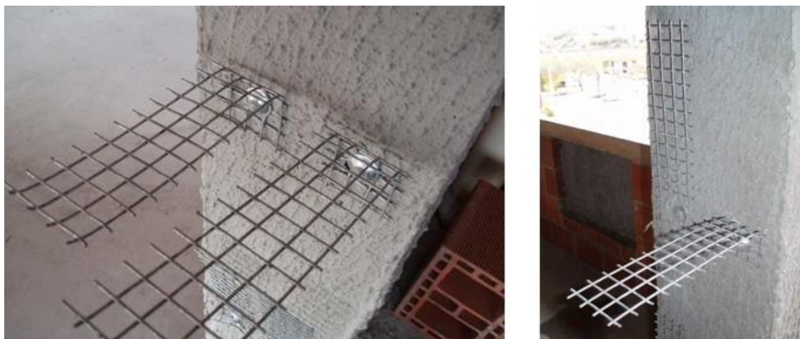
Figura 29 – Telas metálicas fixadas em pilar.
