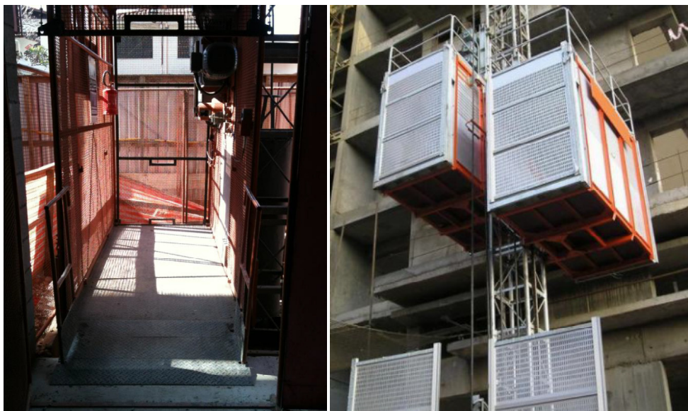
Figura 12 – Elevador Cremalheira (uma e duas cabines)
