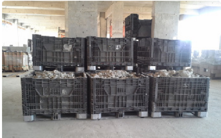
Figura 39 – Caixas coletoras de entulho
