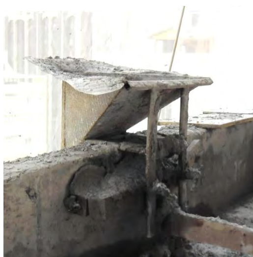
Figura 42 - Funil para abastecimento de argamassa pelo duto
