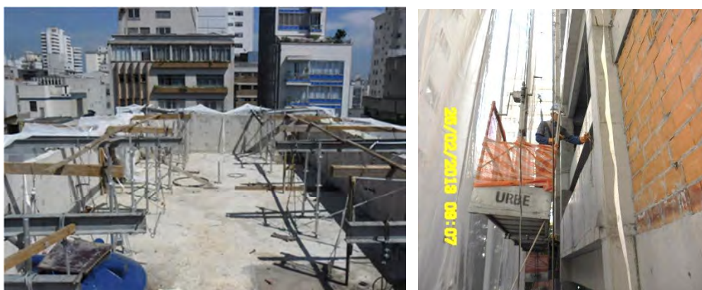
Figura 38 - Vigas de sustentação e balancim leve na fachada
