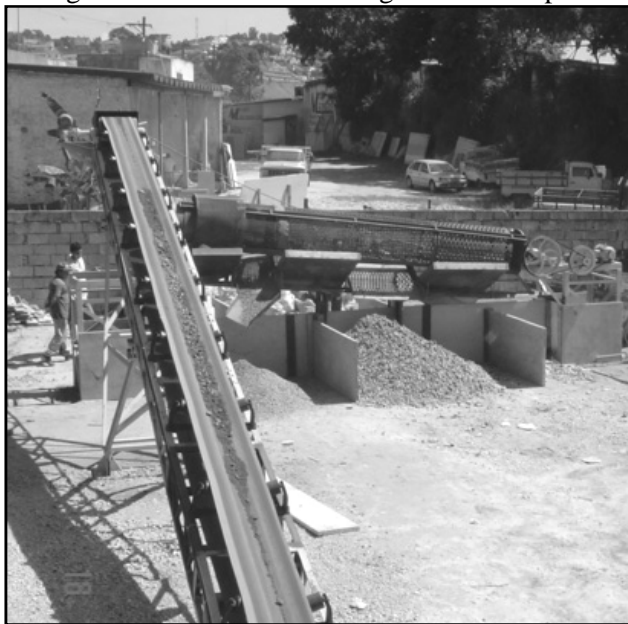
Fotografia 2: Central de reciclagem em ATT privada.
