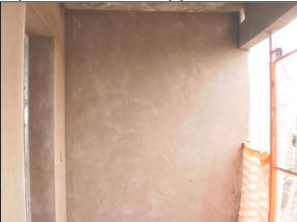
Fotografia 14: Revestimento executado com agregado reciclado.
