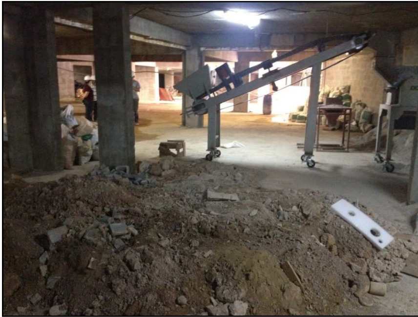
Fotografia 11: Central de reciclagem instalada na obra.
