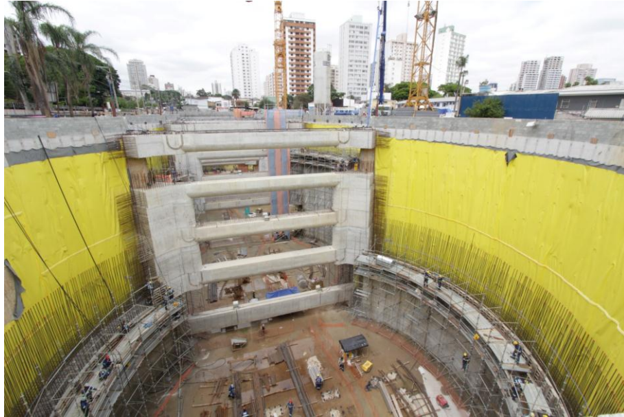
Figura 5: Exemplo de edificação metroviária, estação subterrânea em construção. Fonte: Autor.
