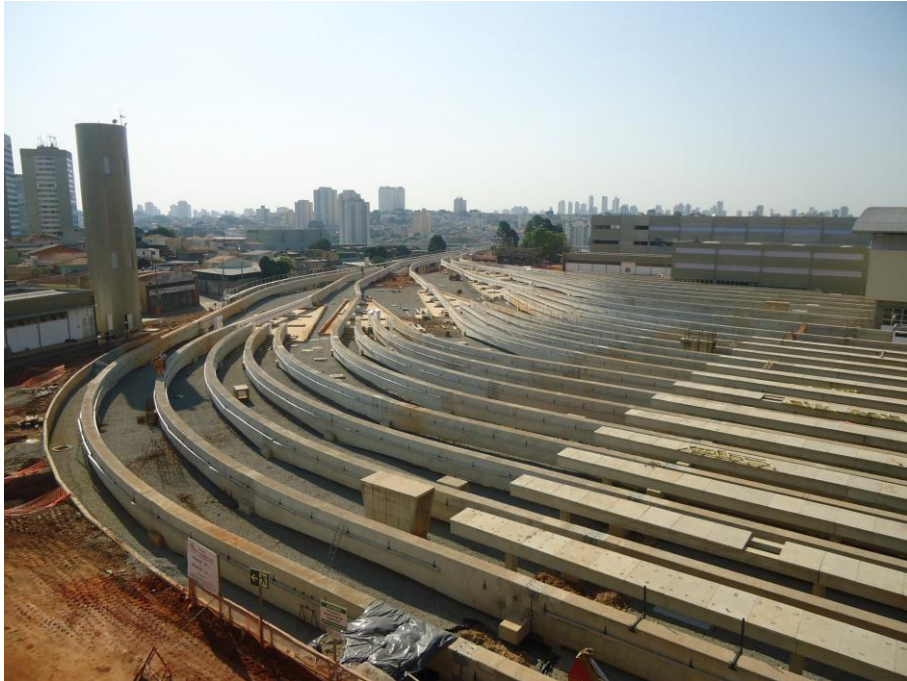
Figura 9: Exemplo de área metroviária, pátio de manutenção em construção. Fonte: Autor.
