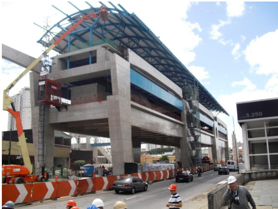
Figura 4: Exemplo de edificação metroviária, estação elevada em construção. Fonte: Autor.
