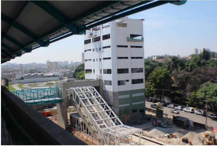
Figura 7: Exemplo de edificação metroviária, edifício de apoio à estação. Fonte: Autor.
