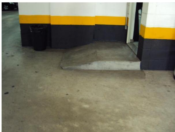
A rampa da Foto 6 esta com inclinação maior conforme a legislação, sendo necessário prolongar o comprimento.
