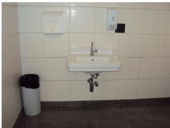
O banheiro do Prédio, que localiza-se na Térreo Superior, esta em partes de acordo com a Norma, pois não tem coluna, mas ao mesmo tempo não tem a barra de apoio, a torneira devem ser acionadas por alavanca, sensor eletrônico ou dispositivos e falta o espelho na posição inclinado
