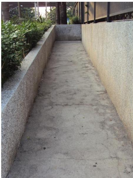
O Prédio na qual fizemos o estudo de caso a rampa externa, não possui corrimão com duas alturas, conforme a recomendação da Norma, além disso, é necessário fazer guias de balizamento.
