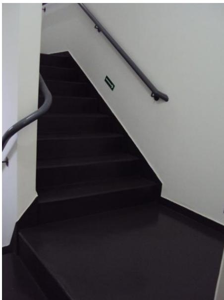
Nas escadas de emergência os corrimãos estão de maneira inadequada, conforme a Norma NBR 9050/2004.
