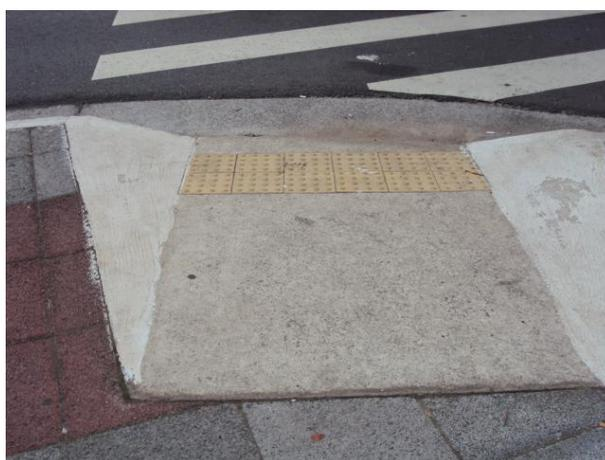
Nos acessos ao Prédio, utilizaram piso tátil nas calçadas. O piso tátil foi instalado no início da rampa, mas também deveria ter sido instalado no final dela.
