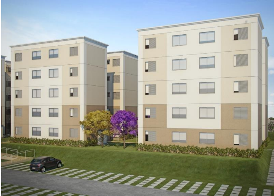
Figura 6: Fachada empreendimento– Tenda
