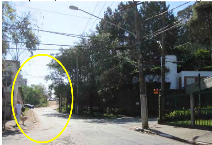
Figura 60 – Rua Itapaiuna, trecho sem asfalto próximo ao Colégio Porto Seguro
