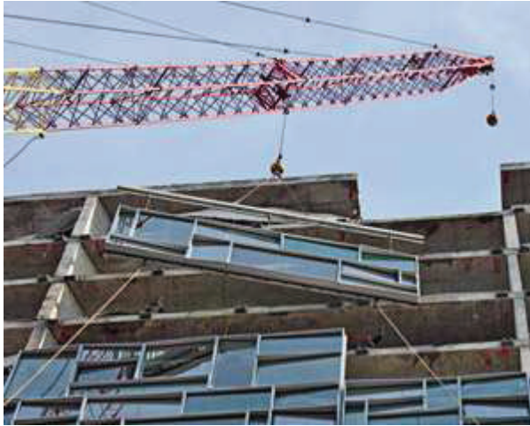
Figura 52: Montagem com painéis unitizados de fachada em projeto de Jean Nouvel. Fonte: Redchalksketch.
