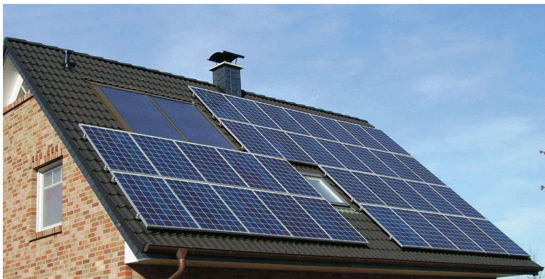
Figura 27: Instalação de sistema anexado em cobertura. Fonte: Energy-Trust.
