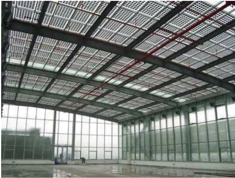
Figura 29: Edifício com módulos PV integrados. Fonte: Shanghai Solar Energy S&T Co, Ltd.
