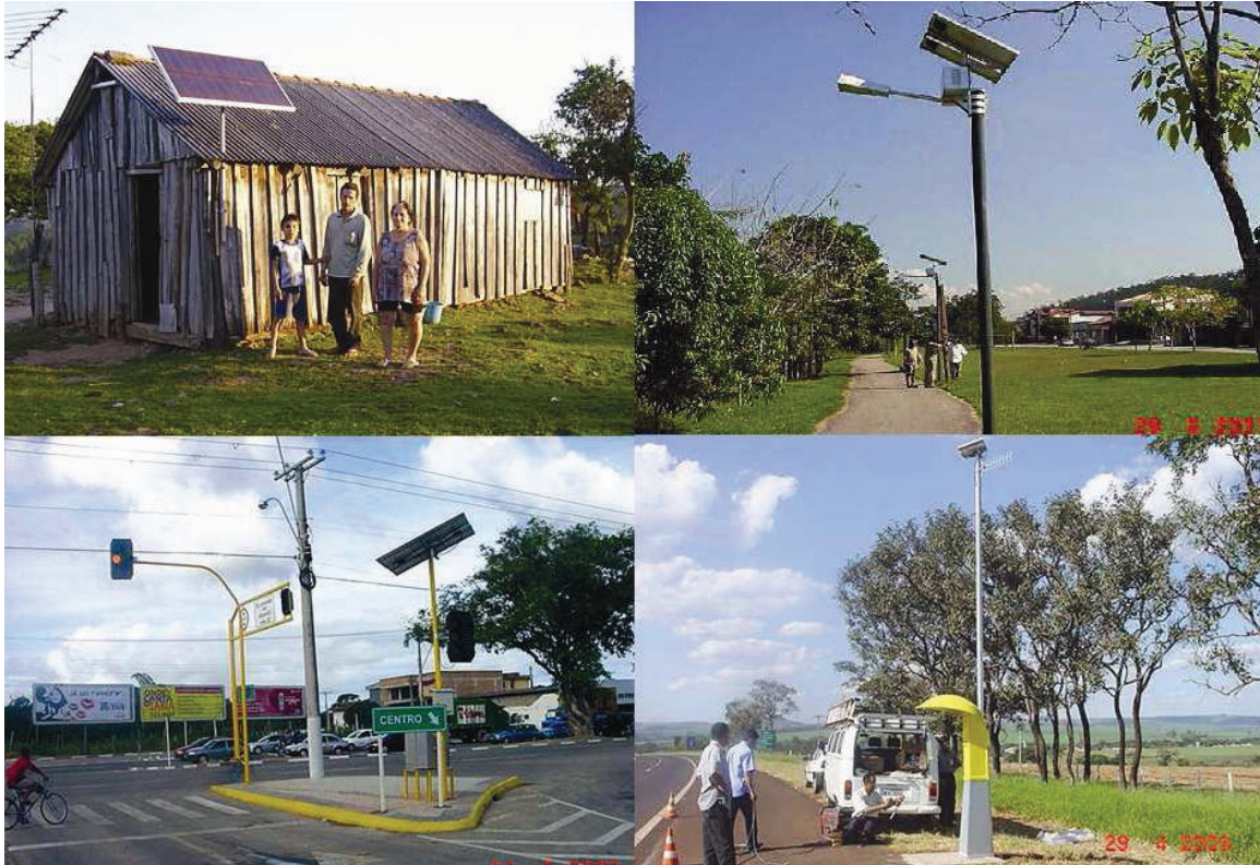
Figura 20: Imagens de sistemas autônomos. Acima à esquerda: edificação rural (fonte: Kyocera); acima à direita: iluminação pública; abaixo à esquerda: sinalização de trânsito (fonte: Kyocera); abaixo à direita: telecomunicações (fonte Kyocera).
