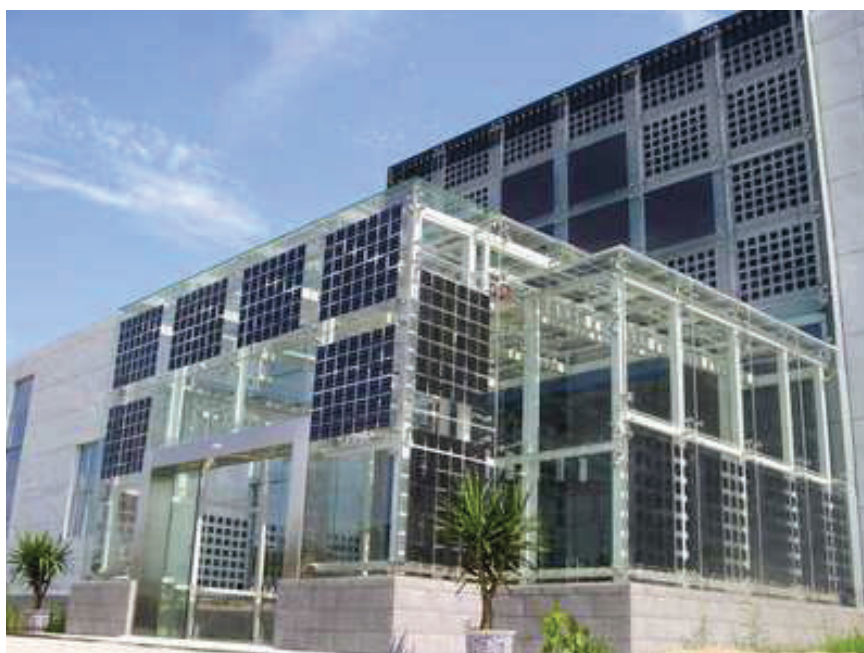
Figura 28 Edifício com módulos PV integrados na fachada. Fonte: Windweathersolar
