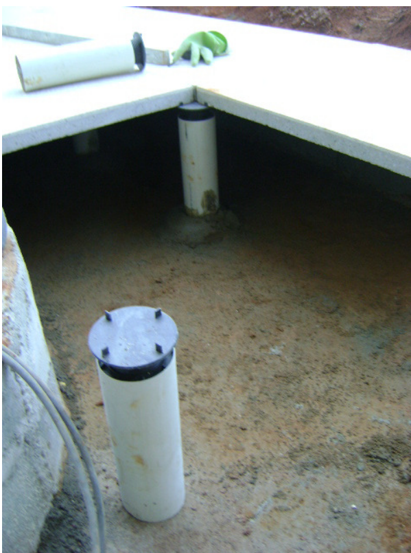
Anexo 1: Detalhe da parte superior dos apoios com espaçador plástico e chumbamento da base(Fonte: Produção Mac, 2009)
