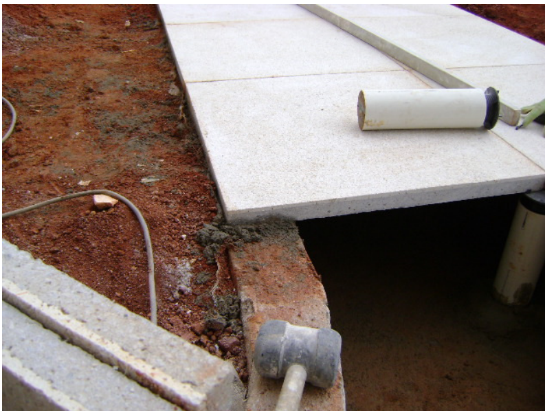
Anexo 1: Detalhe do encontro das placas com a mureta do jardim(Fonte: Produção Mac, 2009)
