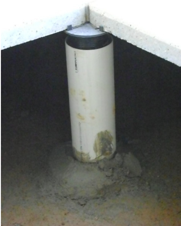
Anexo 1: Detalhe da parte superior dos apoios com espaçador plástico e chumbamento da base(Fonte: Produção Mac, 2009)
