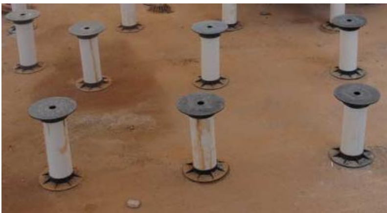
Anexo 1: Detalhe de apoios com suporte plástico regulável(Fonte: Produção Mac, 2009)
