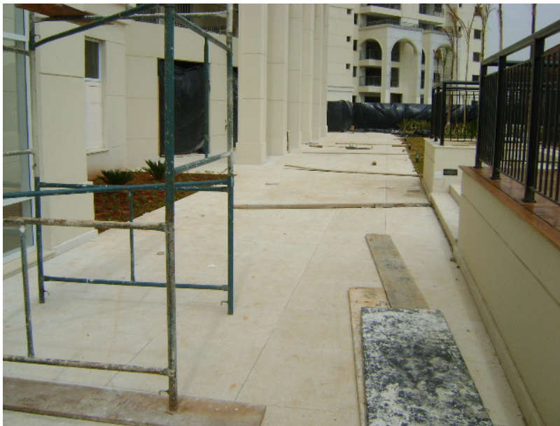
Anexo 1: Vista do piso elevado em execução (Fonte: Produção Mac, 2009)
