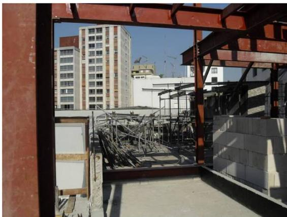
Figura 26- Estrutura metálica e fechamento com tijolo de concreto celular
