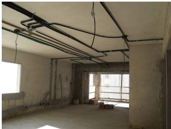
Figura 28 – Passagens de cabeamento elétrico pela sala de estar
