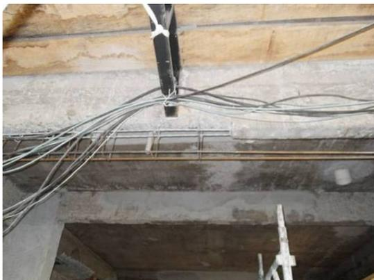
Figura 21– Viga descascada para análise
