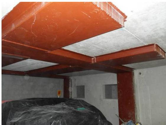
Figura 25– Reforço estrutural metálico no subsolo
