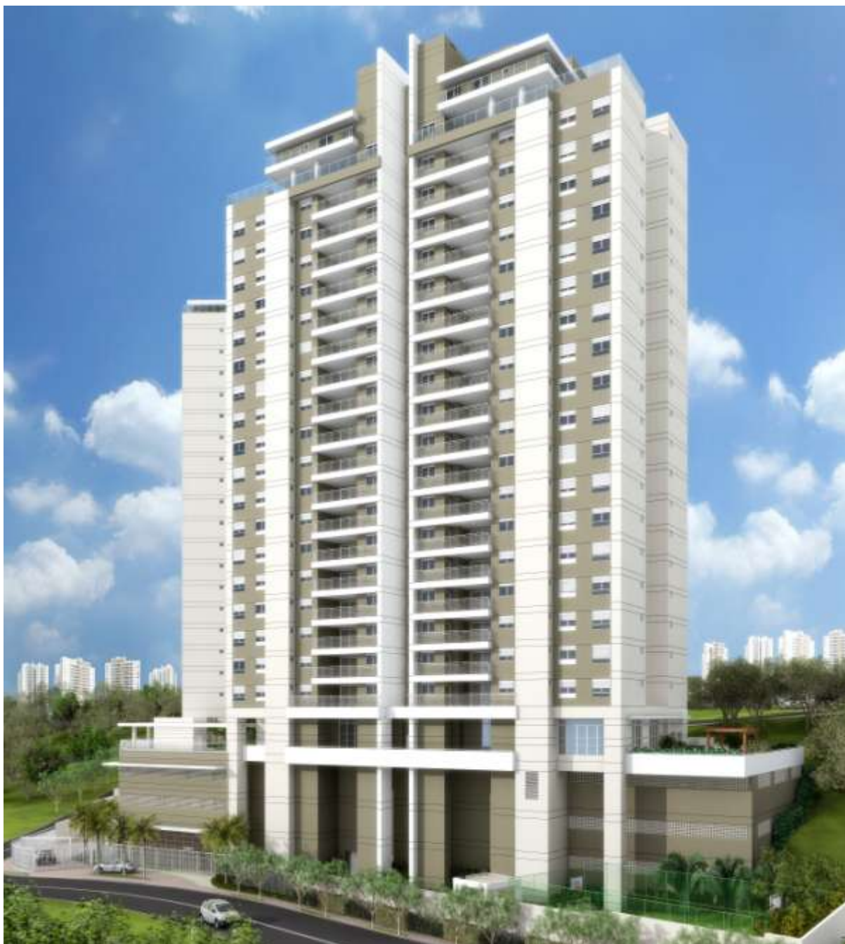
Figura 17 - Imagem da fachada do empreendimento A
