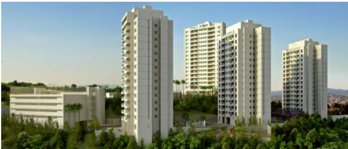
Figura 27 - Imagem da fachada do empreendimento E em desenvolvimento
