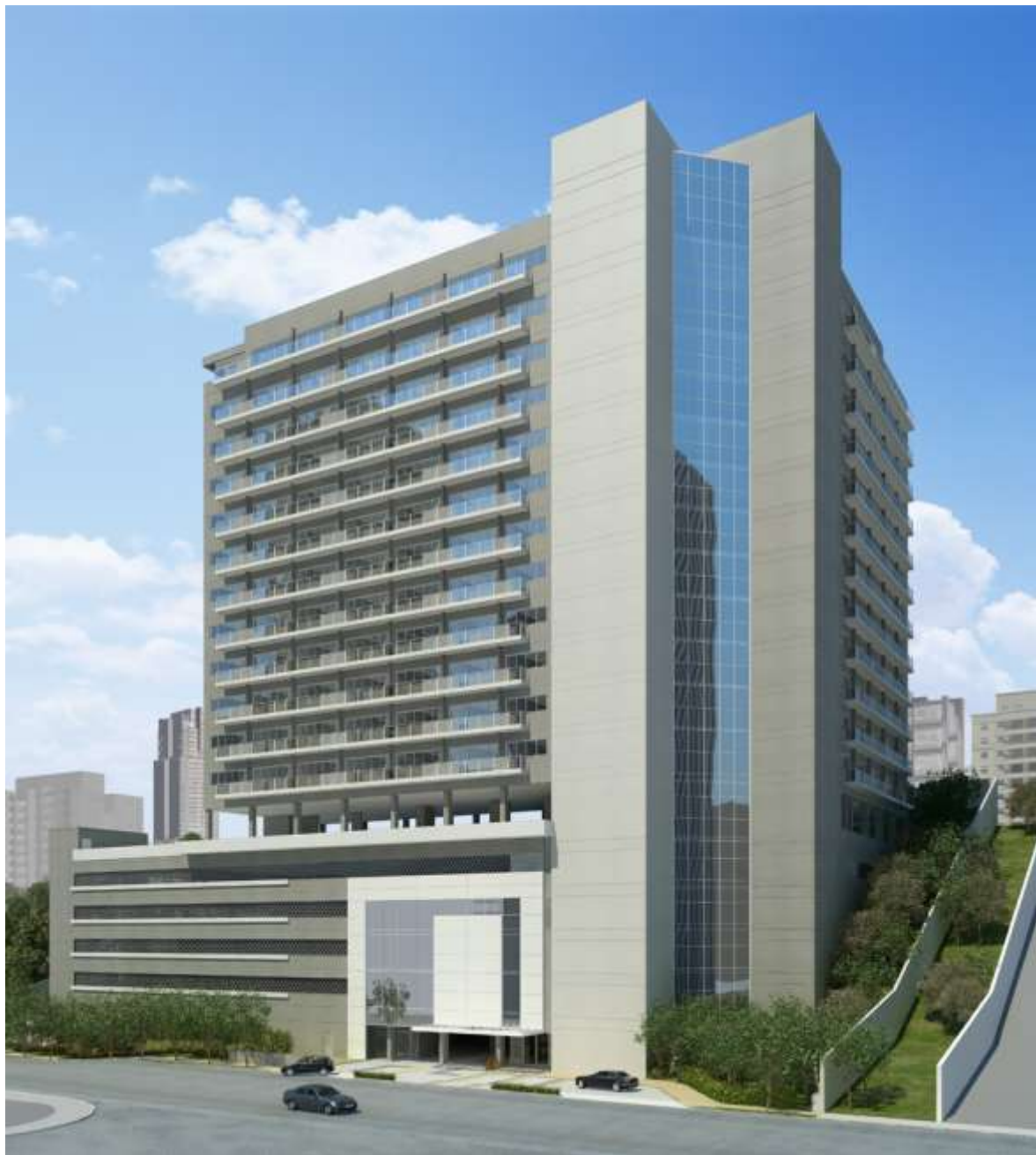
Figura 24 - Imagem da fachada do empreendimento C
