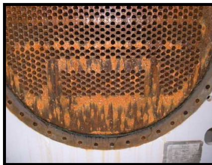
Figura 6 – Material orgânico no espelho de um condensador
