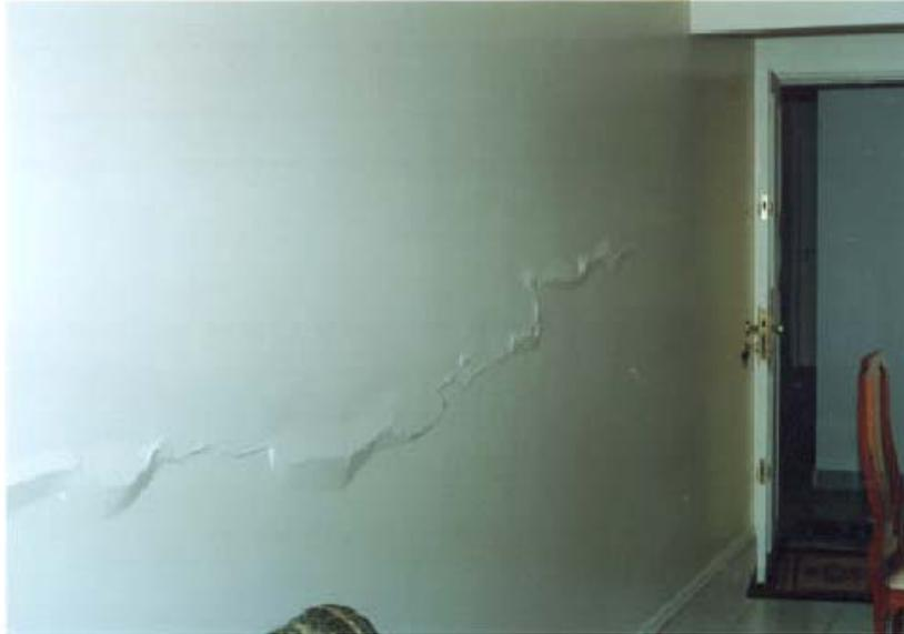
Figura 3.2.1 – Fissuras em alvenaria por deformação vertical da viga
