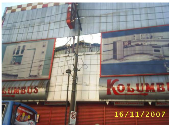
Foto 3 Interferências junto a concessionária de energia são necessárias devido a proximidade da rede elétrica. Após retirada da fachada haverá fechamento treliças.
