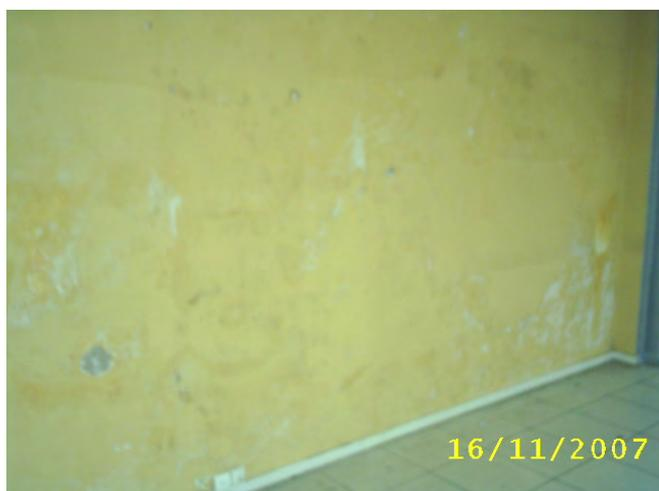
Foto 23 Parede necessidade de tratamento da infiltração
