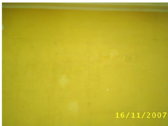
Foto8-Parede com umidade a ser tratada
