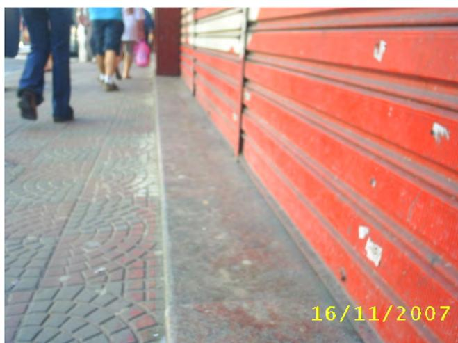
Foto 39 soleira ser trocada e pilar a ser revestido.
