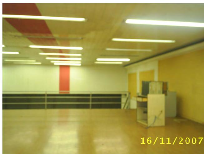
Foto 12-troca de forro retirada de luminárias, tratamento de paredes, algumas com textura e moldura de gesso.
