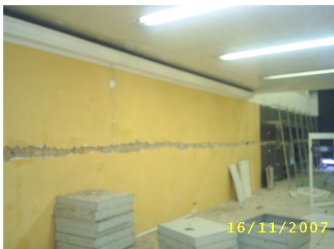
Foto 21 Parede a ser tratada acabamento/preenchimento.
