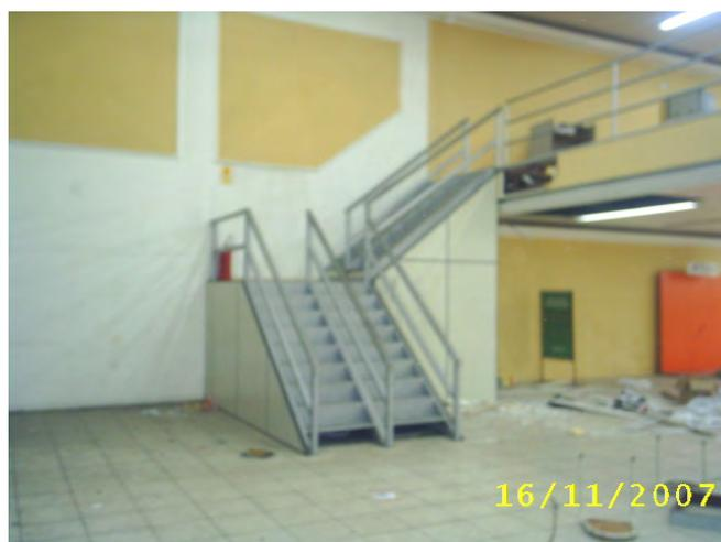
Foto 30 Escada a ser removida, piso será reaproveitado.
