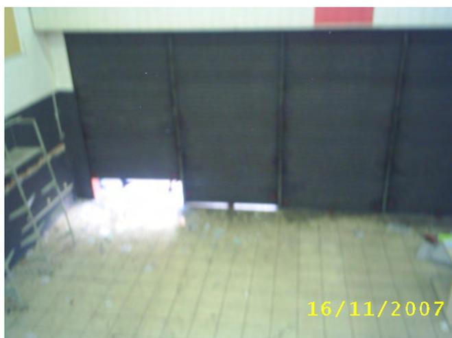
Foto5-Manutenção para as portas de aço e instalação Da portinhola, milano + 2 tetras laterais e 1 tetra central Para cada porta.
