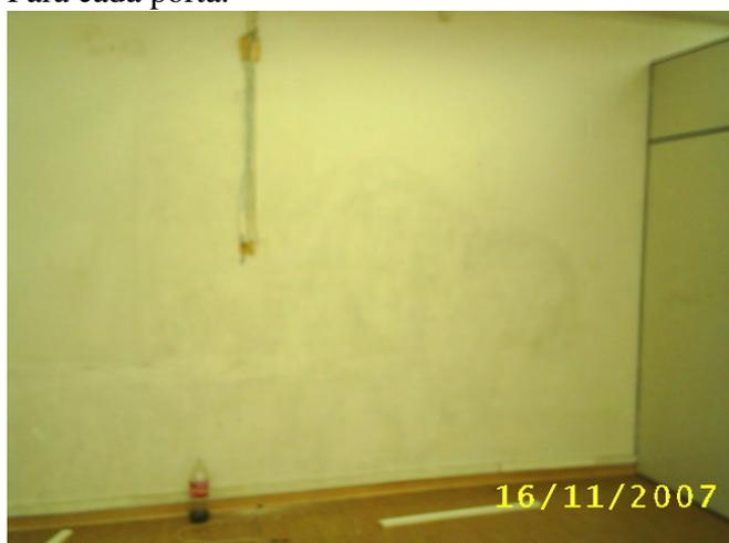
Foto7-Parede com umidade a ser tratada. Retirada de divisória.
