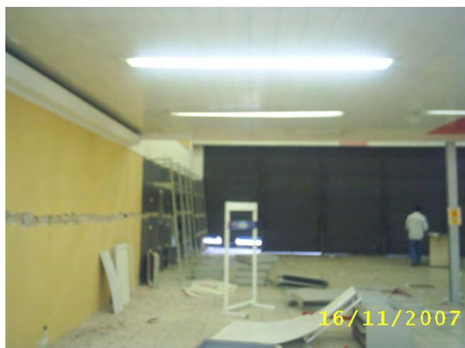
Foto 20 Forro a ser removido e parede lateral a ser regularizada.
