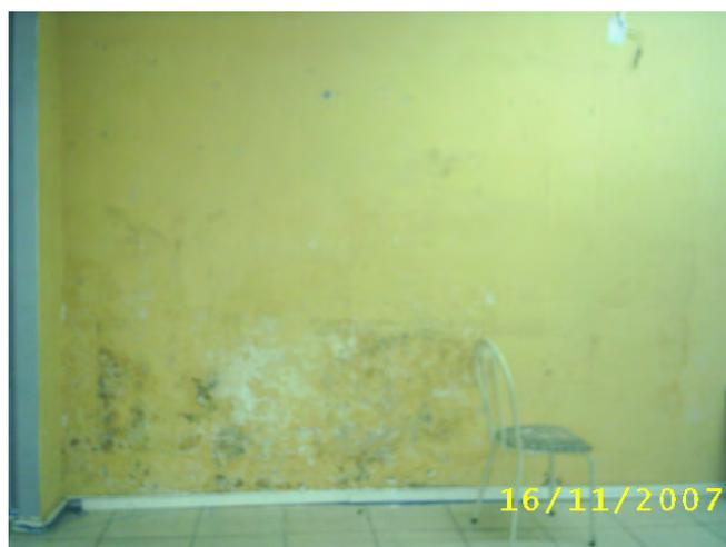
Foto 22 Parede com necessidade de tratamento da infiltração
