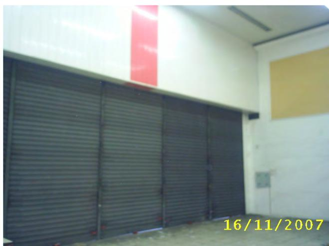
Foto 15-Manutenção para as portas de aço e instalação Da portinhola, milano + 2 tetras laterais e 1 tetra central Para cada porta.Adequação do cobre rolo.
