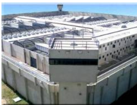
Figura 49 – Foto do Muro Interno, Área para Patrulhamento, Muralhas Externa com Guarita e Passarela de Circulação, do CDP de Serra Azul. / Fonte: SAP
