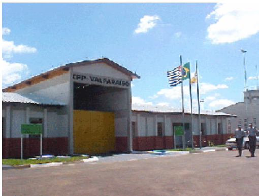
Figura 06 – Centro de Progressão Penitenciária Valparaíso Fonte – SAP
