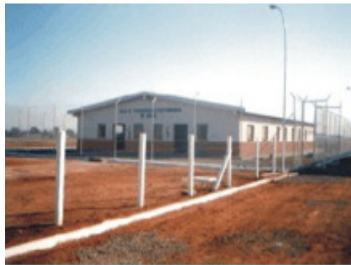
Figura 07 – Ala de Progressão Penitenciária Iaras Fonte – CPOS
