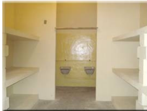
Figura 54 – Foto da Pintura Impermeável do Banheiro, Lavatório de PVC, Mobiliários em Concreto de uma Cella do CDP de Osasco I. / Fonte: SAP
