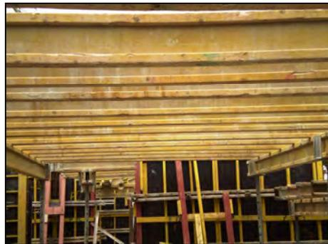
*Figura 4.21 – Cimbramento com vigas tipo H20.*
