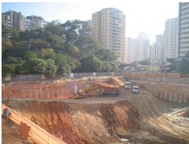
*Figura 4.7 – Fluxo dos caminhões para retirada de terra (junho/2006).*
