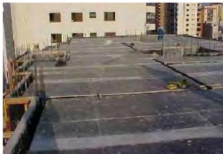
*Figura 3.10 – Molde para laje com fôrma em chapa de madeira compensada.*
