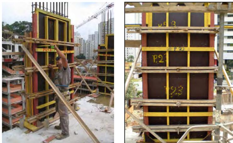
Figura 4.17 – Fôrma para molde dos pilares.
