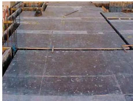
*Figura 4.22 – Assoalho em madeira compensada plastificada.*
