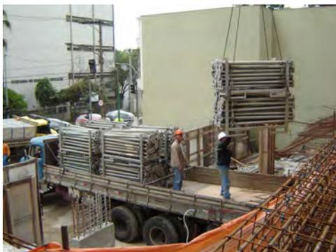
*Figura 4.37 – Transporte de cimbramento utilizando a grua.*
