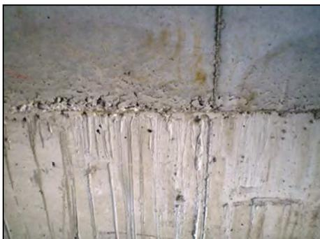
*Figura 3.9 – Pilar concretado com perda de água e finos de cimento, devido a frestas com dimensões acima da tolerância.*
