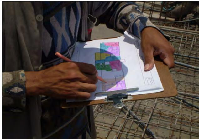
*Figura 4.28 – Preenchimento do mapa de concretagem pelo encarregado.*
