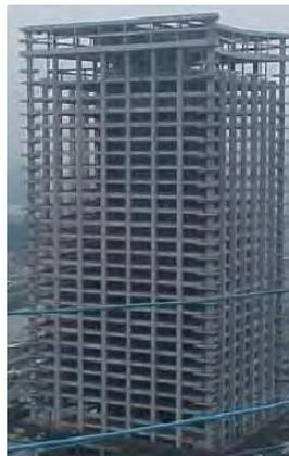
*Figura 3.2 – Estrutura de um edifício executada em concreto armado.*
