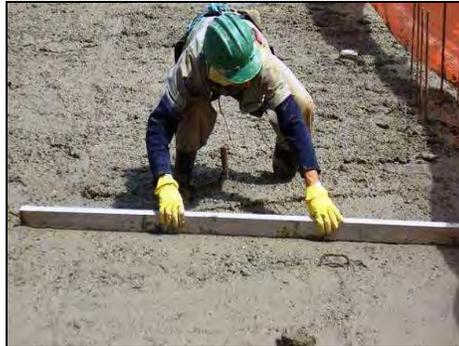
*Figura 3.61 – Nivelamento do concreto com réguas de alumínio.*
