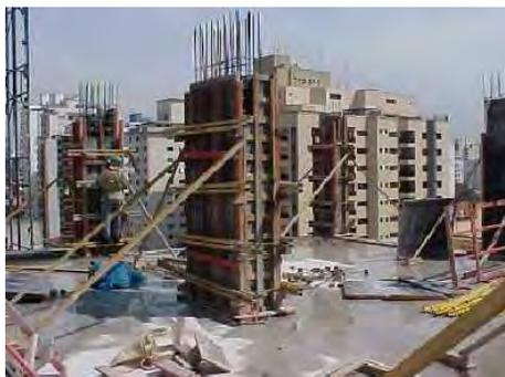
*Figura 3.8 – Estrutura de uma laje recém concretada.*
