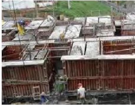
*Figura 3.19 – Molde metálico para fôrmas de paredes.*
