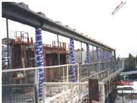
*Figura 3.18 – Molde em papelão para fôrma de pilares.*
