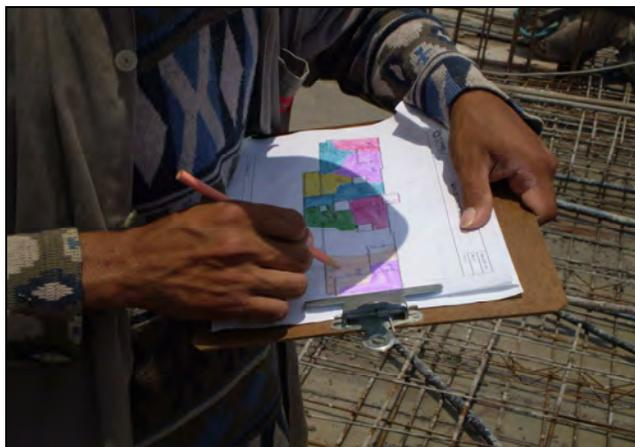
*Figura 3.57 – Mapa de concretagem sendo preenchido pelo encarregado do pavimento.*
