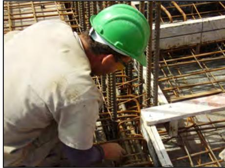
*Figura 3.49 – Encontro da armadura da viga e do pilar: grande quantidade de barras e a dificuldade do armador em recolocar os estribos.*
