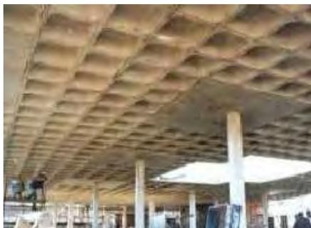
*Figura 3.4 – Rugosidade de uma laje executada com molde plástico (após desforma).*
