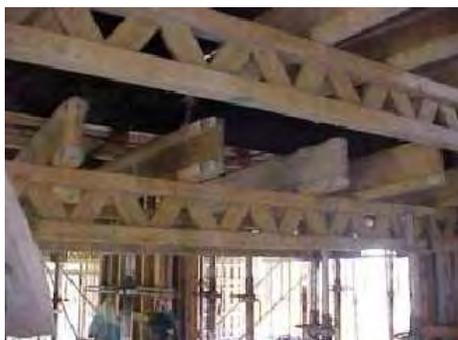
*Figura 3.13 – Molde de laje com estruturação em madeira.*
