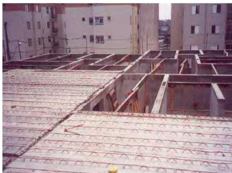
*Figura 3.14 – Molde em pré-laje.*
