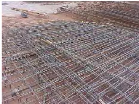
*Figura 3.48 – Pré-montagem da armação de uma laje.*
