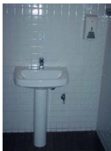
Figura 33: Lavatório com coluna, e altura incorreta da saboneteira
