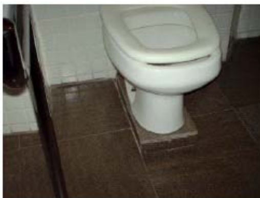
Figura 34: Bacia sanitária com altura incorreta
