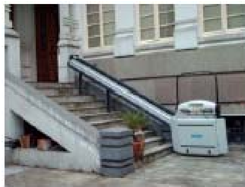
Fonte: Autora da Monografia Figura 20: Elevador de percurso inclinado
