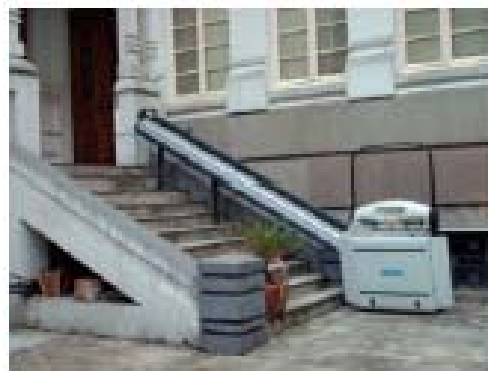
Figura 25: Elevador de percurso inclinado
