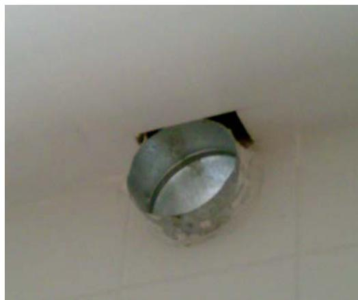
**Figura 32** – Detalhe da saída do duto da coifa pela área de serviço interferindo com o forro de gesso.
