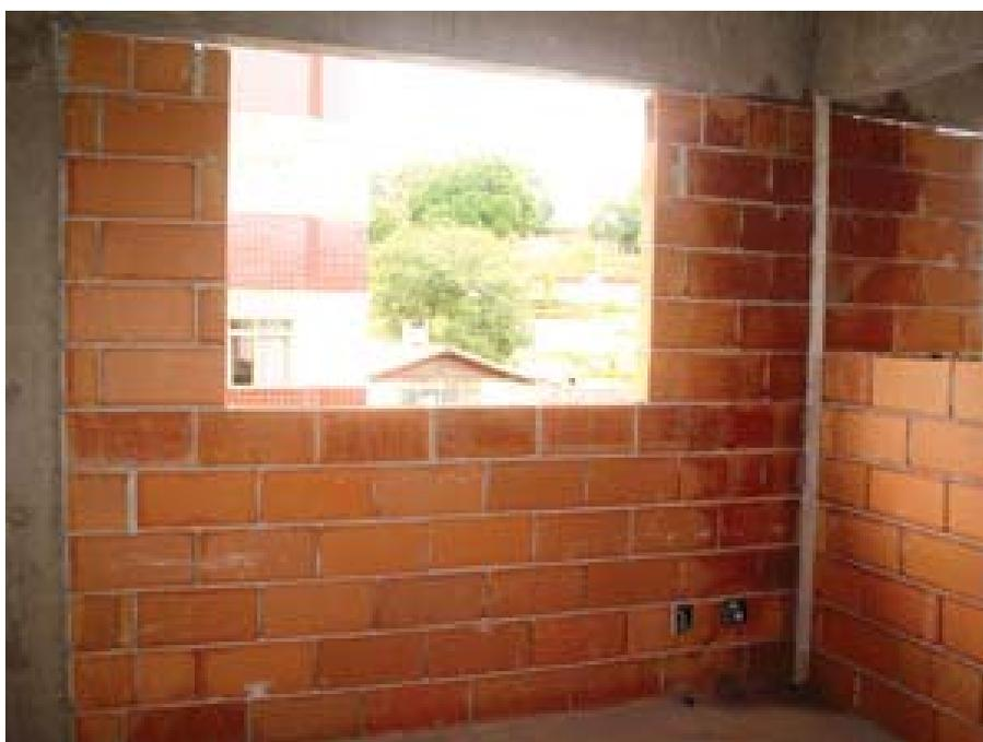
**Figura 4** – Alvenaria de vedação conforme um projeto de vedações.
