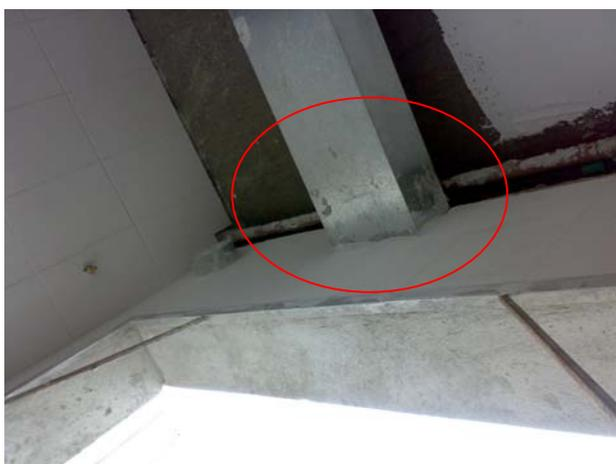
**Figura 12** – Saída do duto da coifa para a área externa do edifício.
