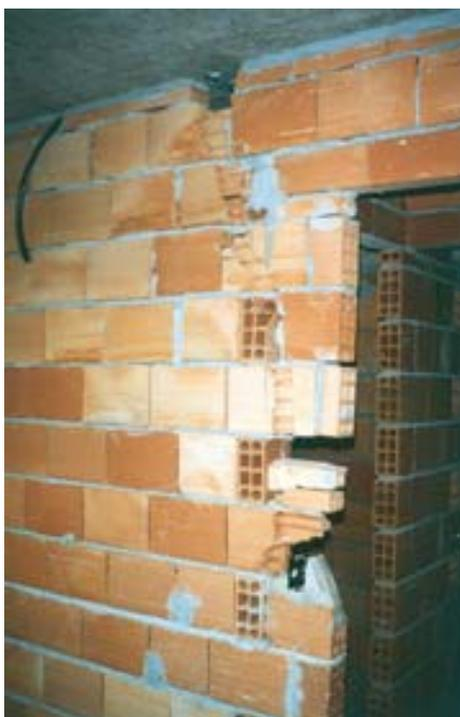
**Figura 3** – Exemplo de alvenaria de vedação tradicional.
