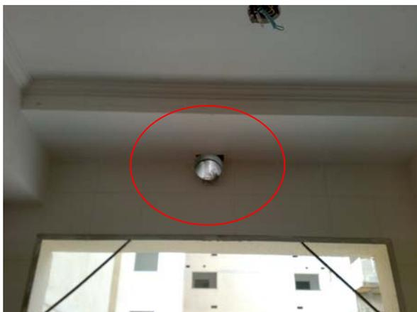
**Figura 31** – Vista da parede da área de serviço com a saída do duto da coifa.
