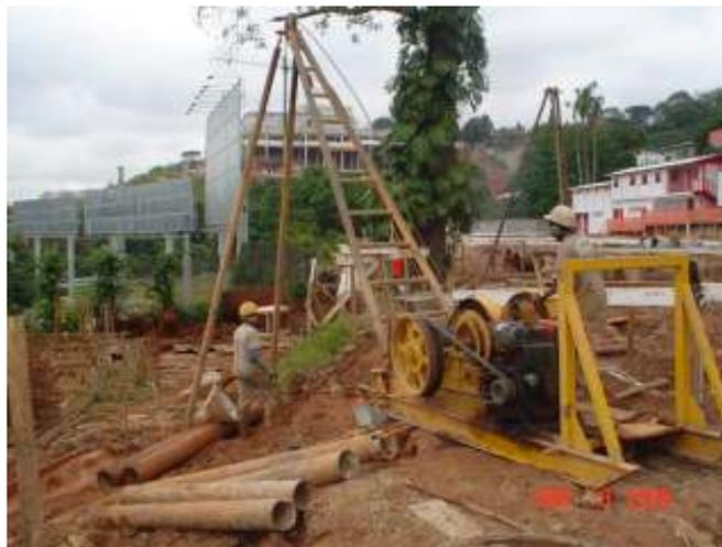
Fig. 3.35 - Detalhe do equipamento de execução das estacas tipo Straus
