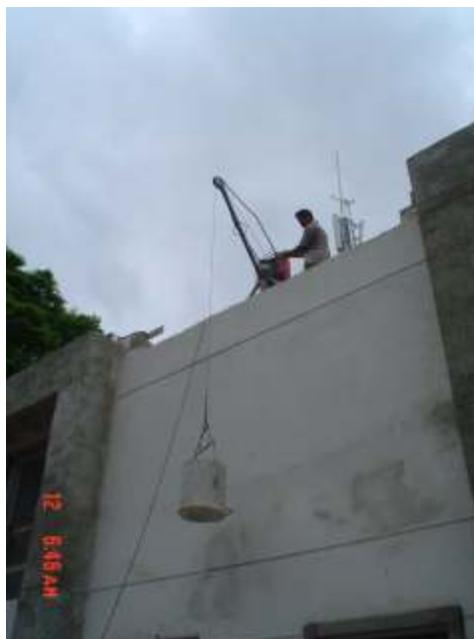
Fig. 3.57 - Detalhe do transporte vertical com mini-grua
