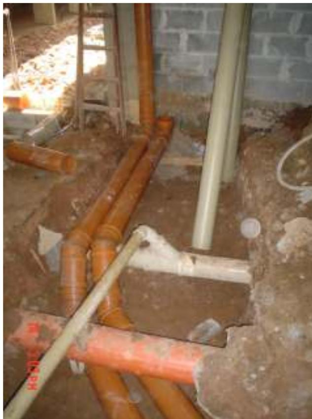
Fig. 3.63 - Detalhe do cruzamento das tubulações de águas pluviais
