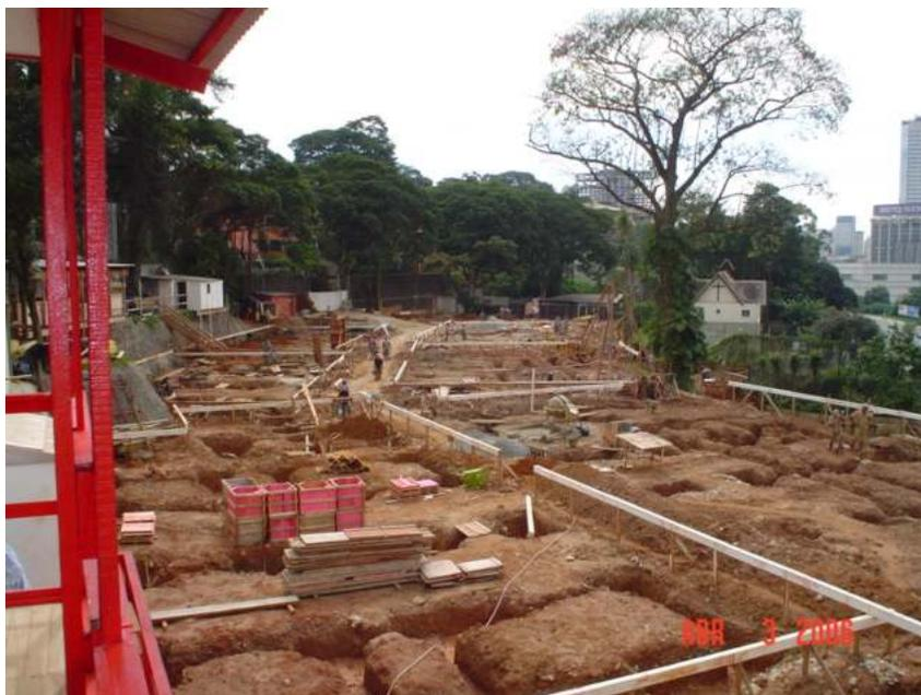
Fig. 3.33 - Detalhe dos gabaritos de locação da obra
