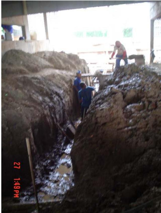
Fig. 3.59 – Detalhe da escavação manual para execução da tubulação enterrada
