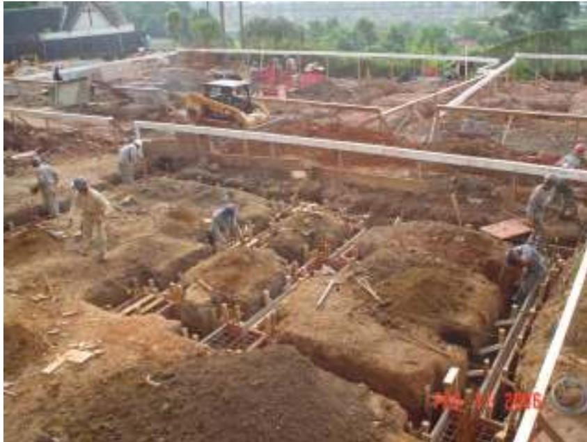
Fig. 3.36 – Detalhe da escavação manual de baldrame
