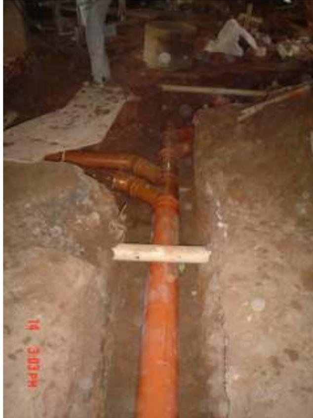
Fig. 3.61 - Detalhe do cruzamento de tubulações hidráulicas no piso do subsolo
