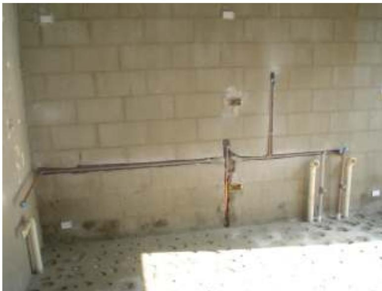
Fig. 3.46 – Detalhe da distribuição hidráulica – sistema convencional
