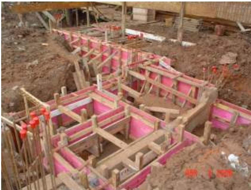
Fig. 3.38 - detalhe da fôrma dos baldrames
