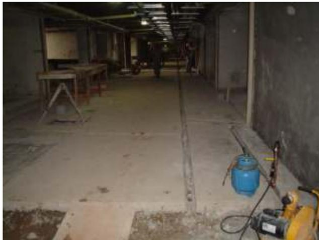
Fig. 3.62 - Detalhe da tubulação de gás embutida no piso do subsolo
