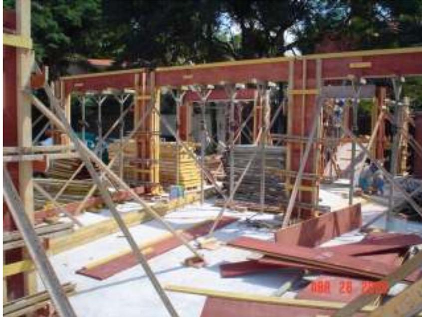
Fig. 3.51 - Execução da montagem da fôrma de madeira
