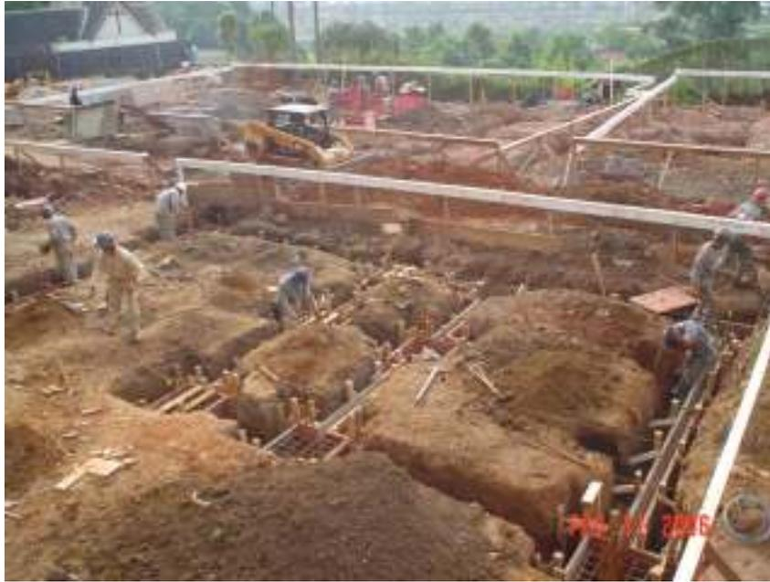
Fig. 3.40 - Detalhe da execução dos baldrames
