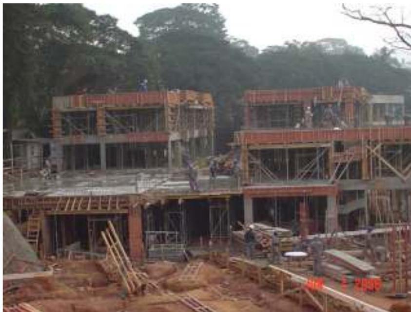
Fig. 3.52 – Ilustração dos tipos diferentes de fôrma / quantidade excessiva de concretagens sobre terreno
