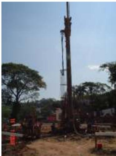
Fig. 3.34 – Detalhe do equipamento de execução das estaca tipo Hélice Continua
