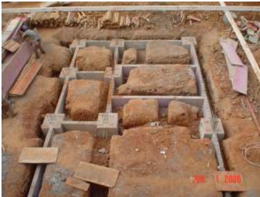
Fig. 3.41 - Detalhe da execução dos baldrames
