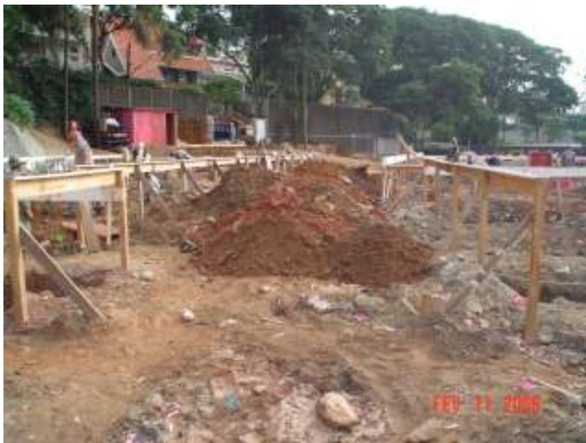
Fig. 3.37 – Detalhe do volume de terra proveniente da escavação dos baldrame
