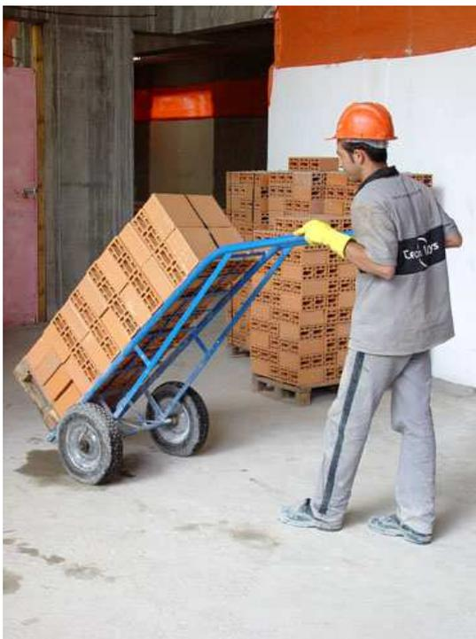
Figura 18 - Transporte de bloco utilizando carrinho porta pallet.
