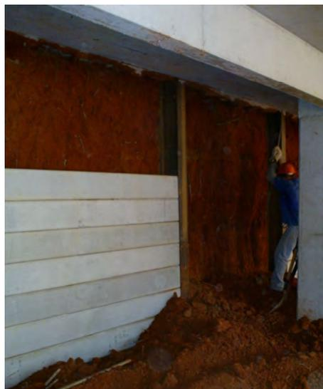
Foto 13 - Escavação manual e plaqueamento no 2 subsolo.
