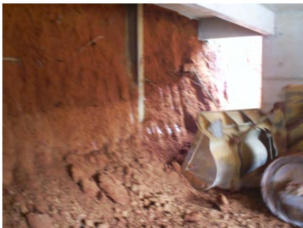
Foto 12 - Escavação do talude remanescente no 2 subsolo.
