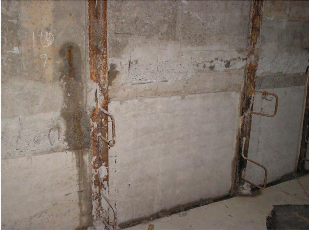
Foto 16 - Trecho já concretado e ainda com os gancho soldados nos perfis.
