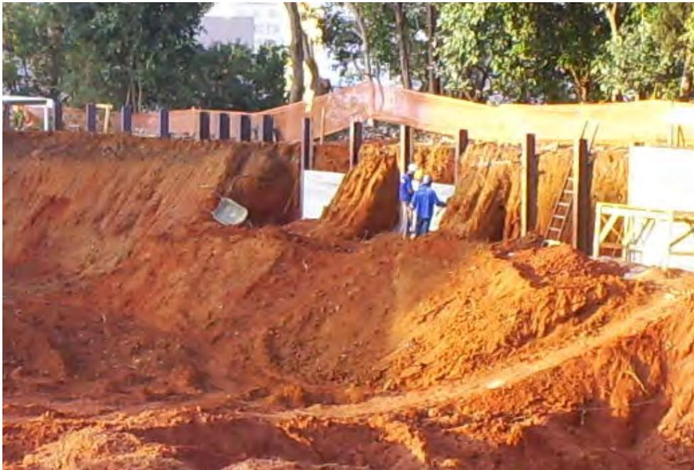
Foto 4 – Perfil metálico já cravado e abertura intercalada dos cachimbos para a colocação dos pré-moldados no trecho 3;
