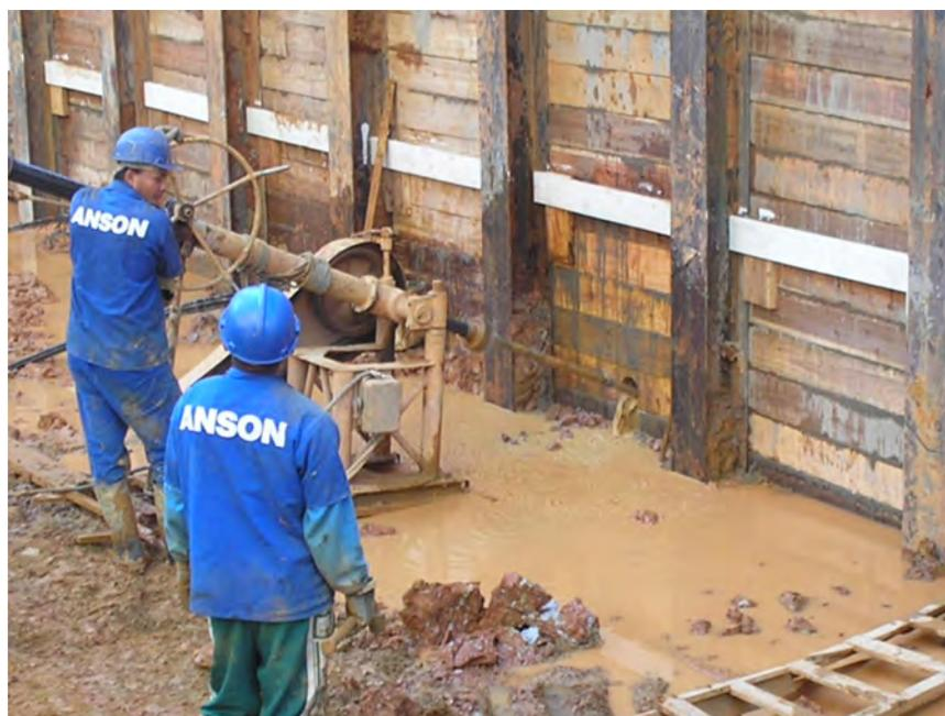
Foto 15 - Atirantamento da cortina com as pranchas de madeira já colocadas.
