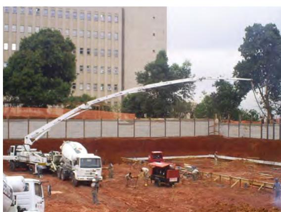
Foto 11 - Lançamento do concreto com bomba lança.
