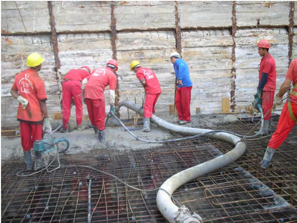
Foto 18 - Concretagem da cortina junto com a laje da periferia.
