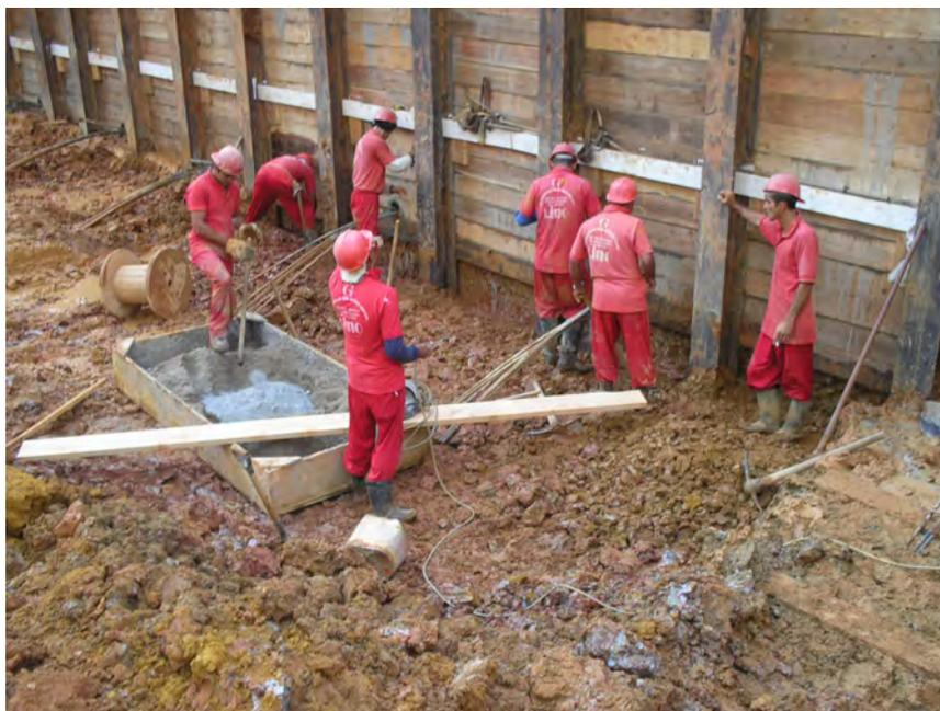
Foto 14 – Em destaque a prancha de madeira com 4 m e a preparação da pasta de cimento.
