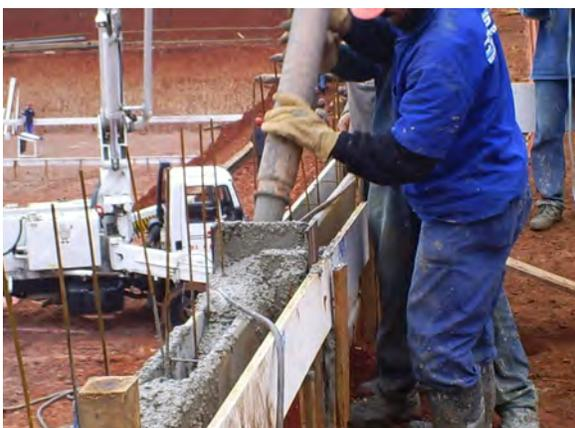
Foto 10 - Concretagem com mangote de 3 polegadas.
