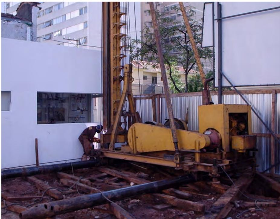
Foto 1 - Bate estaca utilizado para cravar os perfis de aço.
