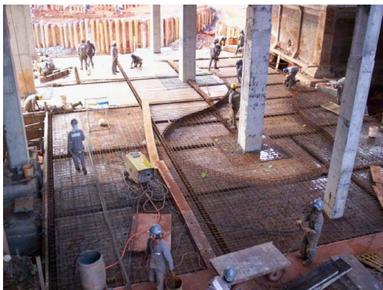
Foto 4.18 – Vista da piscina coberta infantil na fase de montagem das armaduras. Fonte: Registro da obra.
