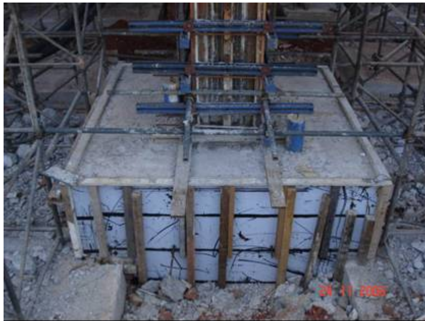
Foto 4.11 – Novo bloco concluído. Fonte: Registro da obra.
