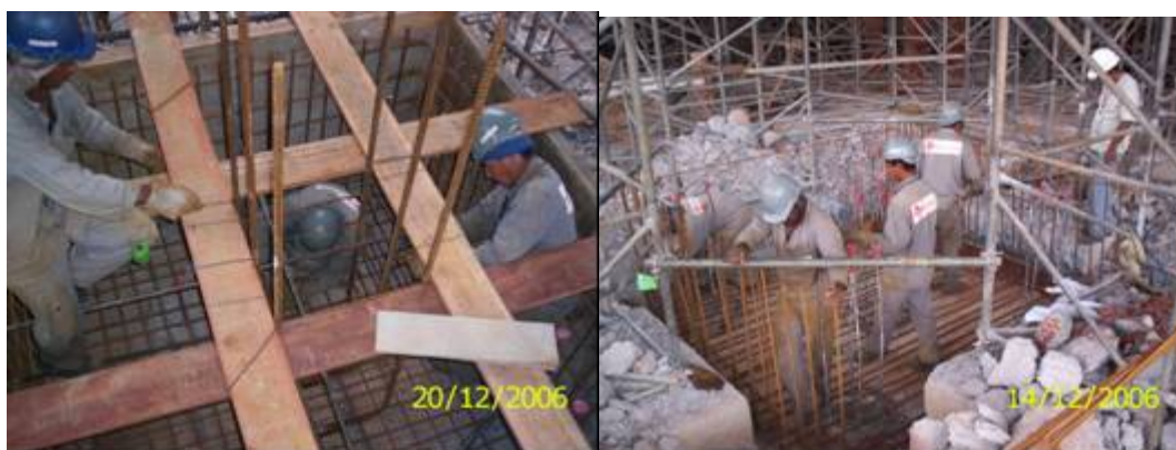
Foto 4.10 – Execução do novo bloco com os arranques para o pilar a ser prolongado. Fonte: Registro da obra.
