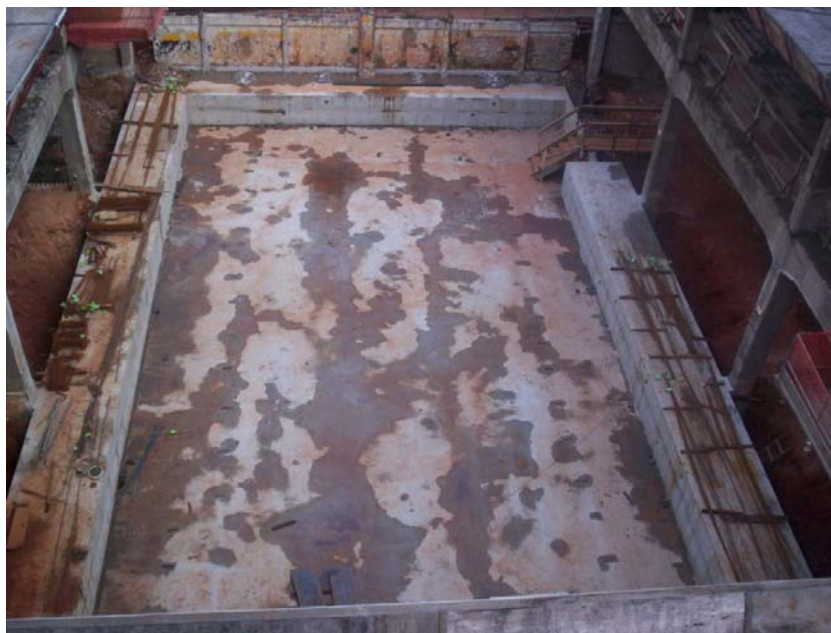
Foto 4.16 – Vista ampliada da Torre Leste em fase de demolição da fachada e rebaixamento das fundações. Fonte: Registro da obra.
