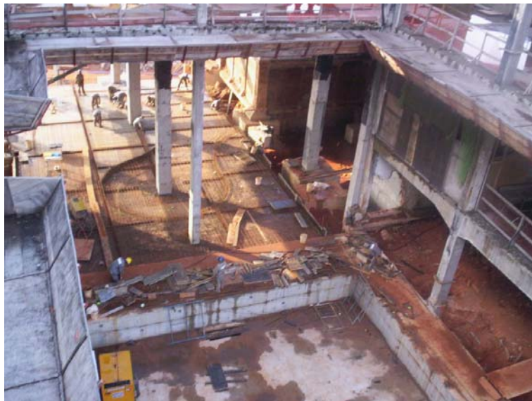
Foto 4.17 – Vista do vão central da Torre Leste para a piscina coberta infantil. Fonte: Registro da obra.
