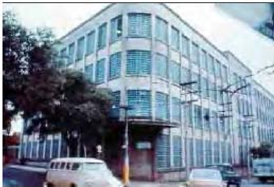
Foto 4.4 – Fachada da Torre Oeste, localizada na Avenida Álvaro Ramos (VASQUES, 2005)
