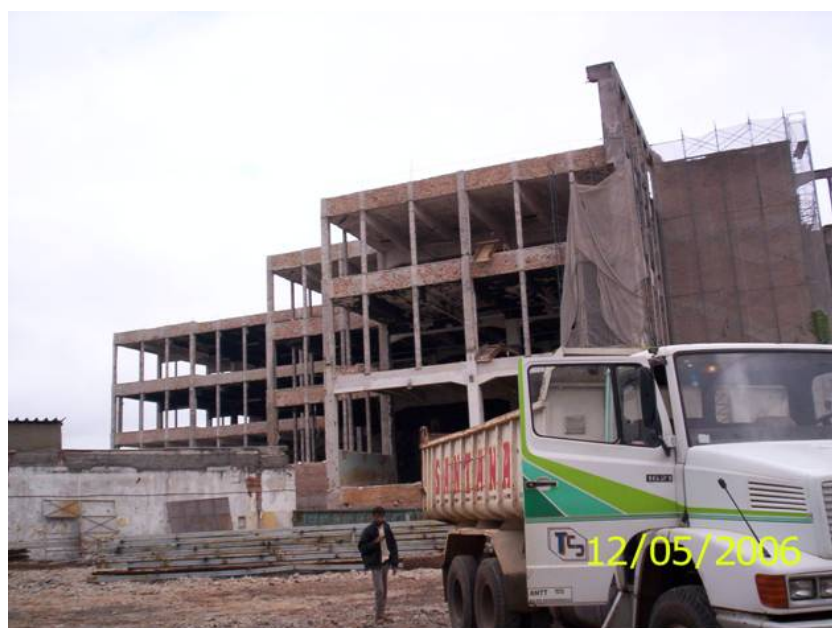
Foto 4.14 – Vista da Torre Leste em fase de demolição da fachada. Fonte: Registro da obra.
