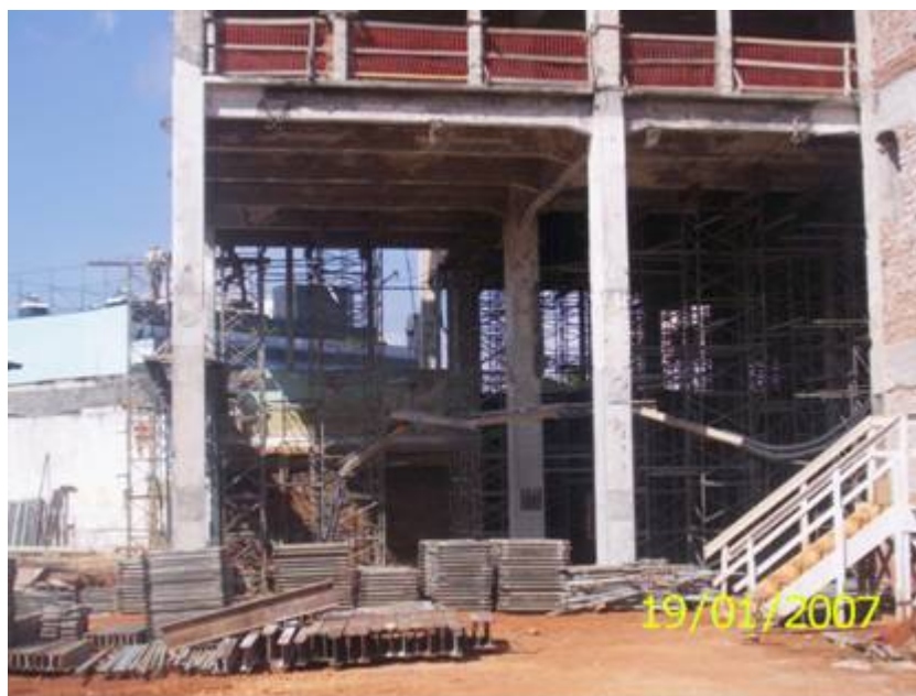
Foto 4.13 – Fundação rebaixada e pilar reconstituído. Fonte: Registro da obra.
