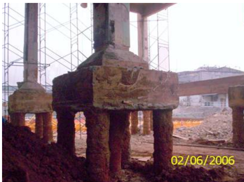
Foto 4.7 – Escavação total dos blocos para iniciar o rebaixamento. Fonte: Registro da obra.
