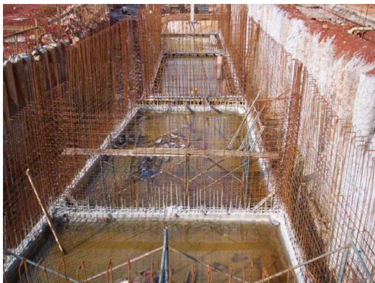
Foto 4.20 – Armação dos reservatórios de água potável. Fonte: Registro da obra.
