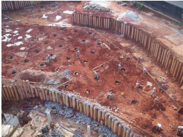
Foto 4.19 – Vista da piscina coberta infantil na fase de montagem das armaduras. Fonte: Registro da obra.
