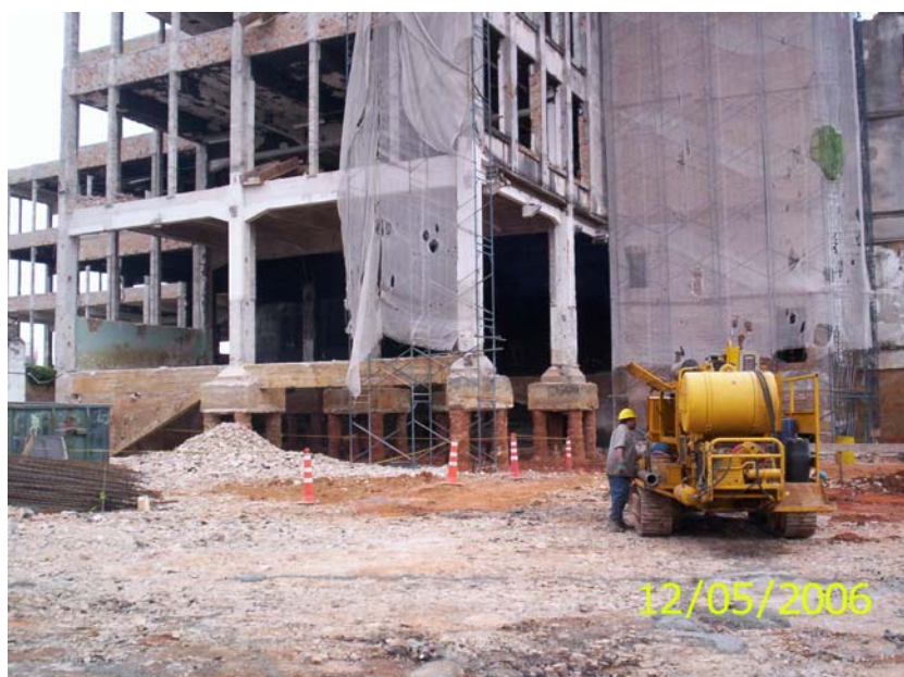
Foto 4.15 – Vista ampliada da Torre Leste em fase de demolição da fachada e rebaixamento das fundações. Fonte: Registro da obra.
