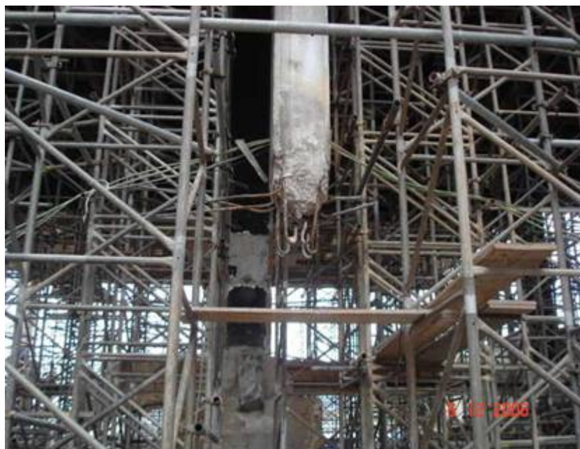
Foto 4.9 – Demolição de pilar e bloco . Fonte: Registro da obra
