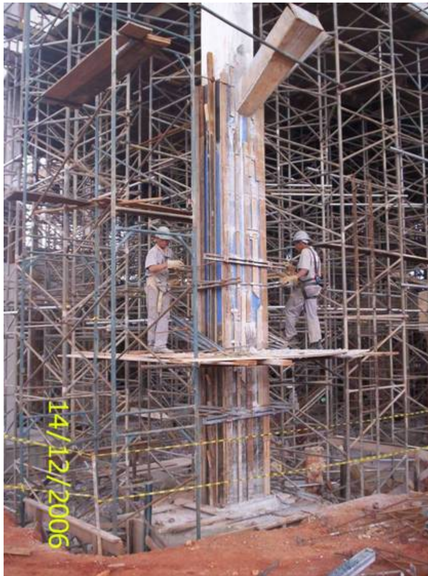
Foto 4.12 – Forma do pilar complementado. Fonte: Registro da obra.
