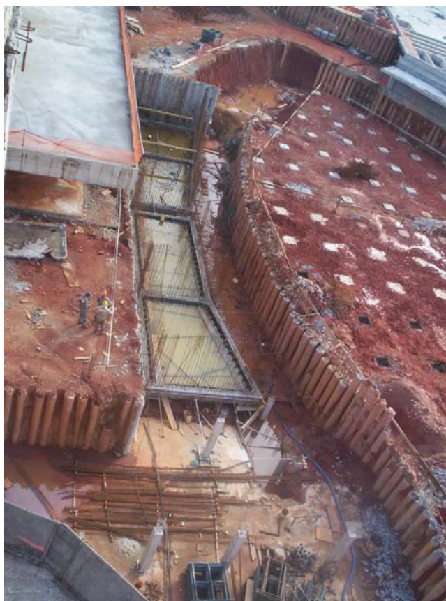
Foto 4.21 – Armação dos reservatórios de água potável, contenção em estacas hélice contínua e entre o reservatório e as estacas, esta posicionado o túnel técnico. Fonte: Registro da obra.
