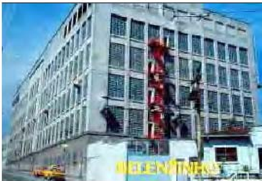
Foto 4.5 – Fachada da Torre Leste, localizada na Rua Tobias Barreto (VASQUES, 2005)
