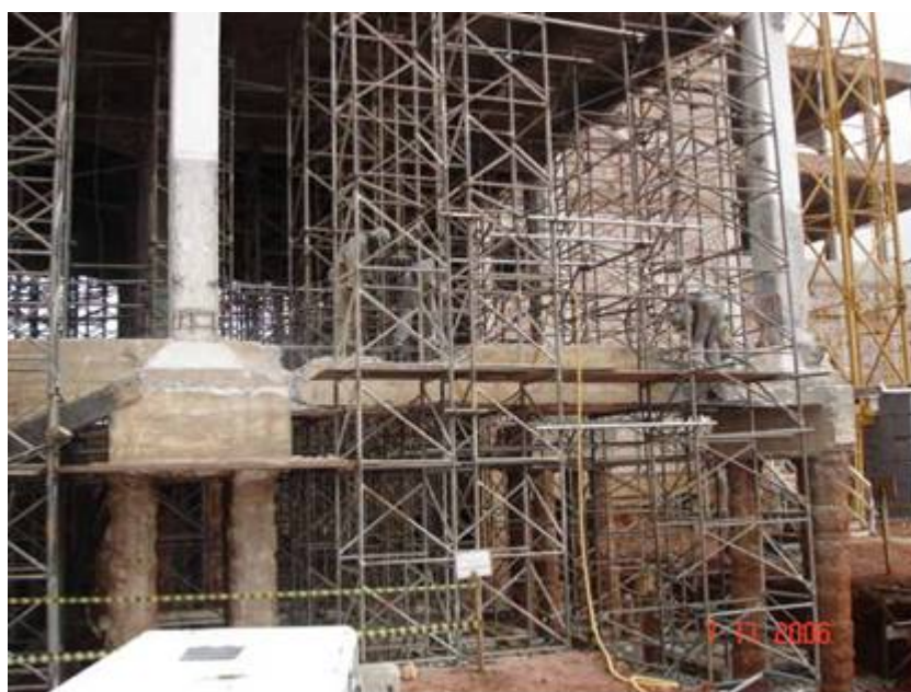
Foto 4.8 – Demolição dos blocos após realizado o cimbramento. Fonte: Registro da obra.
