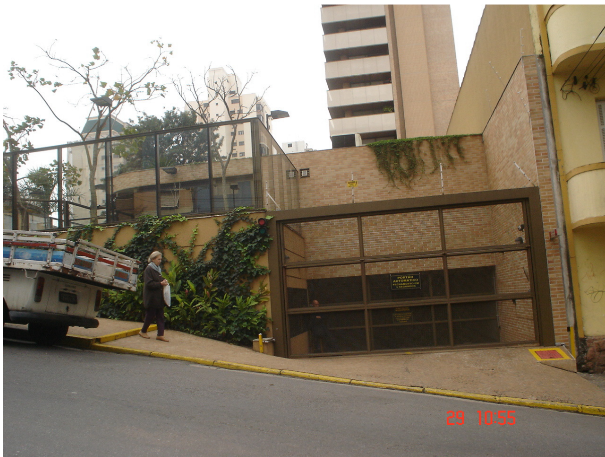
Fotografia 9 – Entrada de veículos – Edifício Ravello.
