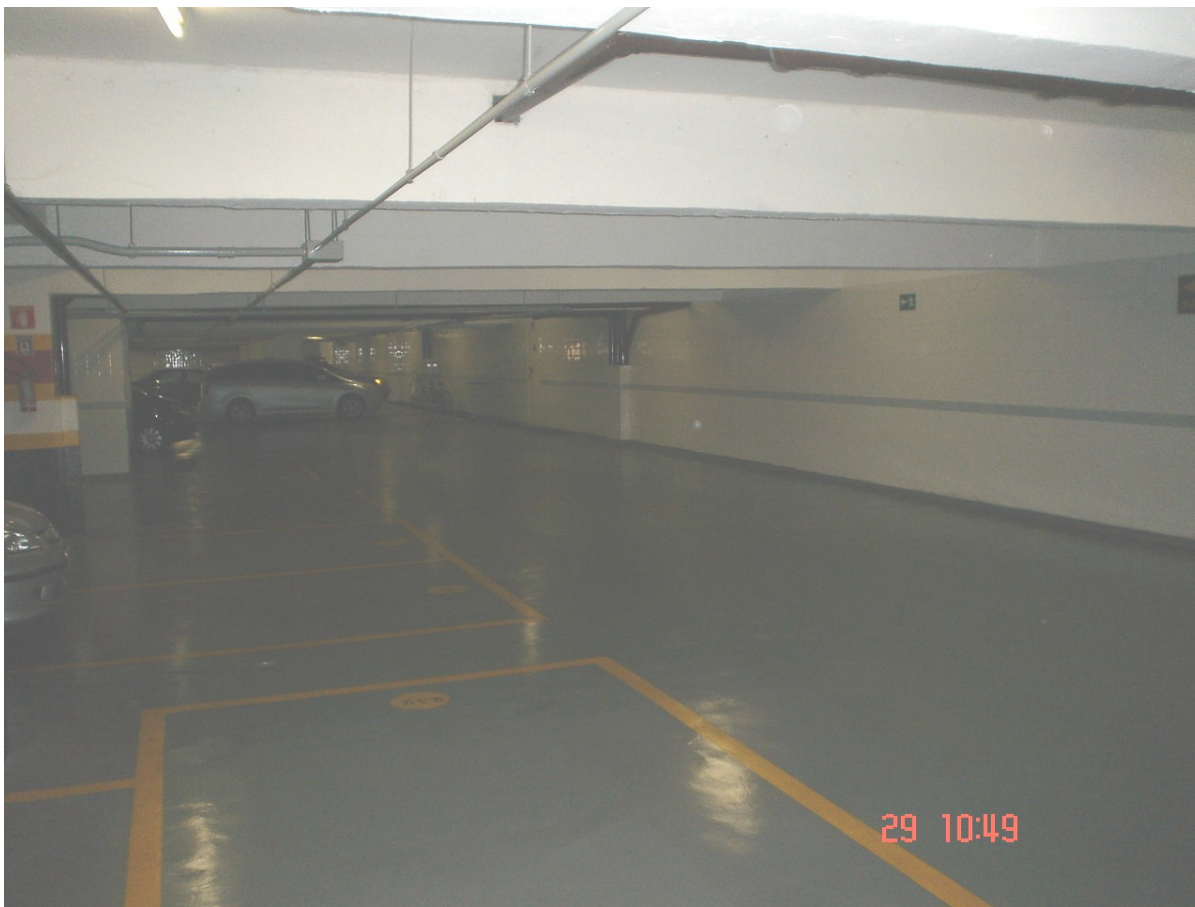
Fotografia 8 – Área de estacionamento / circulação veículos subsolo – Edifício Ravello.
