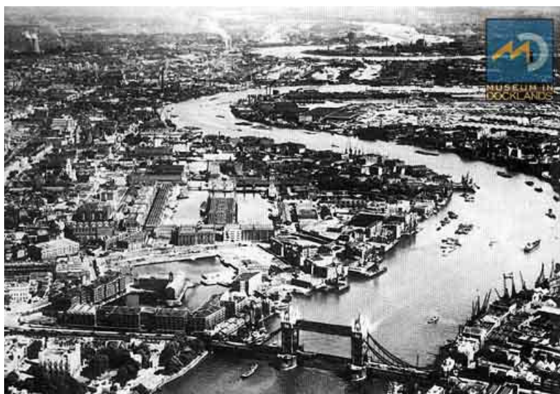
Figura 02 – Vista aérea da London Dock, desativada em 1968
