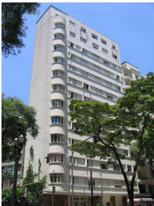
Figura 16 – Fachada do Edifício Maria Paula
