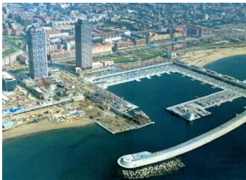
Figura 10 – Obras da vila olímpica
