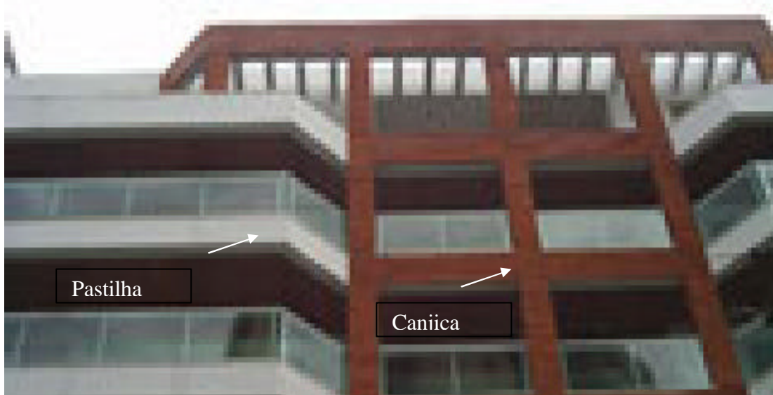
Figura 4.7 – Detalhe da Fachada em Pastilha de Vidro e Pedra Canjica, Empreendimento: Rio Tapajós
