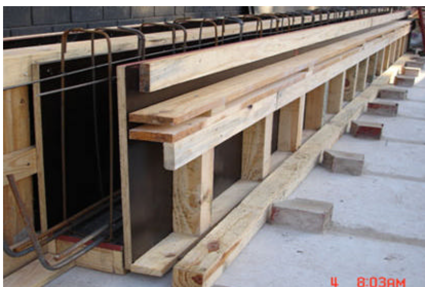
Figura 4.9 – Fôrma para viga pré-moldada Empreendimento: Acervo
