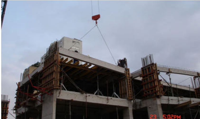
Figura 5.0 - Montagem da Viga Pré-moldada Empreendimento: Acervo
