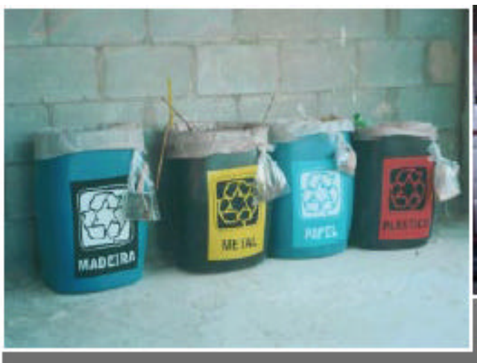
Figura 4.2 – Bombonas dispostas nos andares
