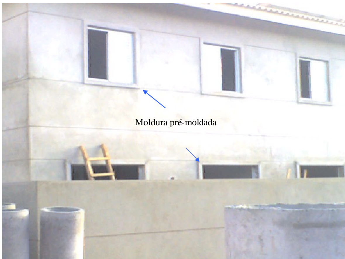
Figura 5.3– Instalação das Molduras Pré-moldadas Empreendimento: Terra Bonita
