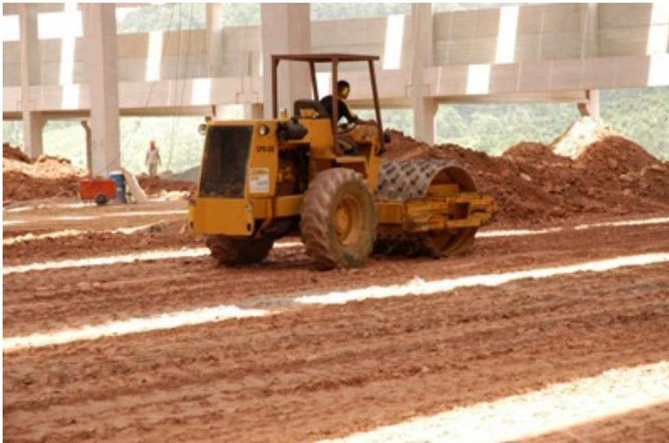
Figura 4.4 – Equipamento rolo compactador tipo pé de carneiro
