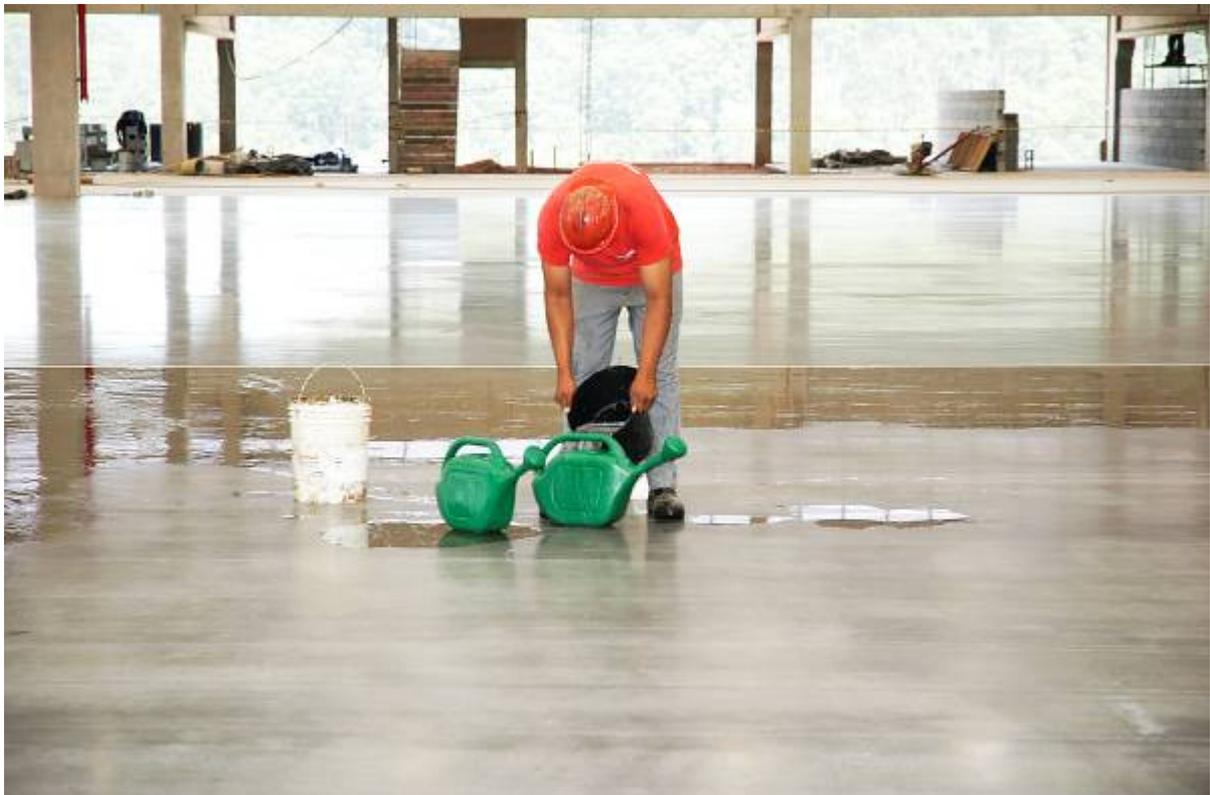
Figura 2.5 – Dosagem de produto endurecedor de superfície de solução aquosa para aplicação.
