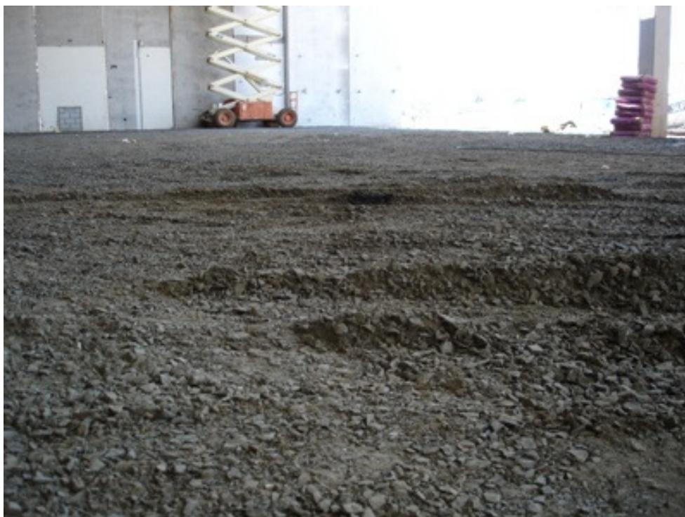
Figura 4.6 – Material granular para execução de sub-base
