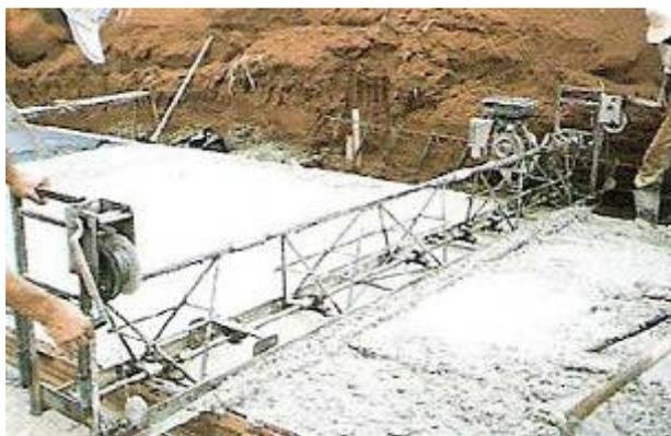
Figura 4.16 – Régua vibratória treliçada (Fonte ABCP s.d.)
