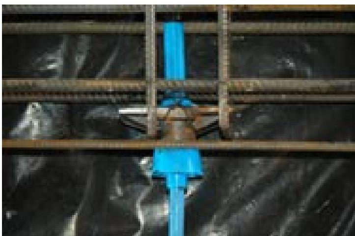
Figura 4.12 – Detalhe da armação de fretagem
