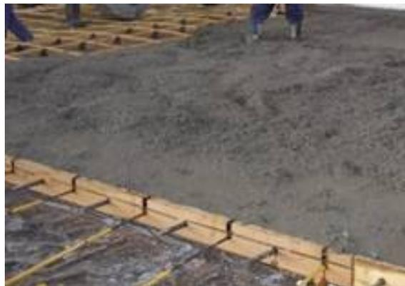
Figura 4.10 – Vista da furação e encaixe das fôrmas
