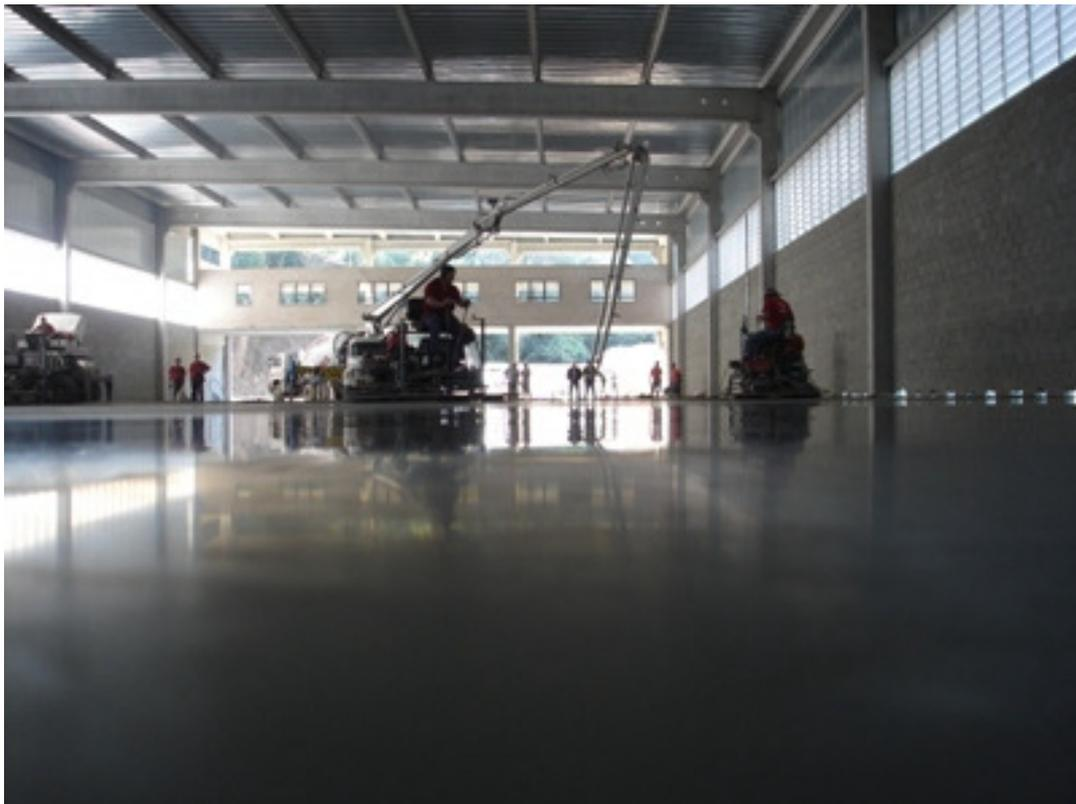
Figura 4.23 – Acabamento final tipo liso vítreo executado com acabadoras duplas de alta rotação
