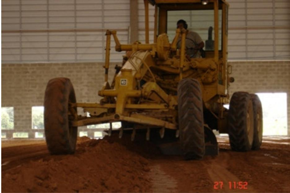
Figura 4.3 – Motoniveladora (Patrol)
