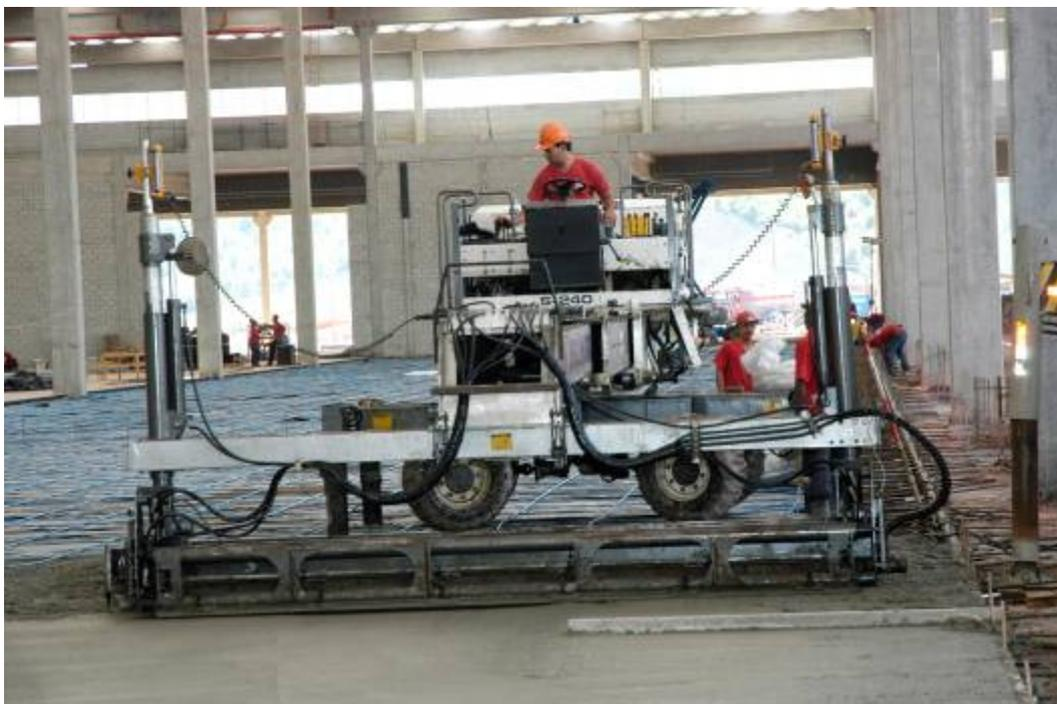
Figura 3.5 – Equipamento de adensamento, sarrafeamento e nivelamento do concreto.
