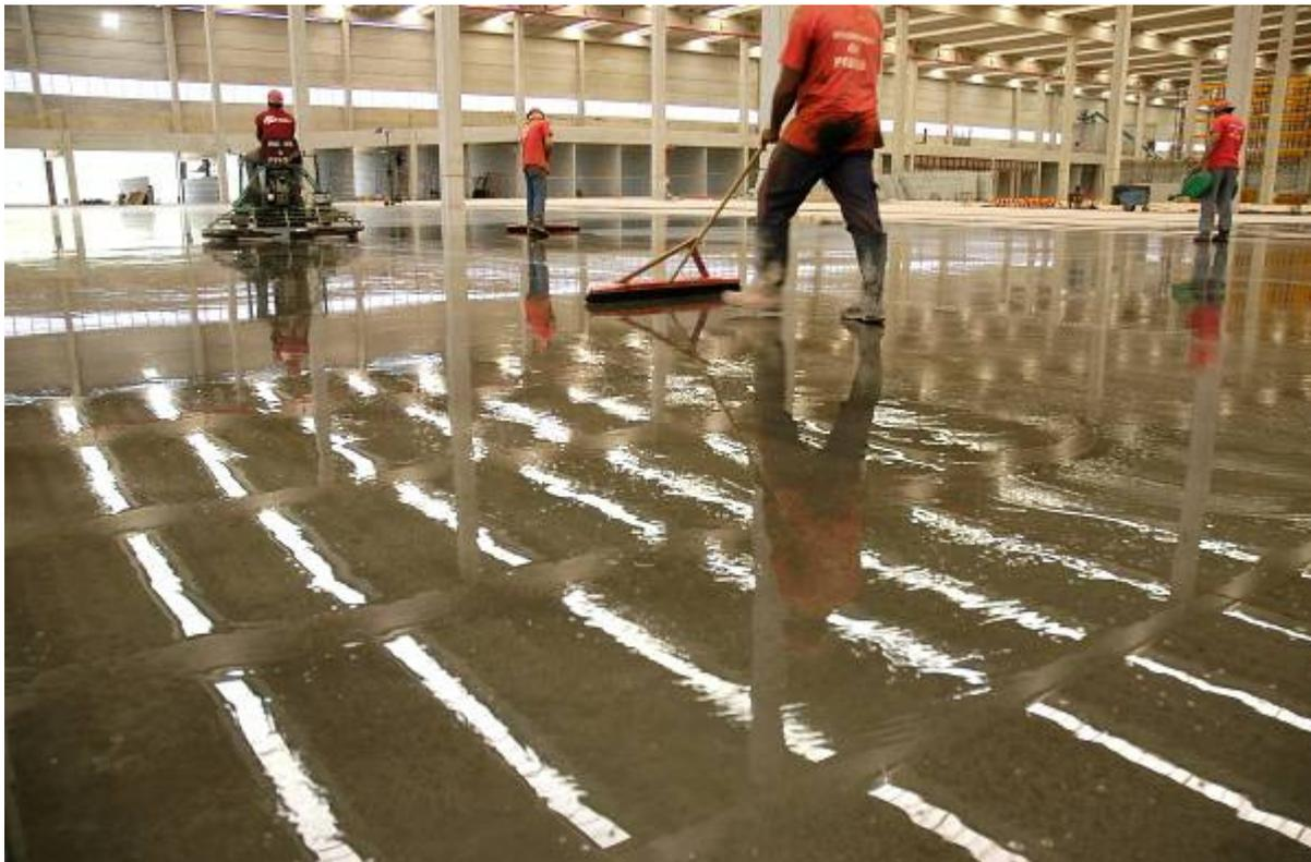
Figura 2.6 – Aplicação e espalhamento de endurecedor de superfície de solução aquosa.
