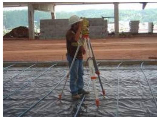
Figura 4.28 – Nivelamento com utilização de nível óptico.
