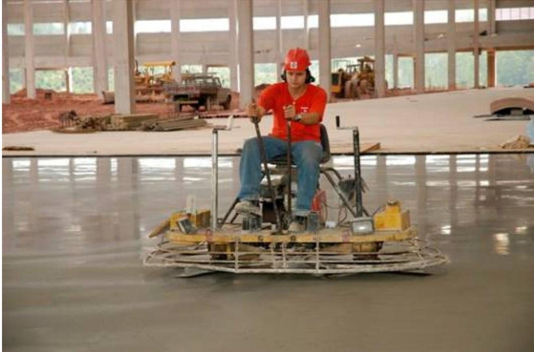
Figura 4.22 – Acabadora de superfície duplada, com a utilização de pás para o acabamento final.
