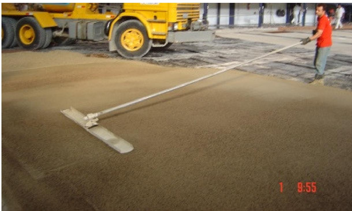
Figura - 4.19 – Aplicação de rodo tipo *float*
