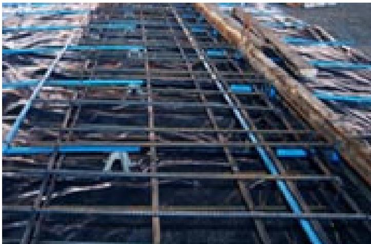
Figura 4.13 – Vista das armações ativas e passivas
