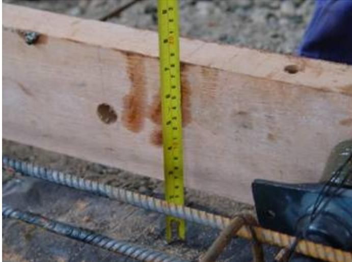
Figura 4.29 – Detalhe de posicionamento da forma
