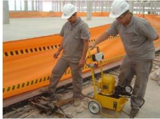
Figura 4.25 – Operação de protensão dos cabos
