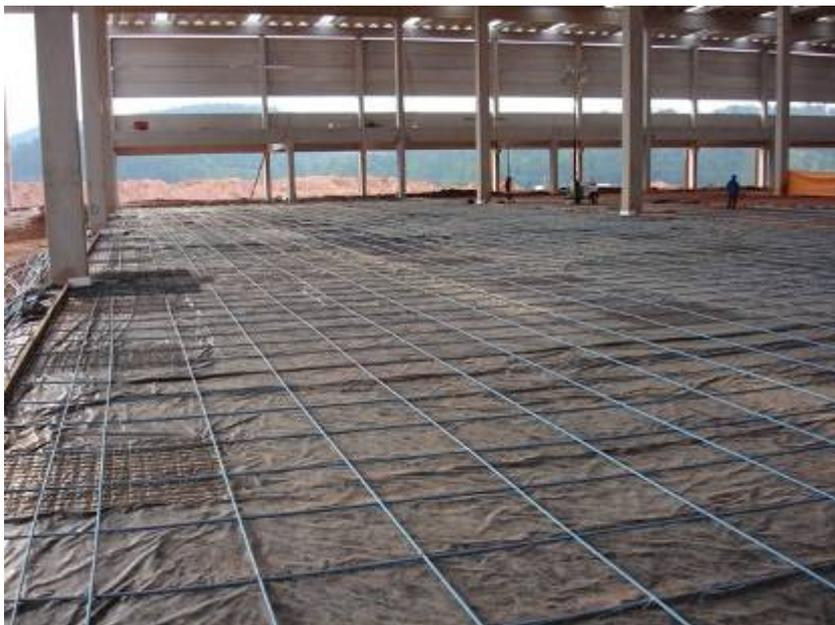
Figura 2.11 – Vista de sistema de protensão não aderente em piso de concreto.
