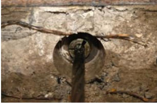
Figura 4.24 – Nicho de apoio do macaco de protensão junto à ancoragem
