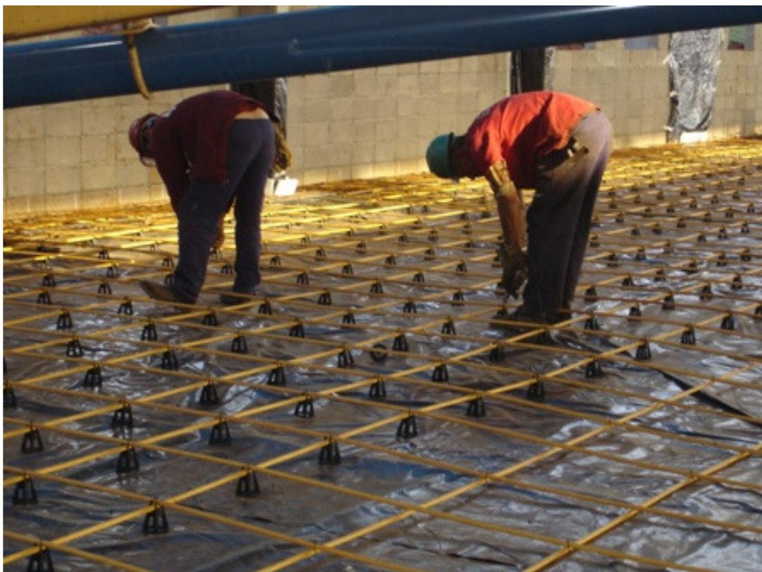
Figura 4.15 – Vista geral da armadura ativa devidamente posicionada com uso de espaçadores
