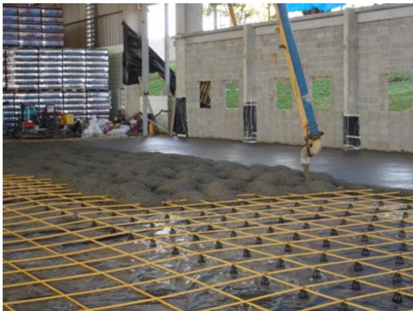
Figura 4.18 – Lançamento do concreto com utilização de bomba lança
