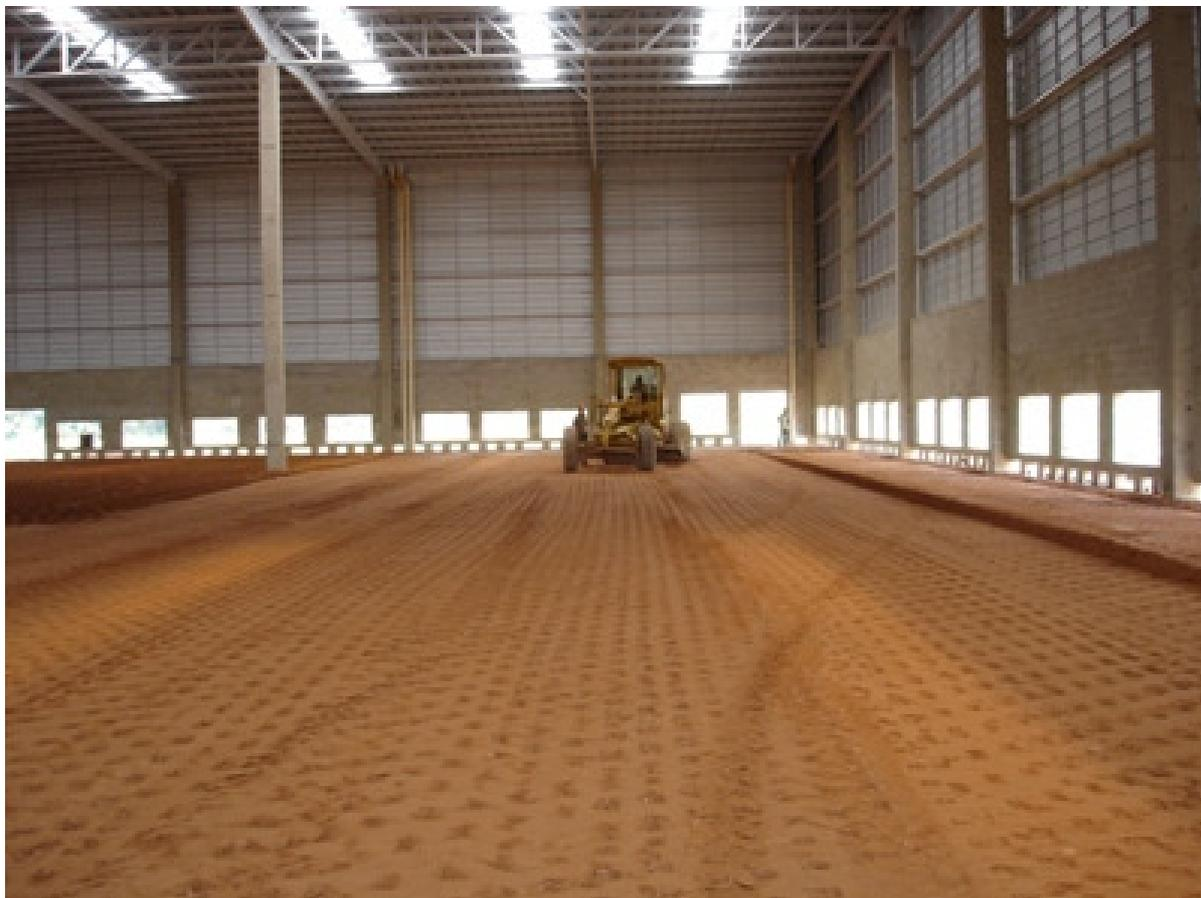
Figura 4.5 – Motoniveladora executando o acabamento final da superfície.
