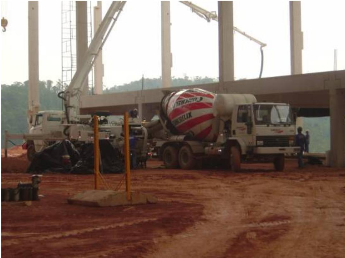
Figura 3.4 – Equipamentos de transporte e lançamento do concreto.
