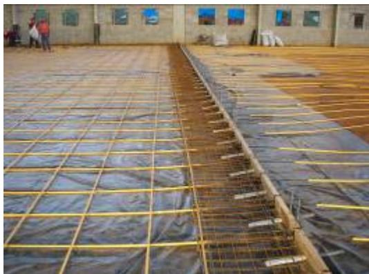
Figura 4.9 – Vista do posicionamento das fôrmas (alinhamento e nivelamento).
