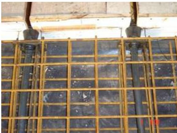
Figura 4.30 – Detalhe da armação passiva e posicionamento dos cabos e ancoragens
