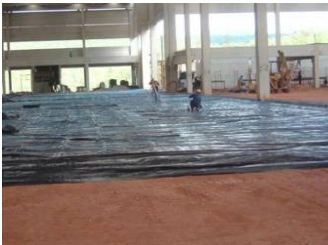
Figura 4.11 – Colocação da camada de deslizamento
