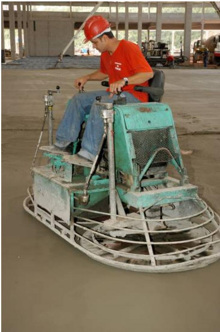
Figura - 4.20 – Acabadora dupla de superfície com disco de flotação, empregada no desempenamento mecânico.
