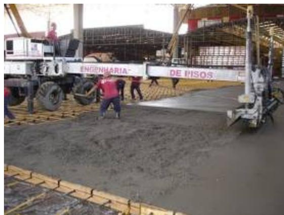
Figura 4.17 – Equipamento *Laser Screed*
