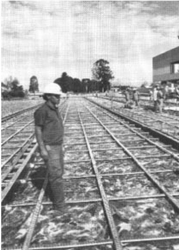
Figura 2.10 – Vista de sistema de protensão aderente em pavimento rígido. (Fonte Schmid 1997)
