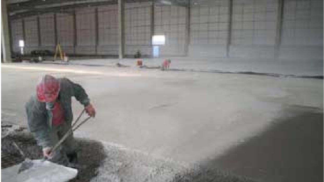
Figura 2.4 – “ Salgamento “ com agregado mineral e cimento na cor cinza.
