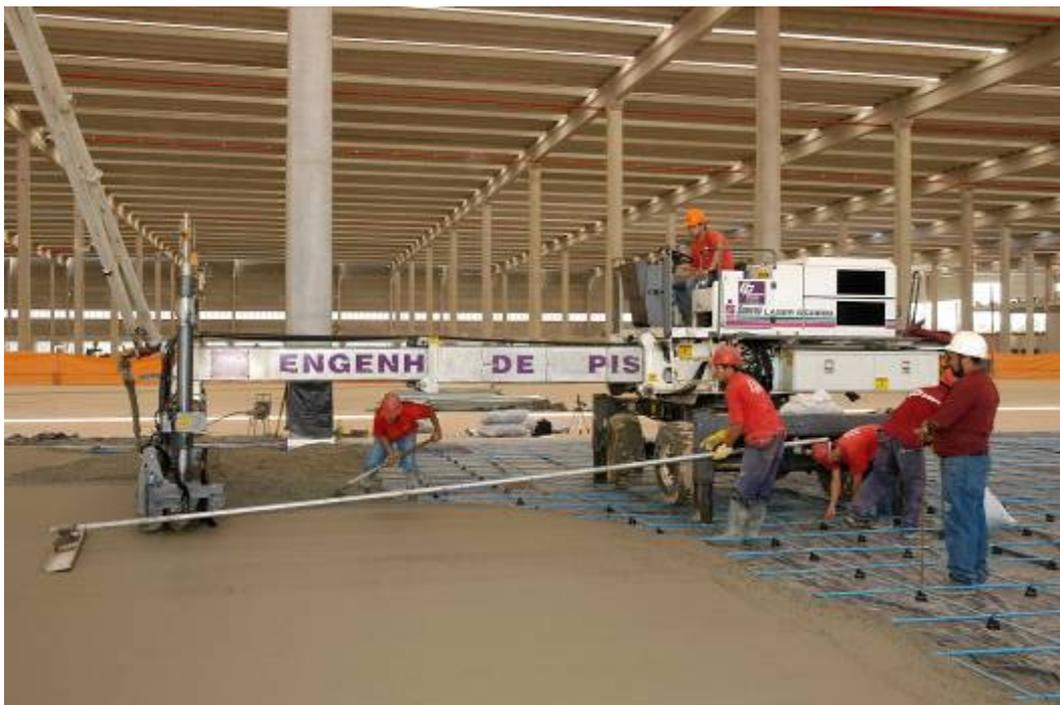
Figura 1.2 – Equipamento *Laser Screed* para nivelamento, adensamento e sarrafeamento do concreto <sup>1</sup>
