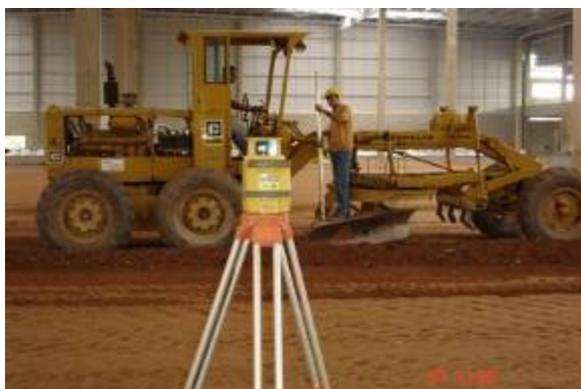
Figura 4.27 – Nivelamento com utilização de nível laser
