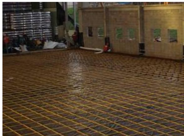
Figura 4.31 – Vista geral da armação dos cabos (armação ativa)
