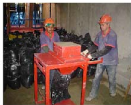
Figura 3.4 – Dosagem da areia com o uso de um dosador volumétrico.
