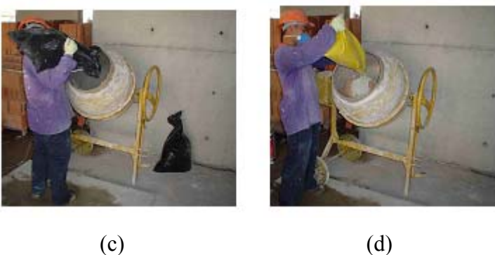
Figura 3.9 – Acrescentado o material para finalizar a mistura
