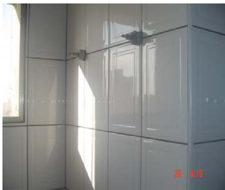
Figura 4.7: Aspecto final da cantoneira instalada
