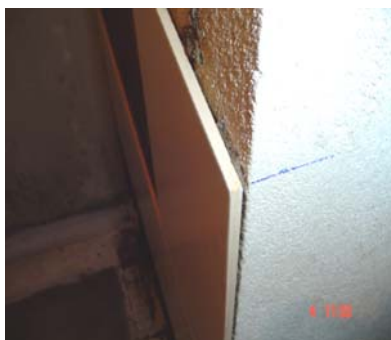
Figura 4.4: Colocação da placa cerâmica em um dos lados da parede
