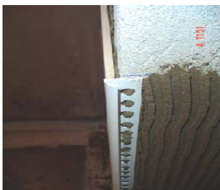
Figura 4.5: Cantoneira fixada com argamassa colante no lado da parede perpendicular ao que tem a cerâmica já aplicada.
