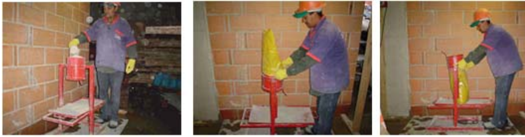
Figura 3.5 – Dosagem do cimento com o uso de um dosador volumétrico.
