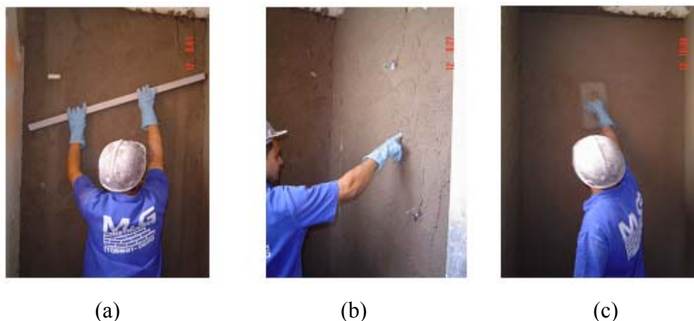
Figura 3.11 – Operações de execução do emboço
