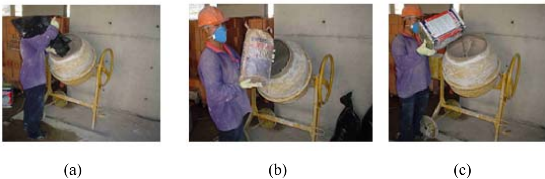
Figura 3.8 – Operações de mistura do emboço
