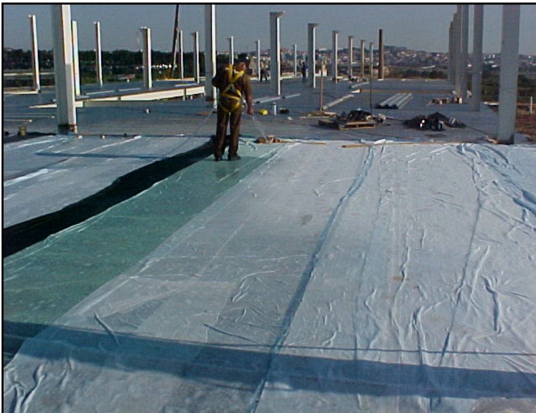
Ilustração 3-7 - Cura de lajes tipo Steel Deck. (Foto: Joaquin E. F. A. Oviedo)
