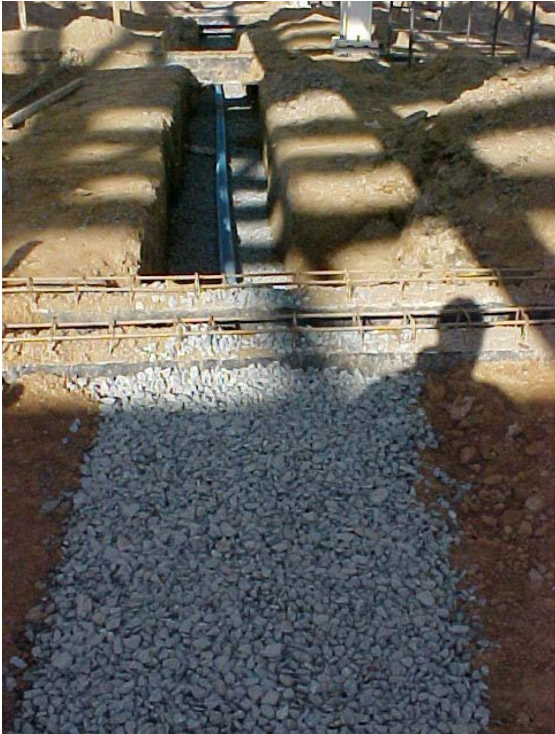
Ilustração 6-8 - Detalhe da finalização das trincheiras em pedra brita n.º 2. (Foto: Joaquin E. F. A. Oviedo)
