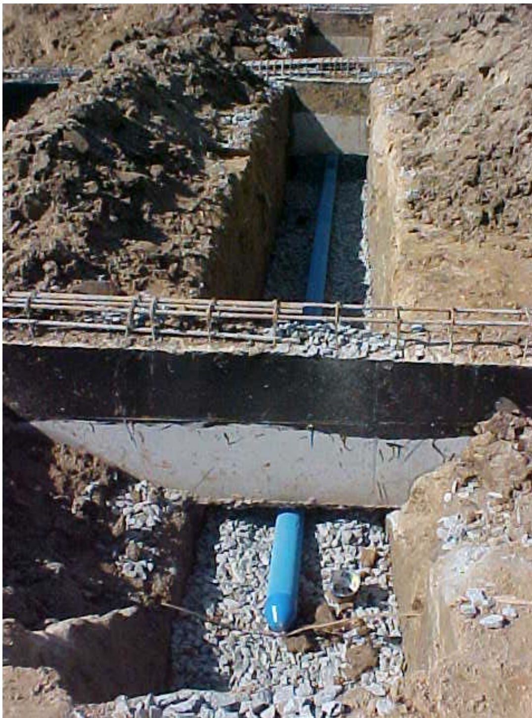
Ilustração 6-7 - Detalhe do final do tubo dreno, antes de ser acoplado o tubo liso. (Foto: Joaquin E. F. A. Oviedo)
