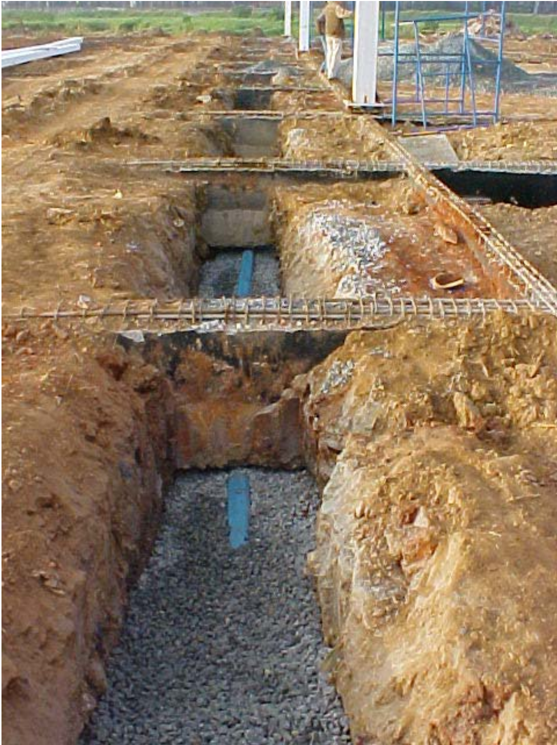
Ilustração 6-3 - Detalhe de travessia de tubos e trincheiras nas vigas baldrame. (Foto: Joaquin E. F. A. Oviedo)
