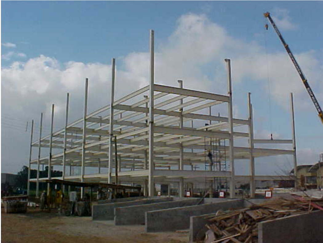
Ilustração 3-6 - Montagem de estrutura metálica. (Foto: Joaquin E. F. A. Oviedo)
