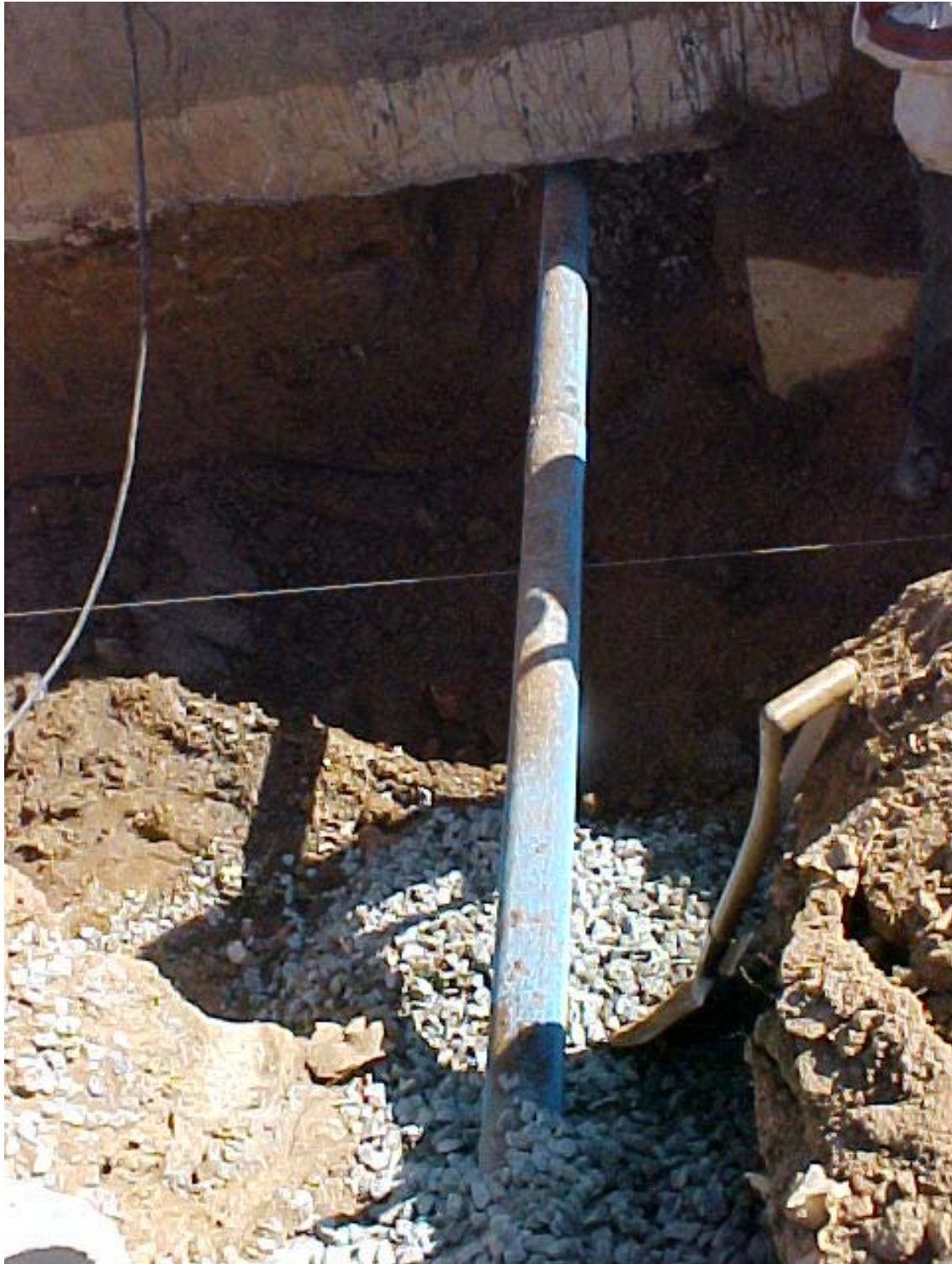
Ilustração 6-2 - Instalação de tubos geomecânicos nas trincheiras drenantes. (Foto: Joaquin E. F. A. Oviedo)
