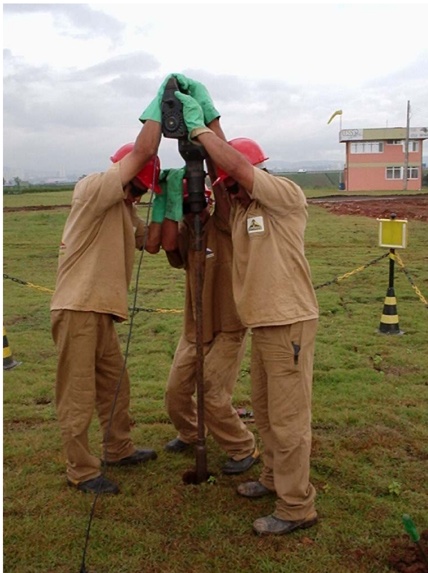
Ilustração 4-12 - Execução de poço de monitoramento (escavação) (Foto: Guedes B. P)
