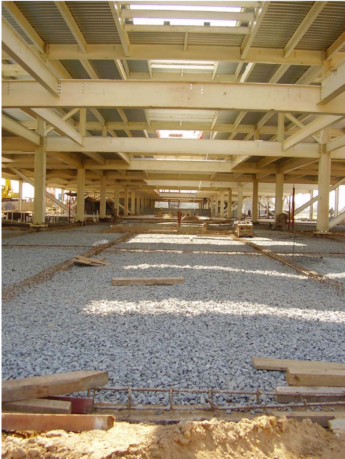
Ilustração 5-1 - Lastro de brita usado como tapete drenante (Foto: Joaquin E. F. A. Oviedo)
