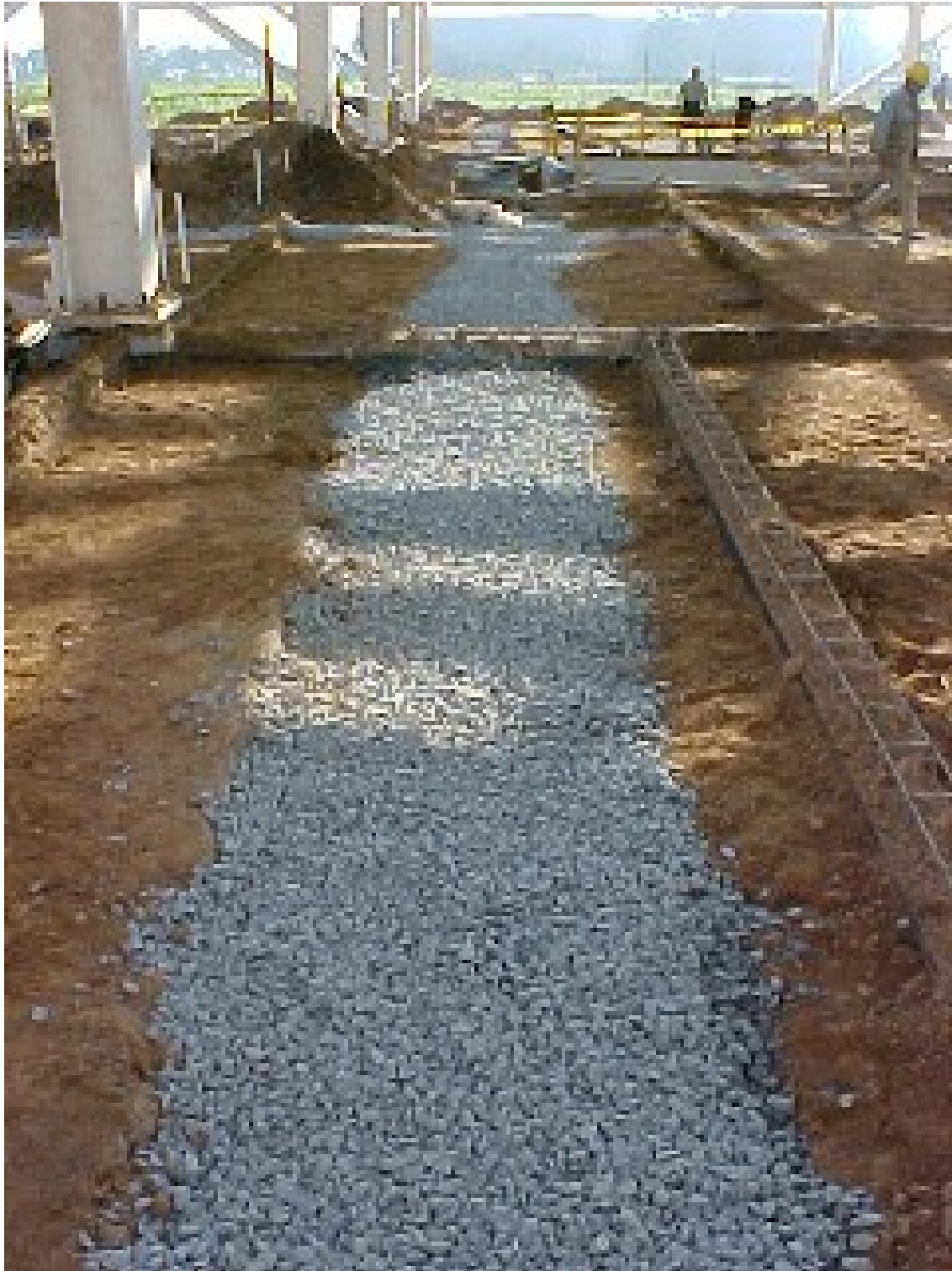
Ilustração 6-10 - Trincheira aguardando a execução de camada drenante sob a laje de piso armada.
