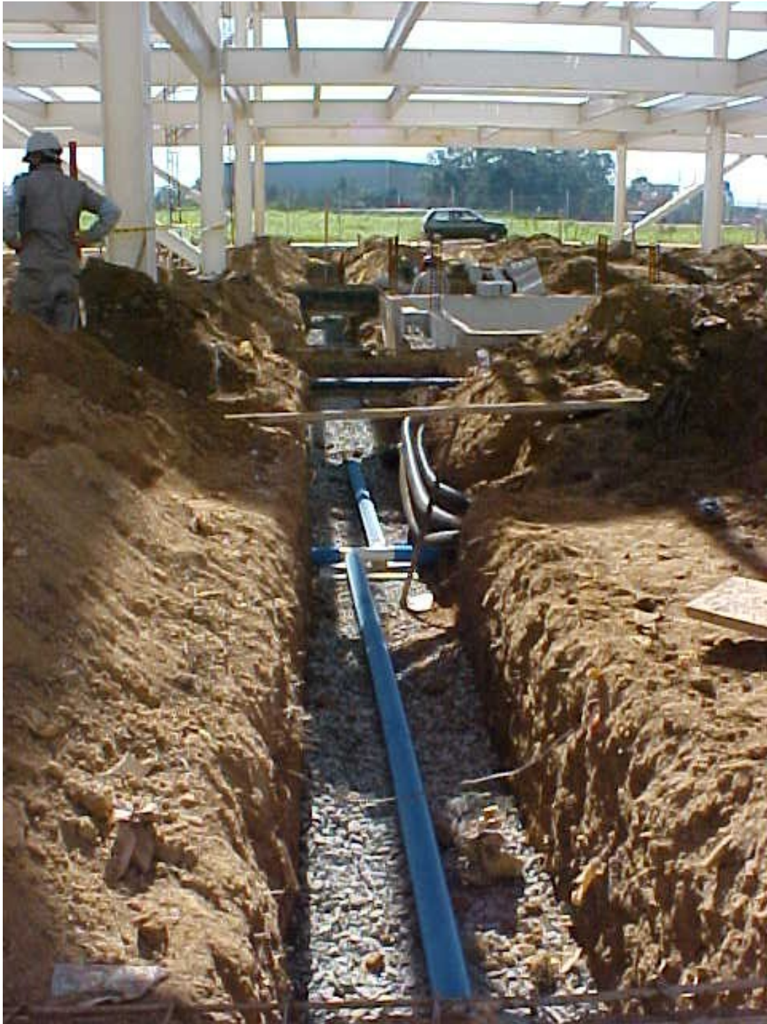
Ilustração 6-5 - Vista da trincheira e do cruzamento de drenos interligados. (Foto: Joaquin E. F. A. Oviedo)
