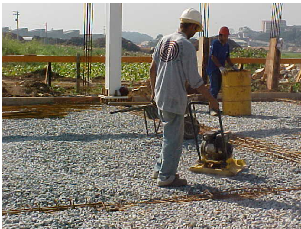
Ilustração 6-13 - Vista da execução de camada drenante sob a laje de piso armada. (Foto: Joaquin E. F. A. Oviedo)
