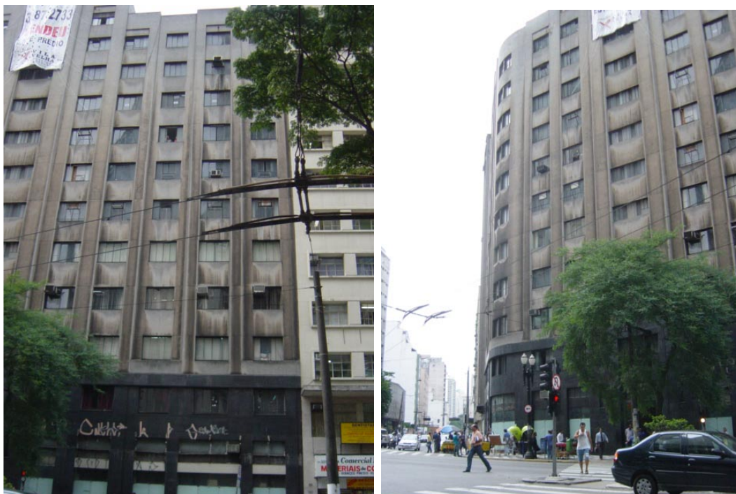
Figura 10 Vista do edifício São Bartholomeu antes da renovação
