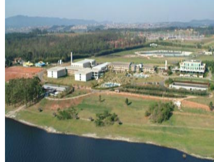
Figura 17: Vista aérea do empreendimento, Hotel Blue Tree Park.
