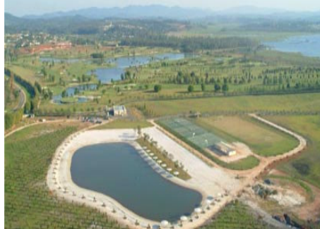
Figura 16: Vista aérea do empreendimento, Hotel Blue Tree Park.
