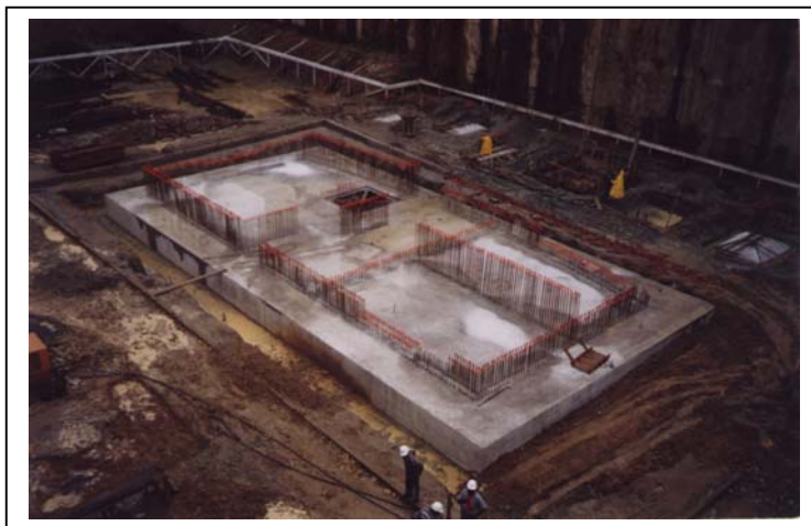
Figura 6 – Vista Panorâmica da Sapata e Arranques dos Pilares do Núcleo
