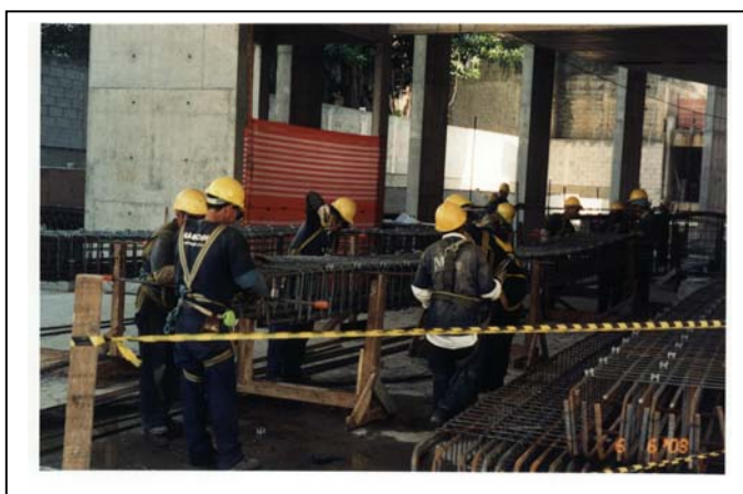
Figura 22 – Armação de Vigas na Bancada
