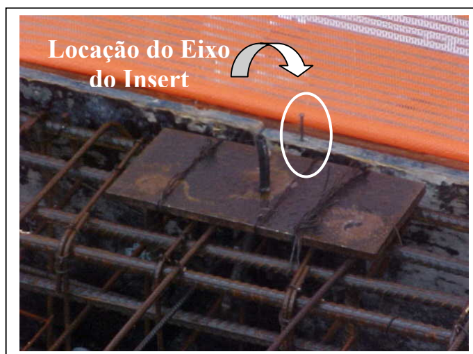
Figura 25 – Inserts Metálicos para a Fachada
