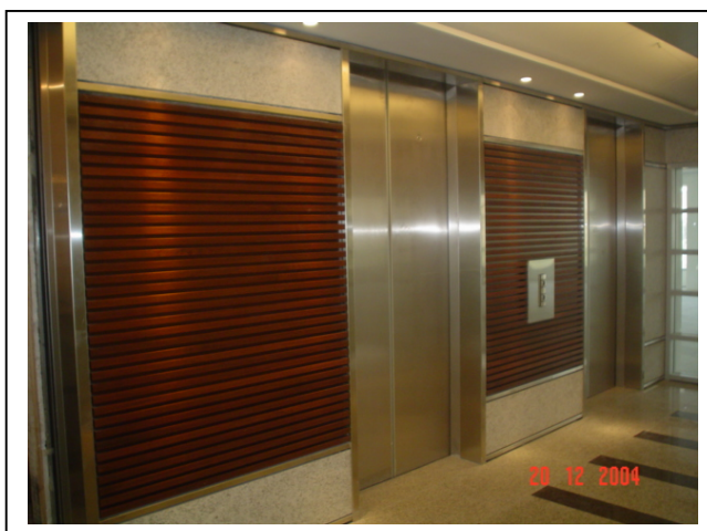
Figura 36 – Vista Parcial do Hall Acabado – Painéis Instalados
