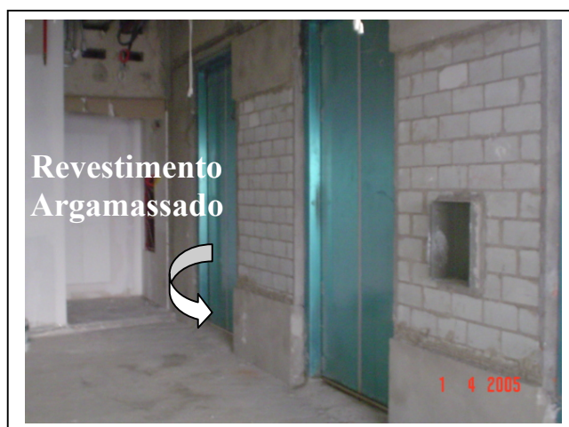
Figura 30 – Revestimento Argamassado das Paredes dos Halls
