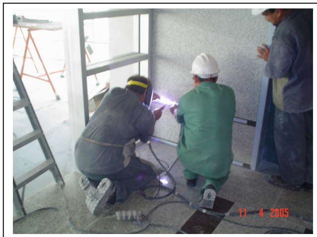
Figura 33 – Instalação de Frisos e Batentes em Aço Inox
