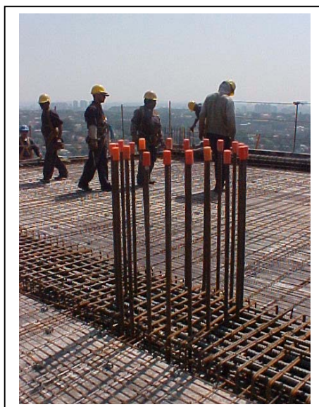
Figura 23 – Armação de Vigas de Grandes Dimensões
