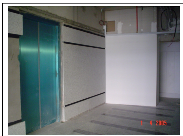
Figura 32 – Pintura na Região dos Frisos em Aço Inox
