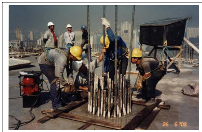
Figura 13 – Prensa da Luva no Arranque do Pilar – Segunda Etapa
