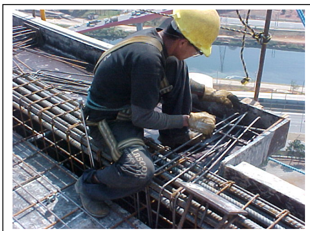
Figura 26 – Armação das Lajes de Borda
