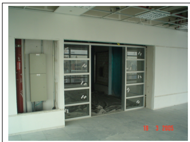
Figura 34 – Caixilho Principal de Acesso ao Pavimento
