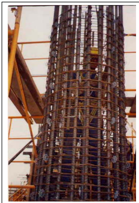
Figura 17 – Armação de Pilar com Alto Grau de Complexidade
