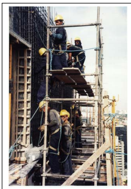
Figura 18 – Armação do Núcleo Central – Interligação das “Gaiolas”
