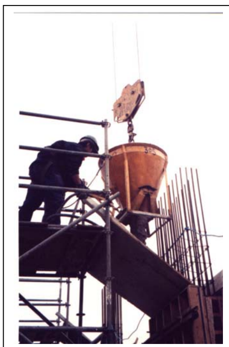
Figura 20 – Concretagem de Pilar Solteiro
