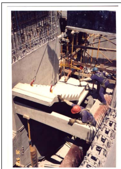
Figura 21 – Montagem da Escada Pré-Moldada
