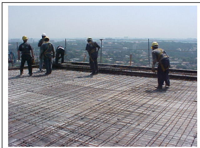
Figura 24 – Armação Positiva da Laje
