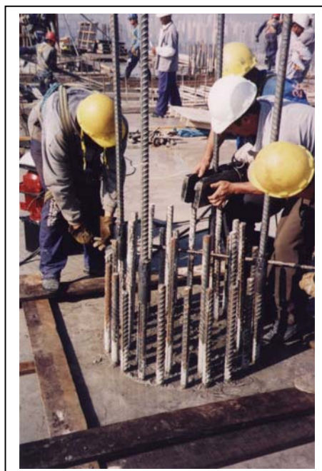
Figura 14 – Detalhe da Execução da Prensa da Luva
