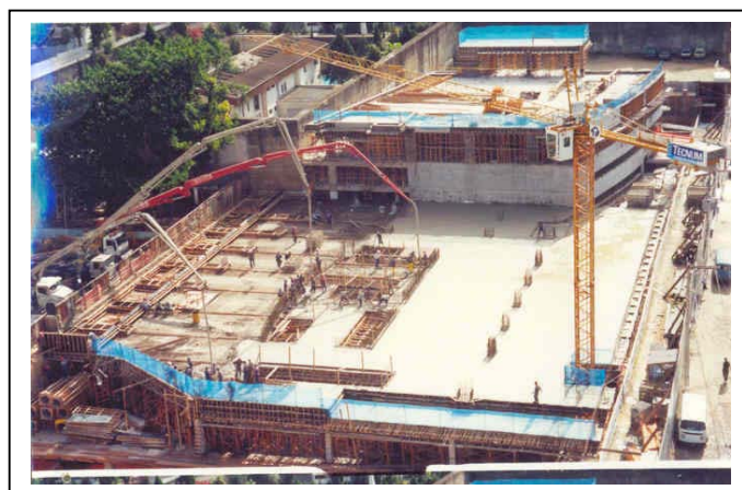
Figura 28 – Concretagem da Laje do Térreo
