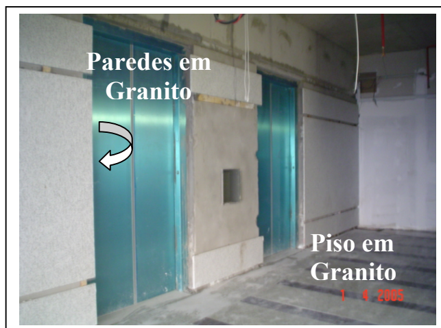
Figura 31 – Piso e Paredes em Granito Executados
