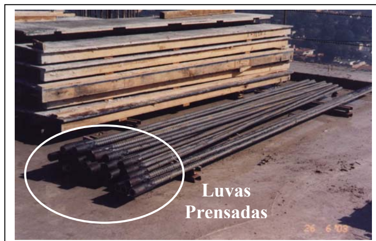
Figura 11 – Barras com Luvas Prensadas – Primeira Etapa
