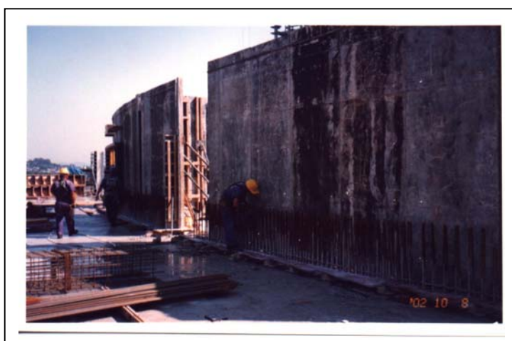
Figura 16 – Fôrma do Núcleo
