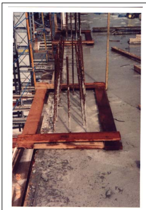
Figura 12 – Execução de Ganchos
