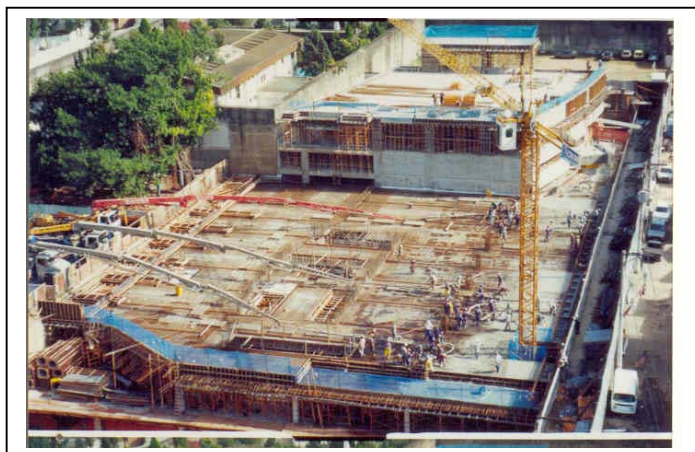
Figura 27 – Início da Concretagem da Laje do Térreo
