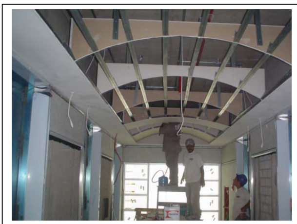
Figura 35 – Execução das Sancas e Forro Calandrado
