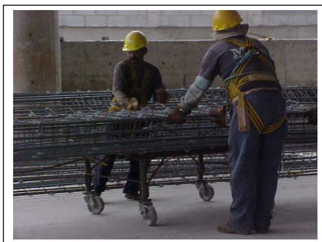
Figura 44 – Transporte de Peças Pré-Armadas na Bancada
