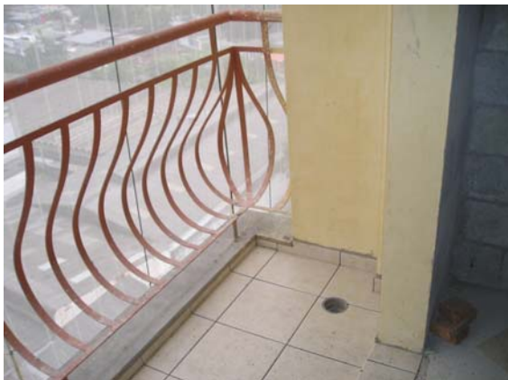
Varanda rebaixada com relação a sala
