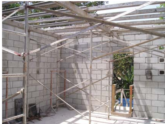
Escoramento metálico para laje Subsolo
