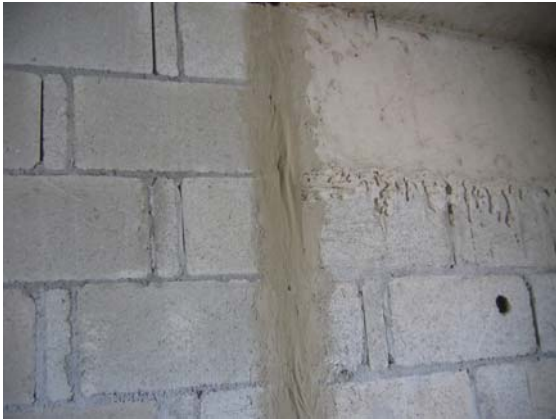
Viga sacada ,detalhe junta alvenarias
