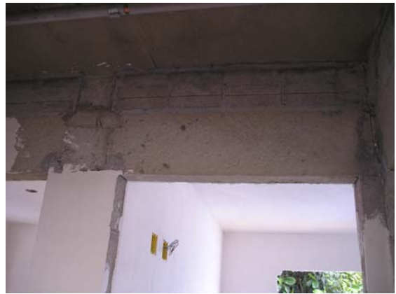
Verga pré-moldada para porta de dormitório
