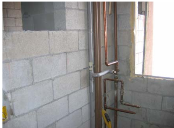
Detalhe prumada do aquecedor de passagem
