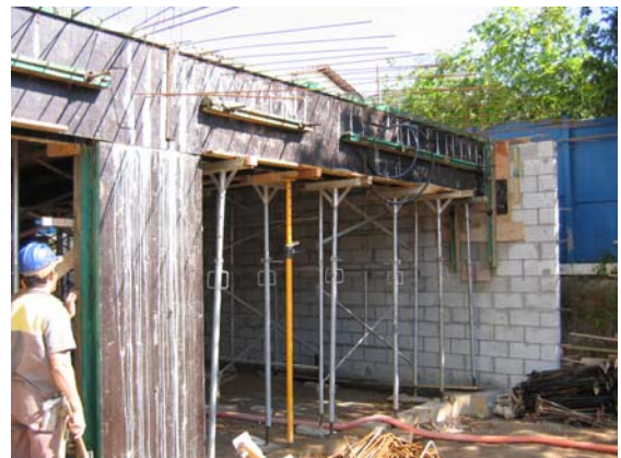
Detalhe concreto armado e alvenaria estrutural
