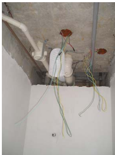
Previsão fechamento forro
