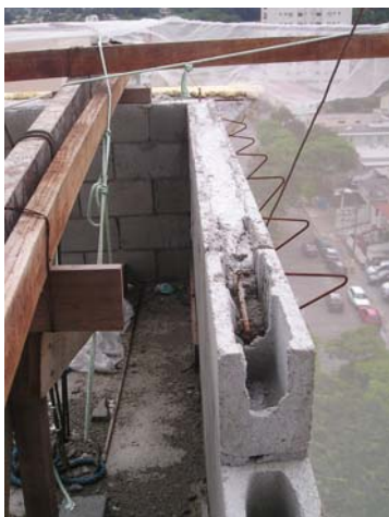
Bloco canaleta da platibanda
