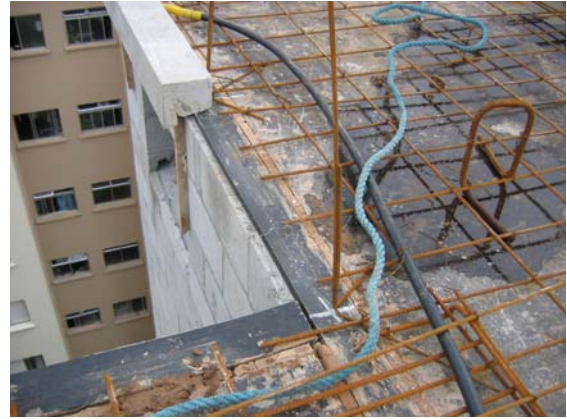
Suporte de borracha para laje Cobertura
