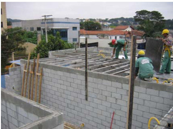
Montagem de assoalho na laje Tipo
