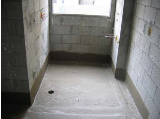
Pontos embutidos em alvenaria de vedação
