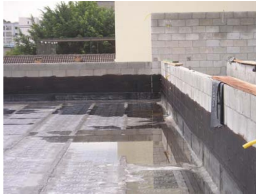
Muros em alvenaria estrutural
