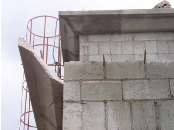
Amarração da cimalha no bloco canaleta
