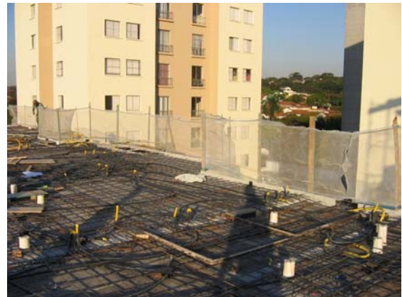
Armação de laje com gabarito p/rebaixo
