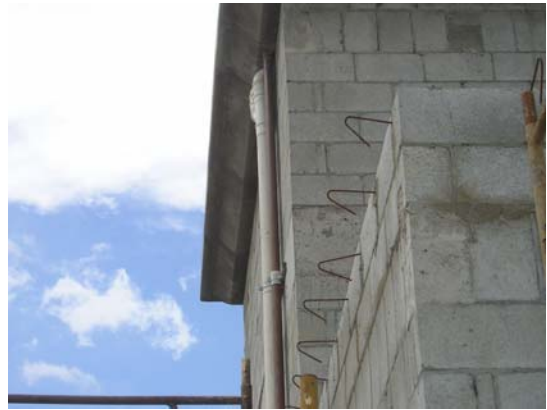
Esperas de aço para amarração da cimalha
