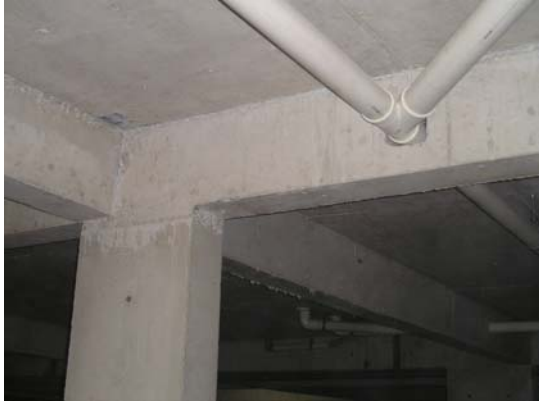
Previsão de passagem de tubulação hidr.
