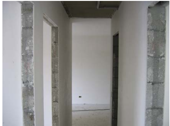
Aplicação de gesso liso em paredes
