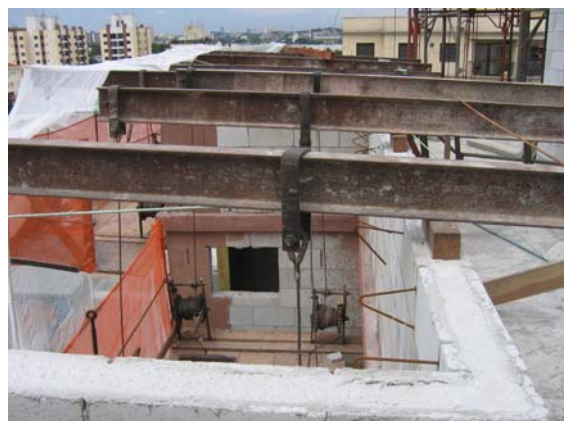
Apoio do balancim fachadeiro na platibanda
