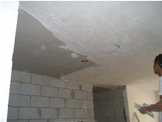
Aplicação de gesso liso em teto
