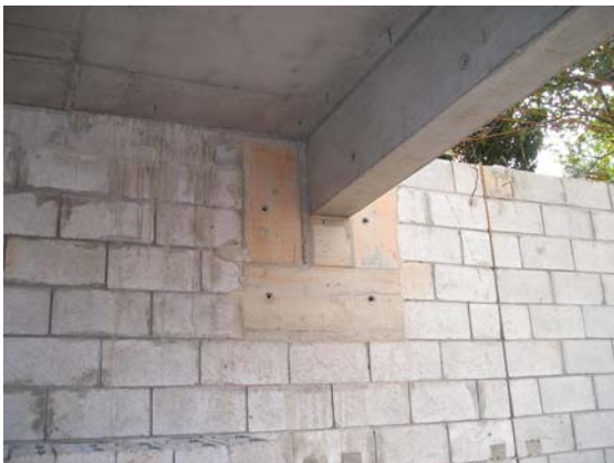
Detalhe muro lateral com apoio de viga
