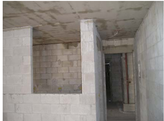
Obra bruta, cozinha com parede aberta
