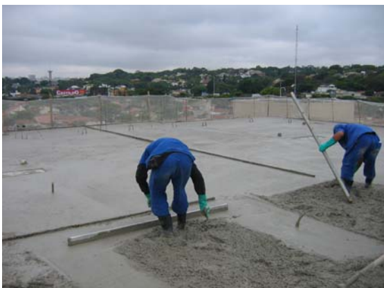
Laje de Cobertura, previsão ralos técnicos
