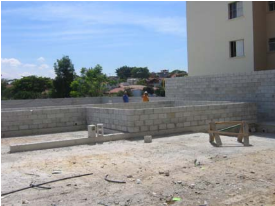
Piscina em alvenaria estrutural
