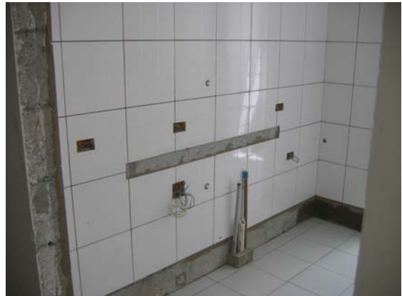
Azulejo de cozinha, espaço p/ pia granito
