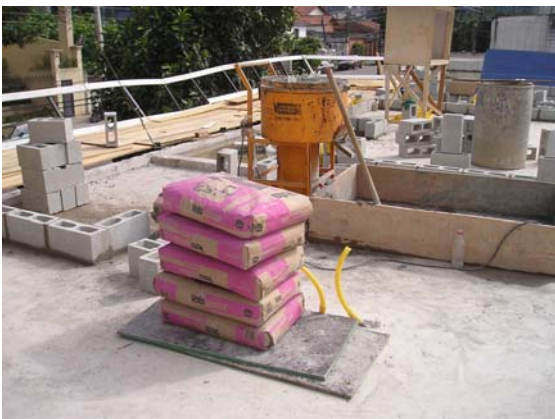
Argamassa assentamento e misturador
