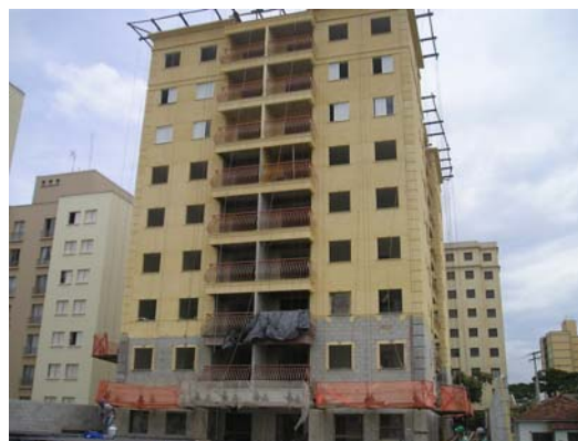
Foto fachada posterior – Fev./2006
