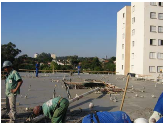
Laje acabada ( nível zero ) pavimento Tipo
