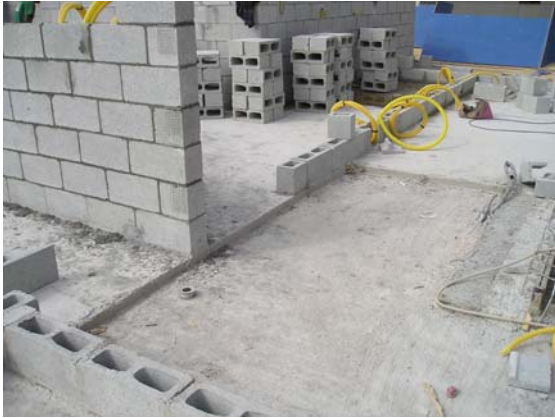
Rebaixo na laje para hall dos elevadores
