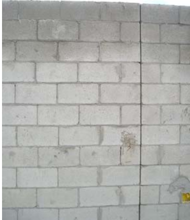
Dilatação para muros
