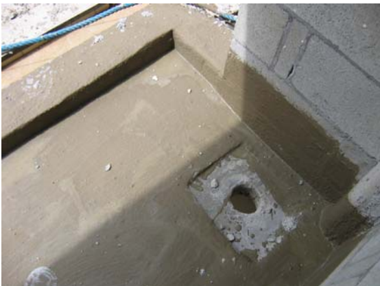
Laje sacada c/ rebaixo e impermeabilizada
