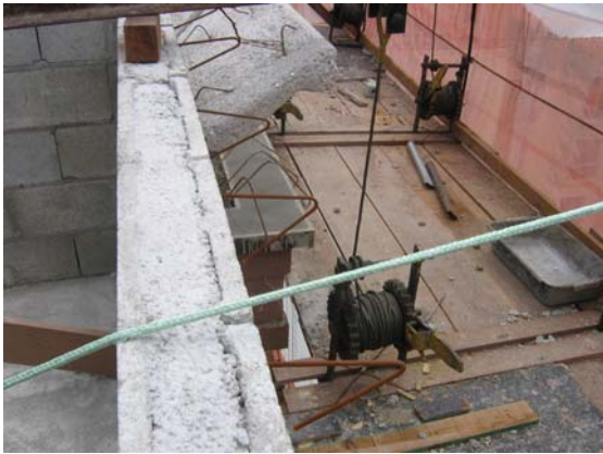
Detalhe cimalha na platibanda Cobertura
