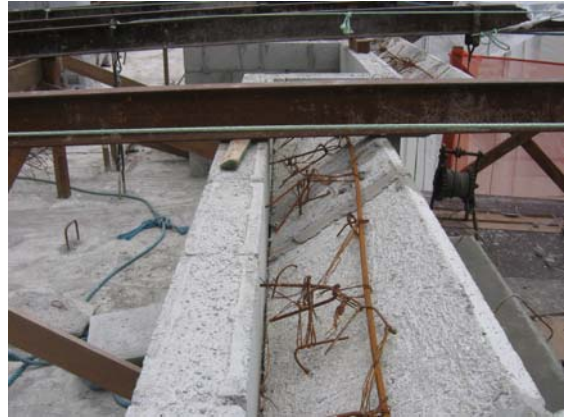
Amarração gancho alvenaria com a cimalha
