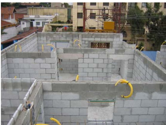
Vergas portas e alvenaria da última fiada
