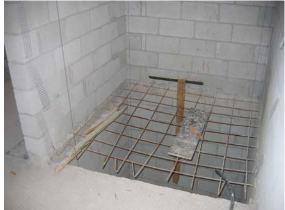
Caixa de elevador em alvenaria estrut.c/ proteção
