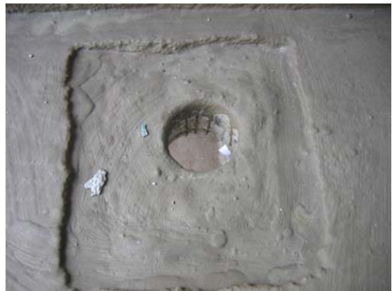
Detalhe para manta asfáltica - virar no ralo
