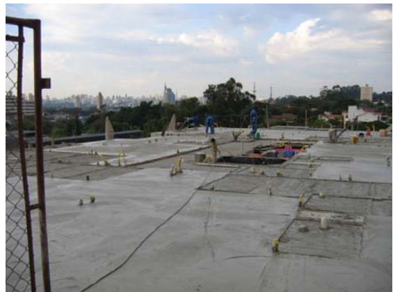
Laje acabada com rebaixo p/ cozinha e wc
