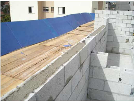
Verga inferior de janelas com bloco canaleta
