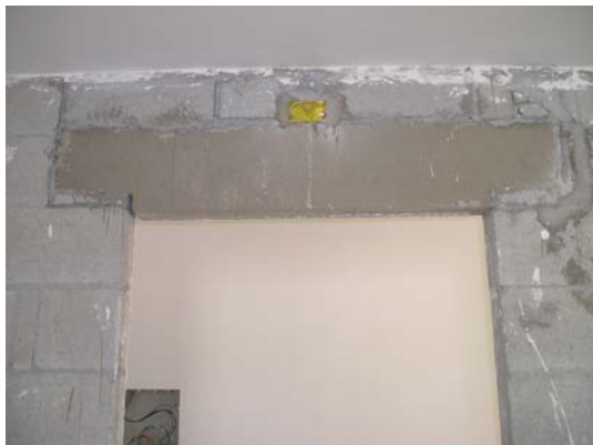
Verga pré-moldada para portas internas
