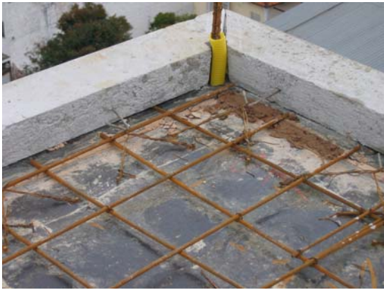
Detalhe peça pré-moldada laje Cobertura
