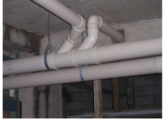
Previsão de passagem na viga do Subsolo
