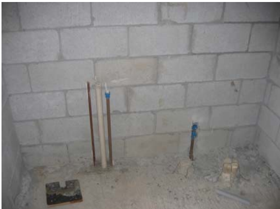
Pontos para lavatório e bacia sanitária
