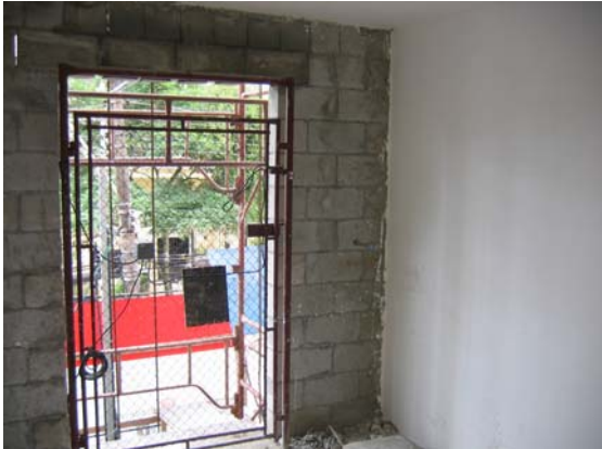
Porta elevador no andar Tipo (dormitório)
