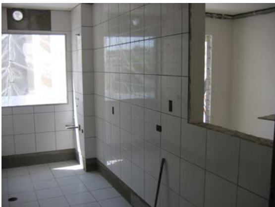
Azulejo colado sobre o bloco
