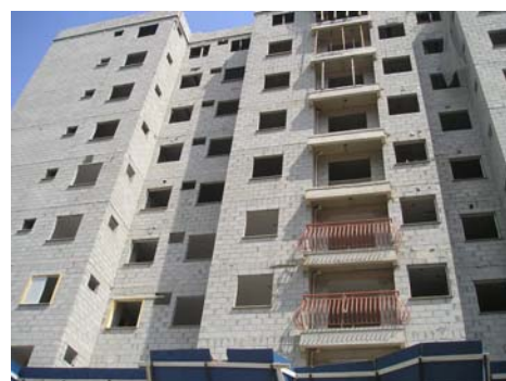
Foto - Vista lateral do Edifício Green Park
