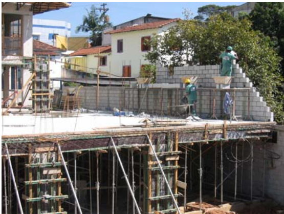
Muro de divisa lateral em alvenaria estrutural
