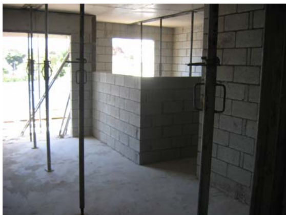
Elevação da alvenaria (opção c/ 3 dorm)
