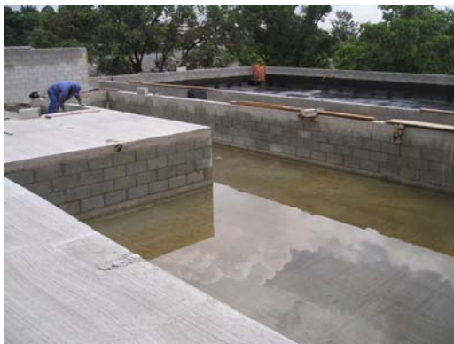
Piscina em blocos de alvenaria estrutural
