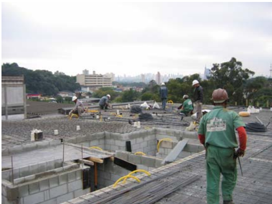
Armação de laje do pavimento Tipo
