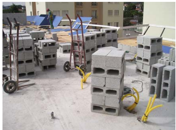
Blocos estruturais e carrinhos para transporte
