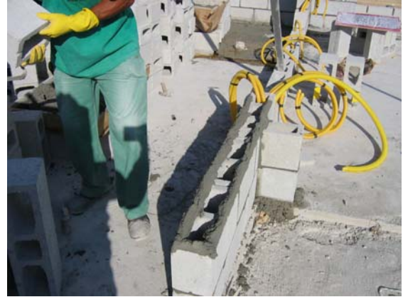
Detalhe rebaixo, elevação da alvenaria
