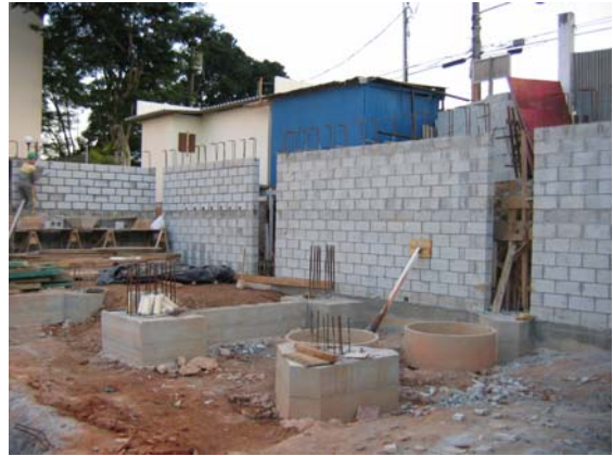
Cortina de Subsolos com pilares integrados
