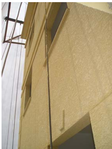
Fachada em revest. Monocapa
