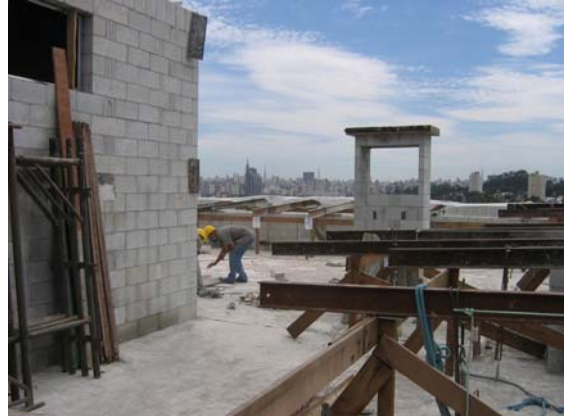
Vista alvenaria do Ático, laje Cobertura
