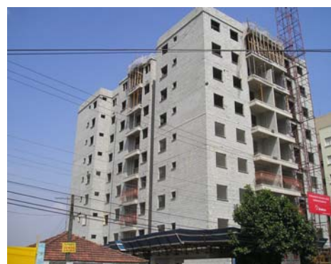
Foto – Vista da Fachada e lateral , (estrutura concluída dez/2005 )
