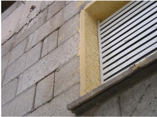
Pingadeira pré-moldada para janelas
